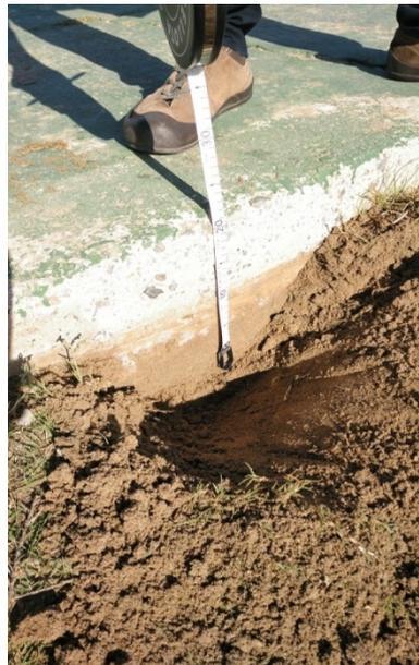
**ESPESOR LOSA HORMIGÓN 25 CM**
