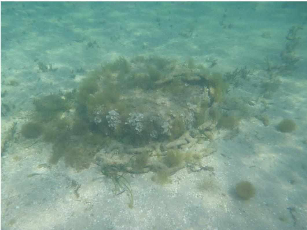
**Figura 16.** Lastre abandonado mediante el uso de neumático relleno de hormigón y cadena.
