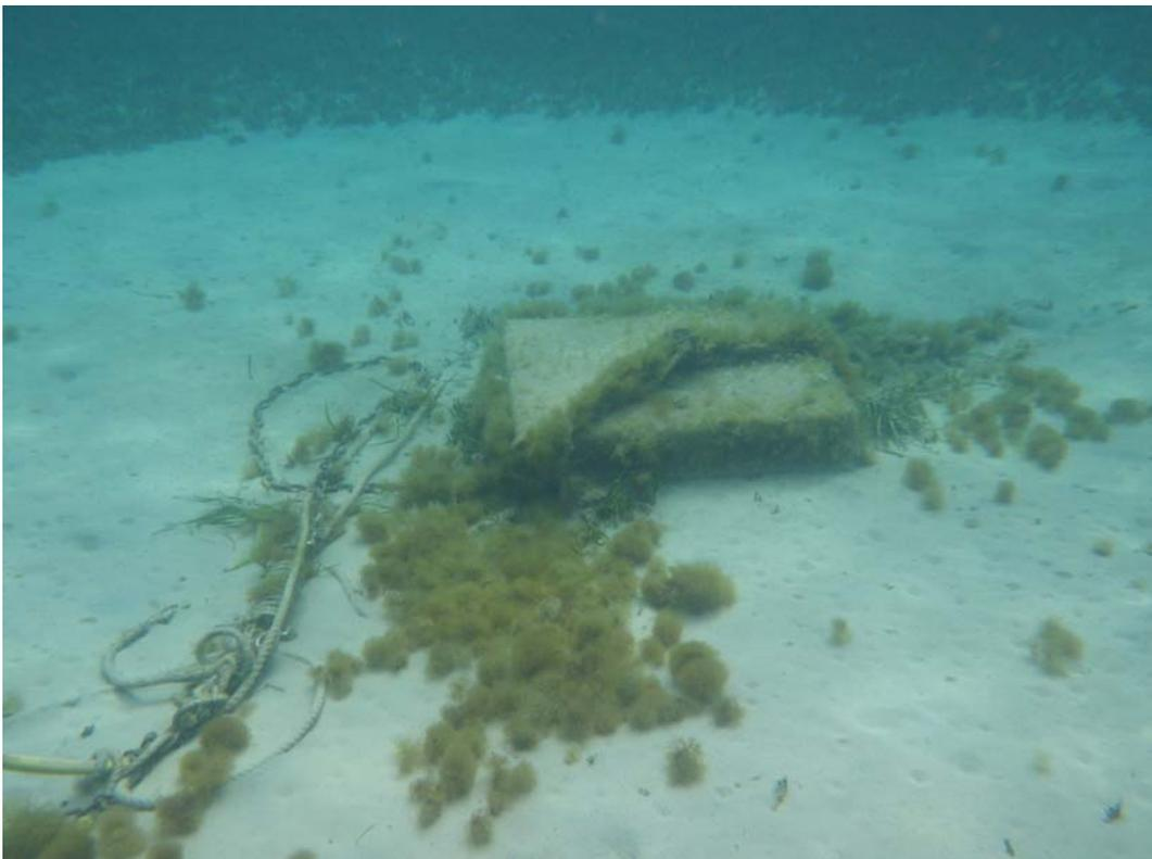
**Figura 20.** Lastre de hormigón con cadenas y cabos
