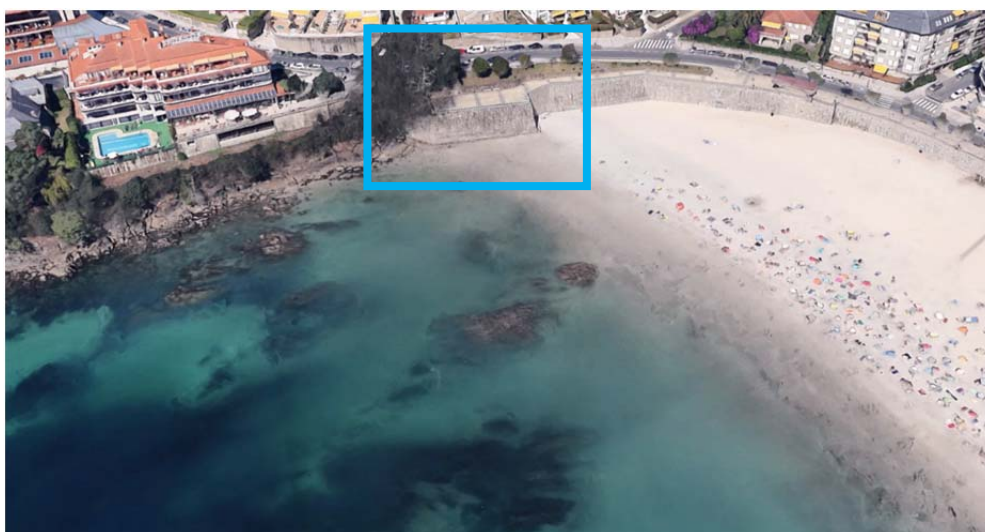
Estado actual mirador
