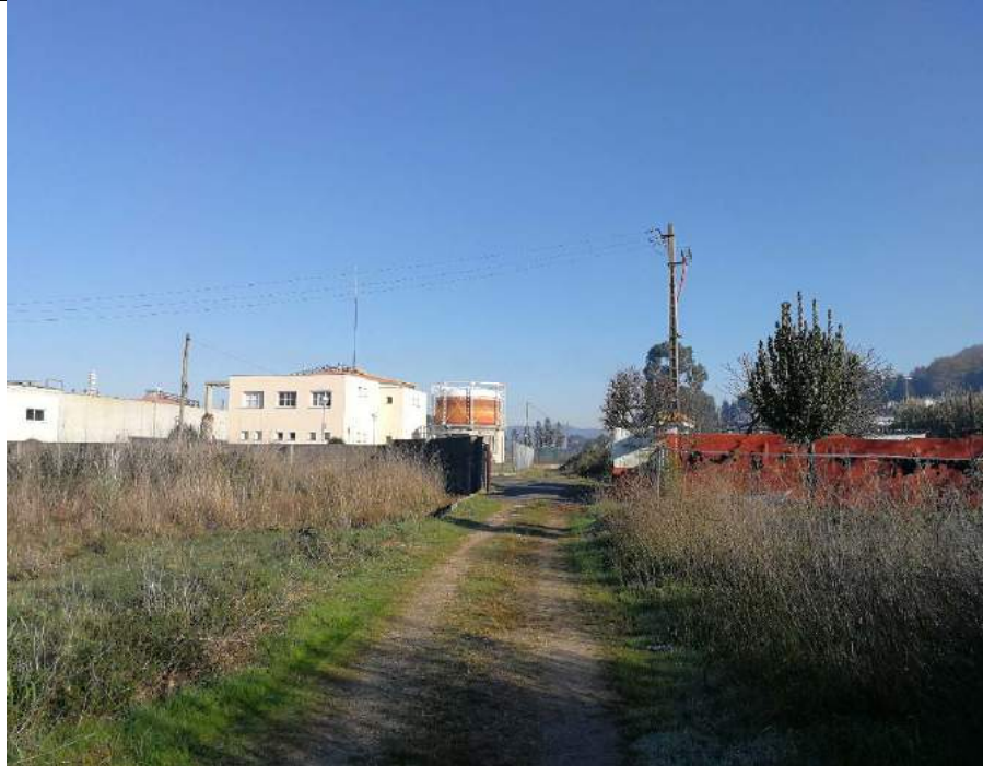
Vista camino existente hacia entrada depuradora
