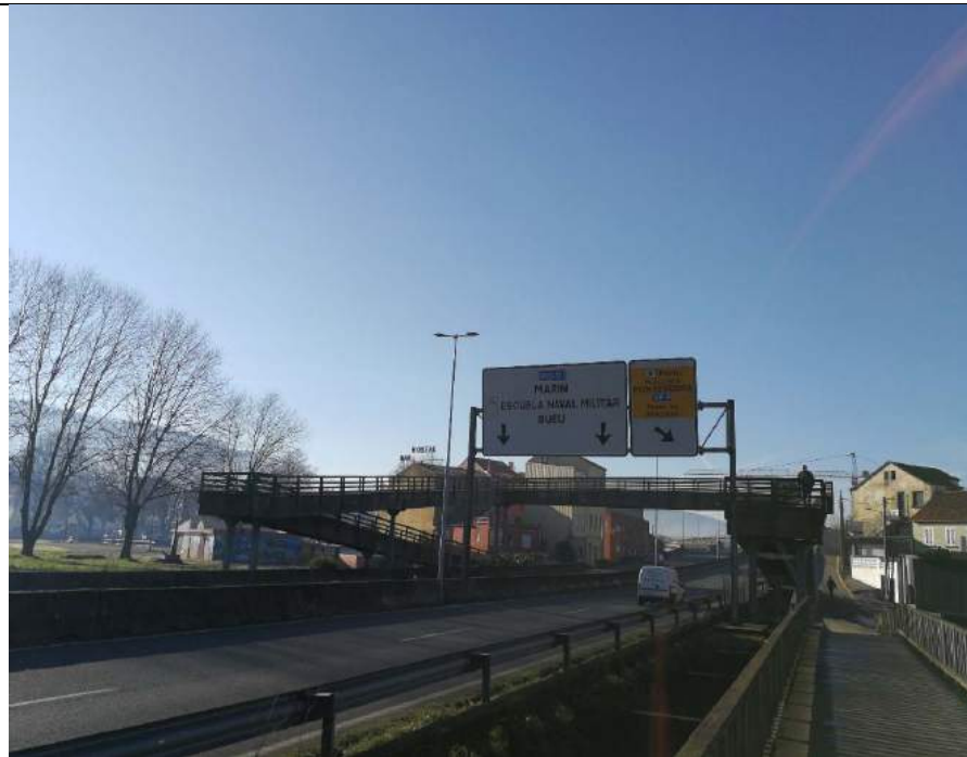
Vista de la pasarela de comunicación
