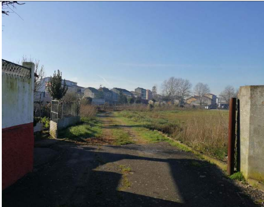
Vista entrada depuradora
