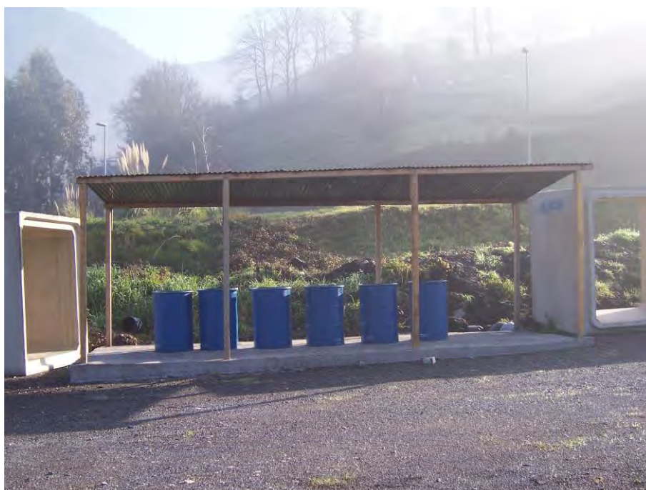
Ilustración 2. Punto limpio en construcción.
