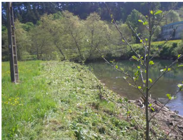
Plantación de arbolado de ribera en el cruce del río Oria
