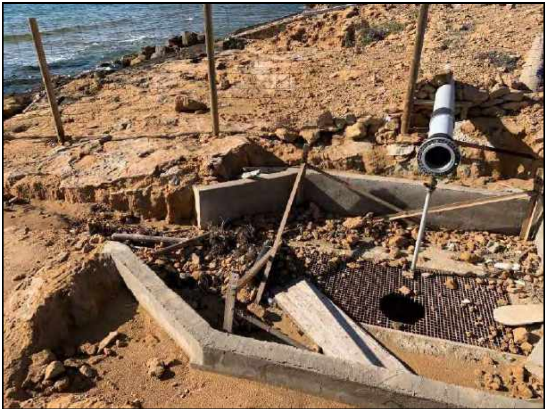
Estado actual de las arquetas y tuberías.
