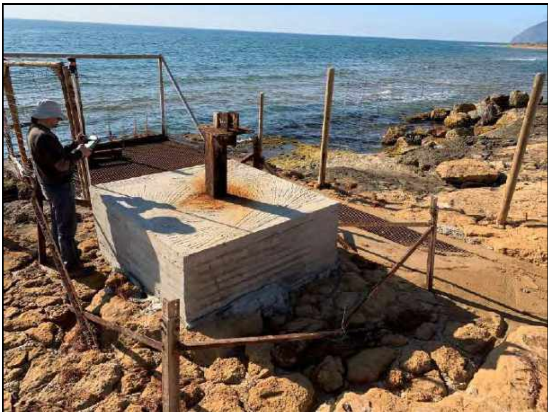
Toma de datos de las instalaciones actuales.
