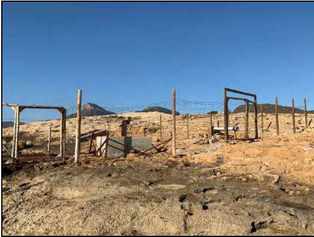
Zona de arquetas de captación cerrada con valla.
