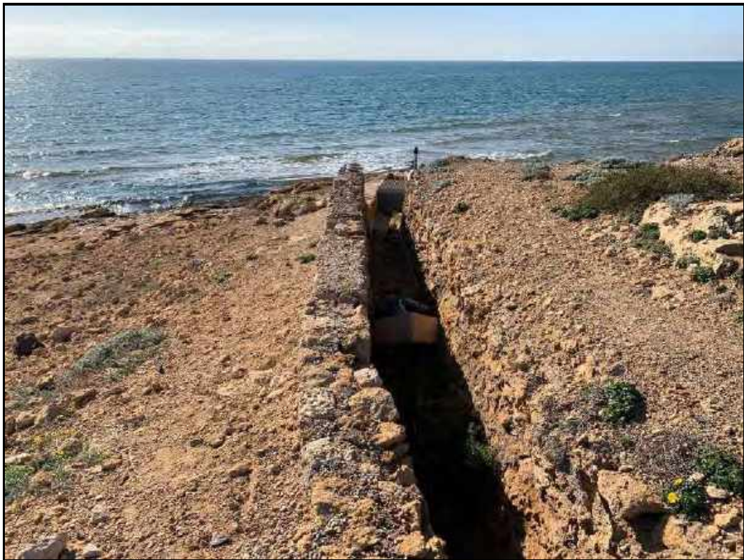
Estado actual de zanja existente desde arqueta.
