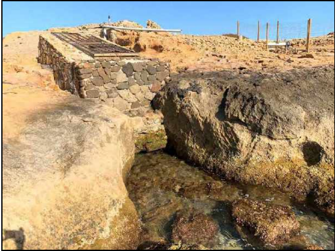
Zona de entrada de agua.
