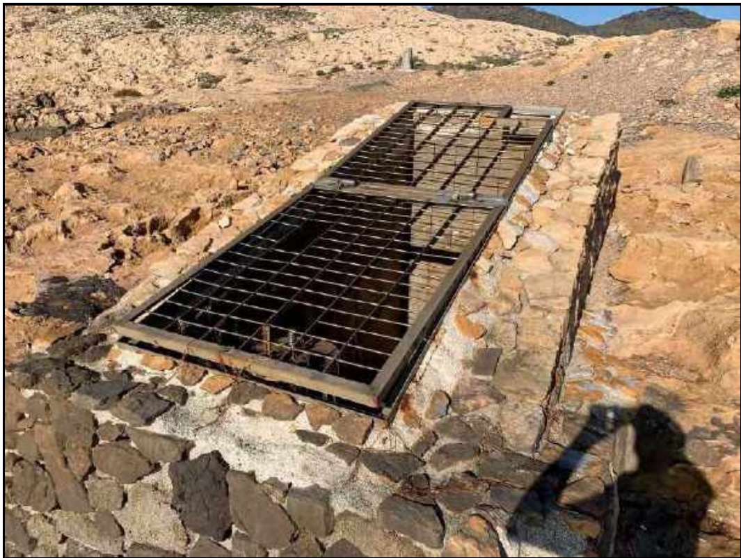
Estado actual de la arqueta de bombeo.
