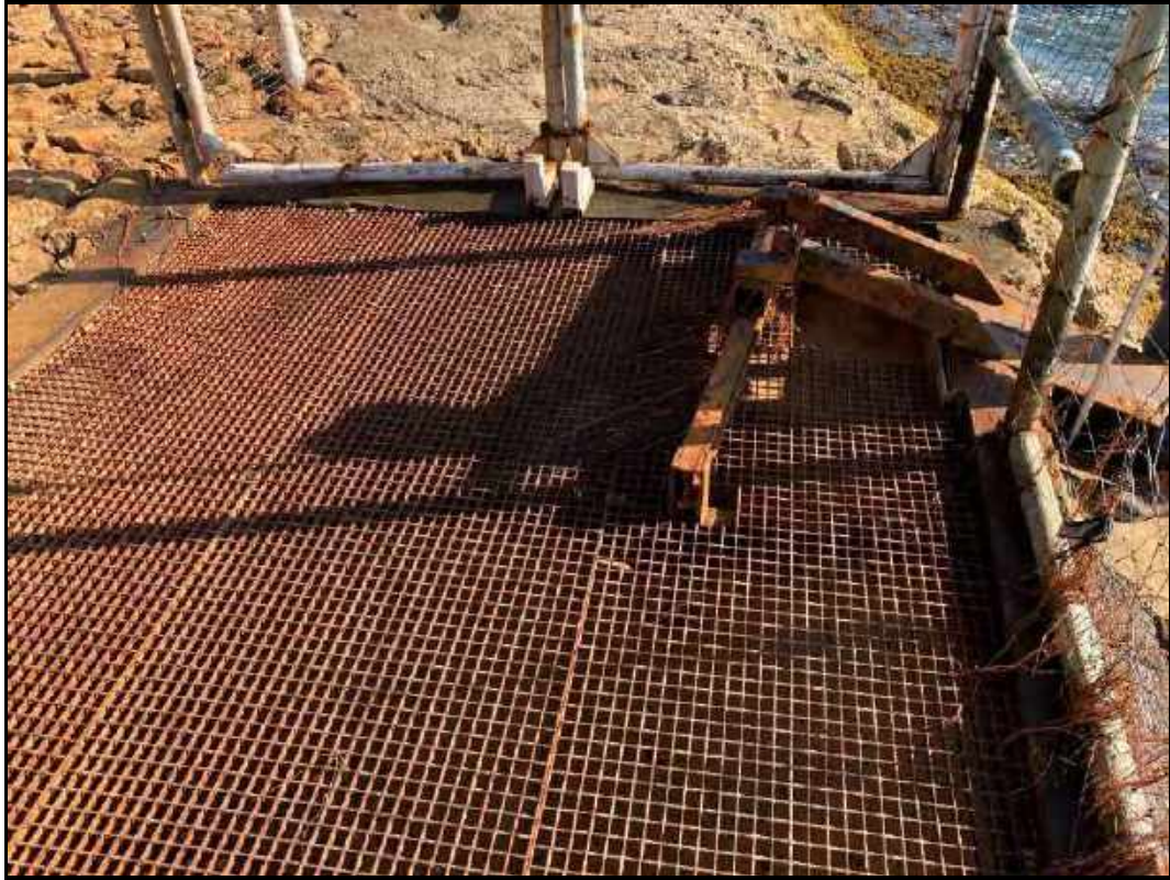
Estado actual de la reja de protección de la arqueta.
