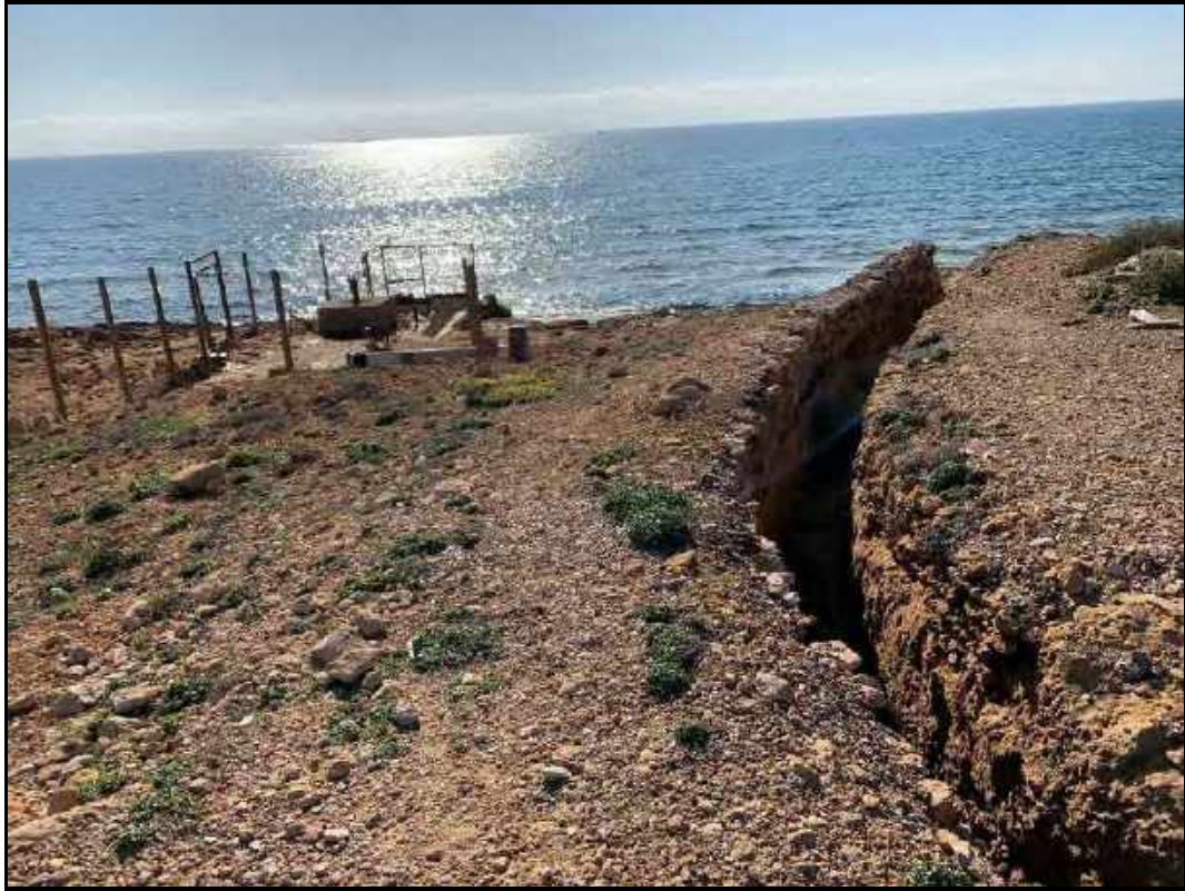
Estado actual de zanja existente desde arqueta.
