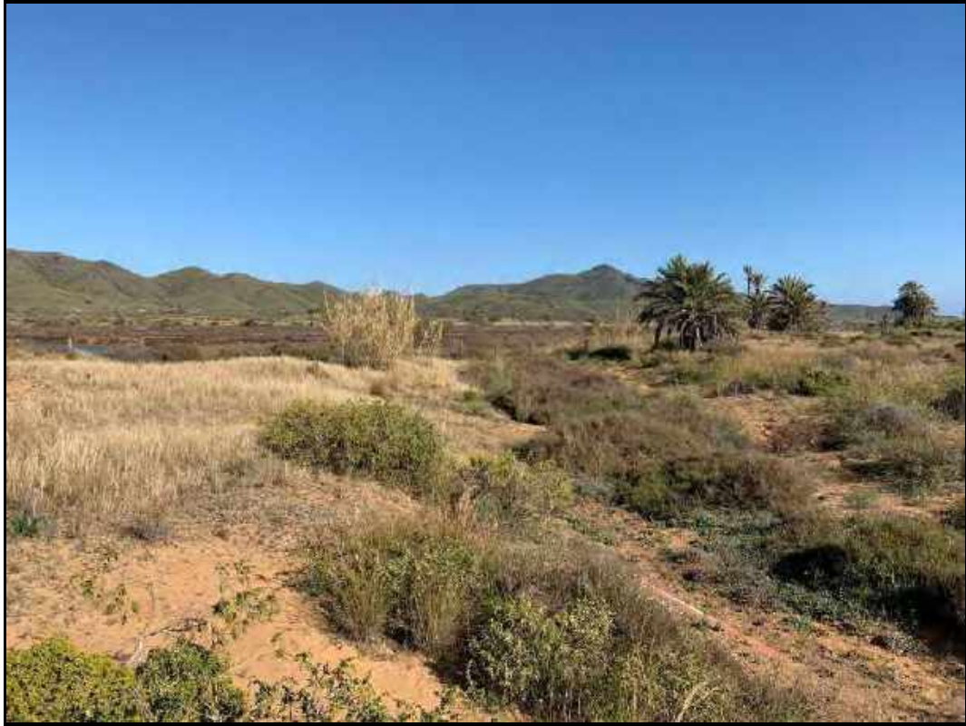
Traza actual de la tubería existente. Tramo de tubería de PVC al aire.
