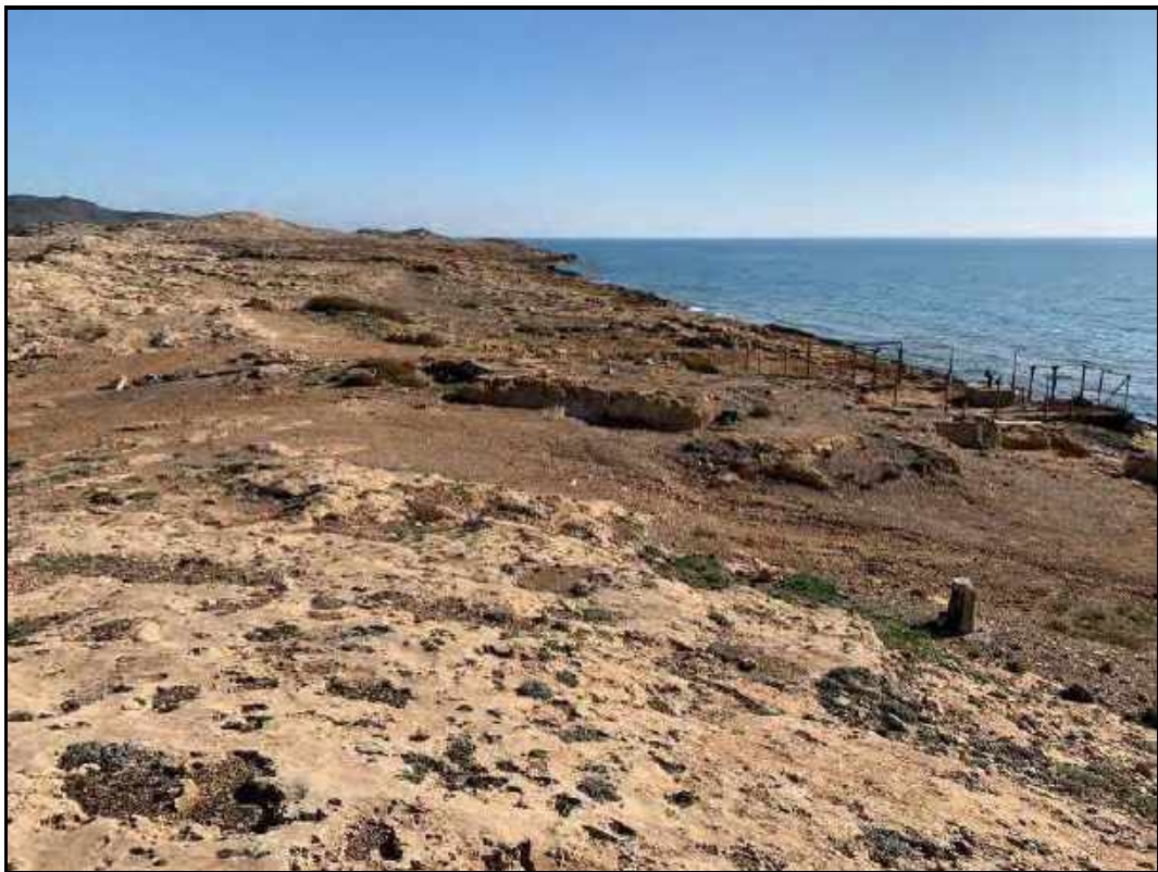
Vista de las instalaciones actuales de toma de agua, elevación y traza a las salinas.
