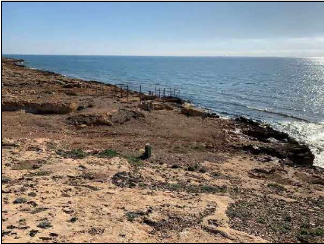
Vista de las instalaciones actuales de toma de agua y elevación a las salinas.
