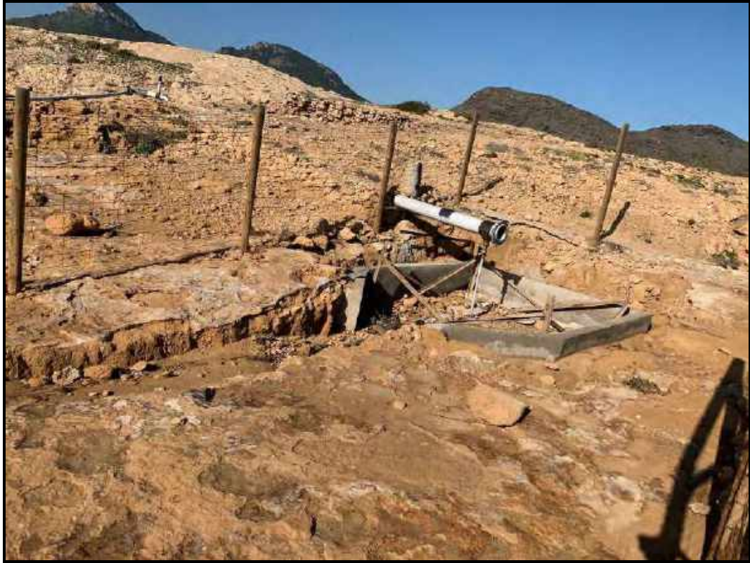
Estado actual de las arquetas y tuberías.
