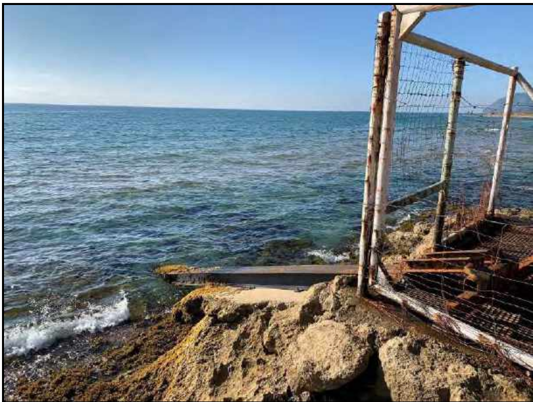
Estado de zona de captación actual.
