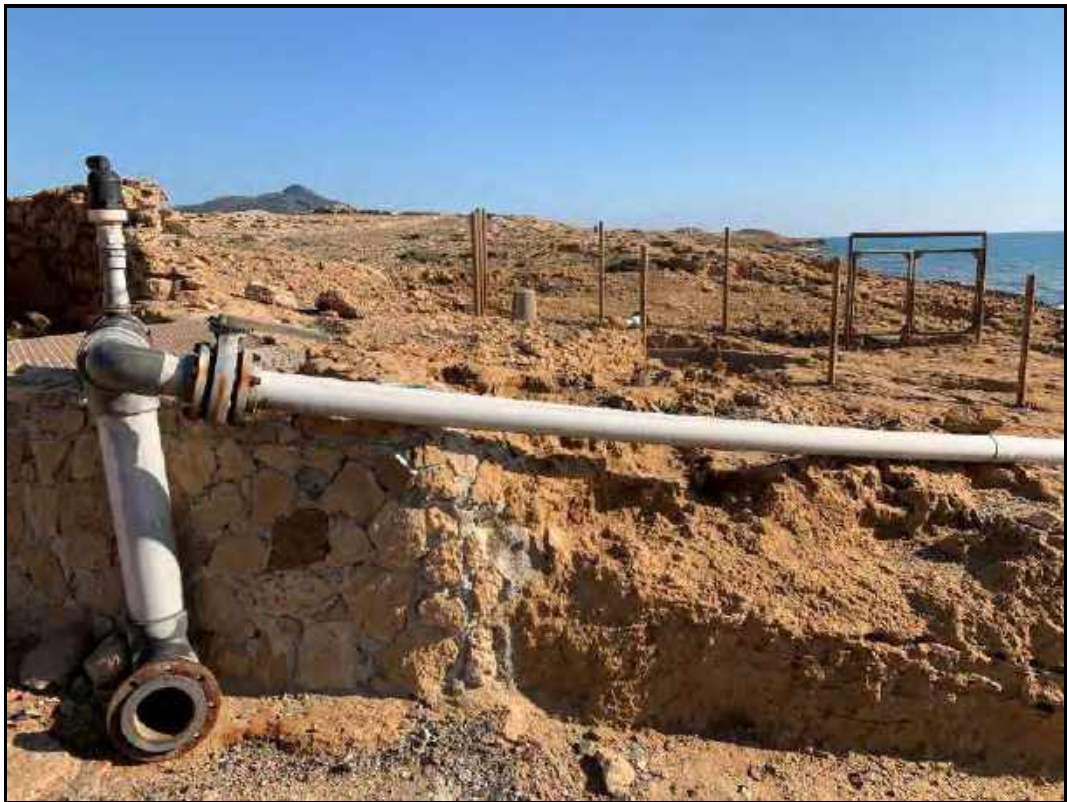
Estado actual de las tuberías exteriores de la instalación.
