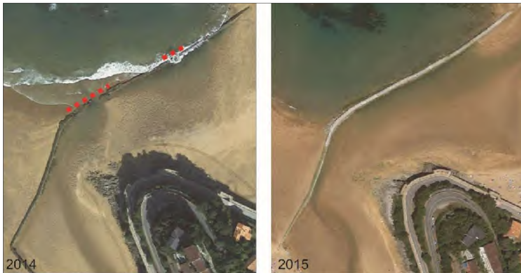
Figura 4.2 –Malecón de Lazunarri, antes y después de su reparación
