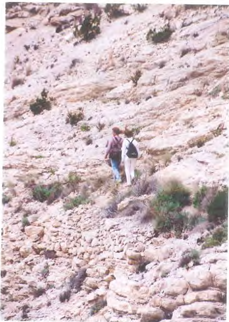
FOTO 1. Aspecto de la ladera en la cual se pretende ejecutar la obra de acondicionamiento del antiguo camino. En la imagen puede apreciarse el mal estado del vial en la actualidad. La vegetación litoral está dispersa sobre el terreno, de gran pendiente y con clara erosionabilidad.
