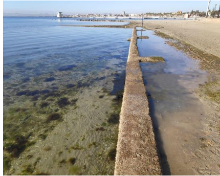
Imagen 1_Muro separador zona seca- zona de baño. Anclaje de estructura
