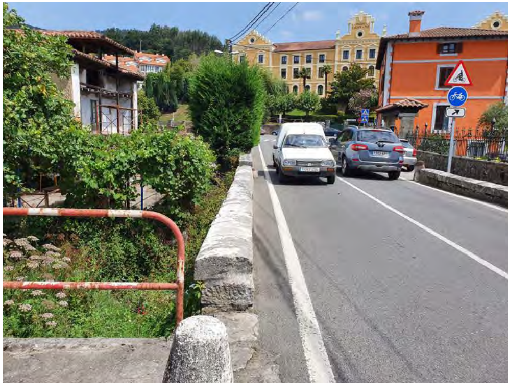
Imagen 7. El cruce de dos vehículos deja escaso margen al paso peatonal seguro.
