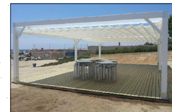
Pérgola plana de 7,00x5,00m, con lona corredera, anclada de forma superficial con pilares mediante soportes metálicos de acero galvanizado a la tarima apoyada sobre la arena
