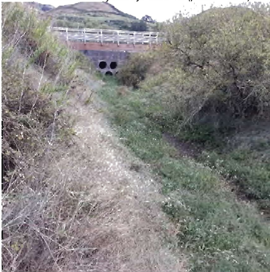
Foto 13: Marea baja aguas abajo paso carretera
