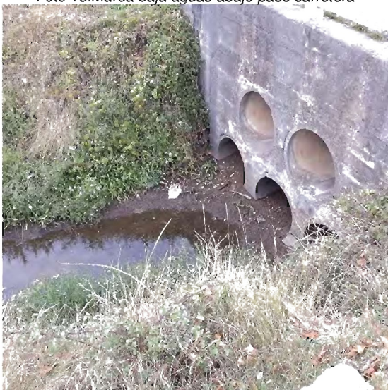
Foto 15: Marea baja aguas abajo paso carretera
