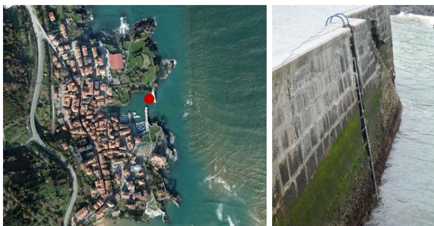
Figura 3.3.- Emplazamiento e instalación de la sonda 1
