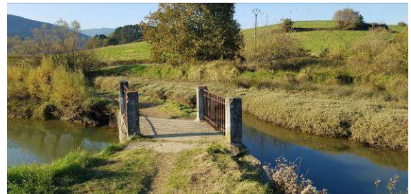
Puente de hormigón en O1
