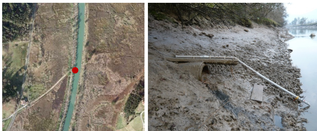
Figura 3.7.- Emplazamiento e instalación de la sonda 5
