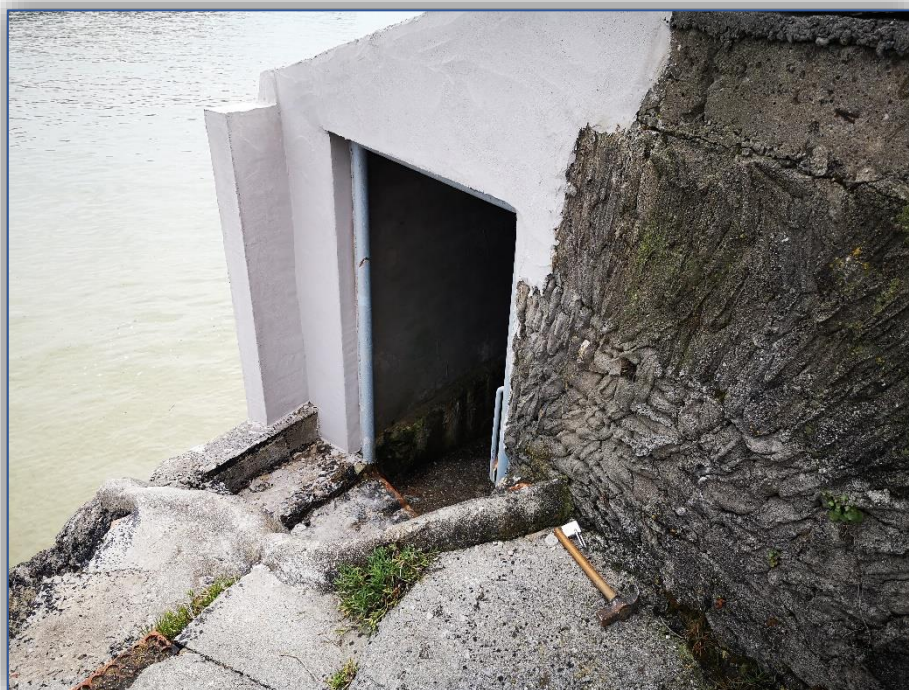
Imagen 04. Acceso cetárea – elemento 1
