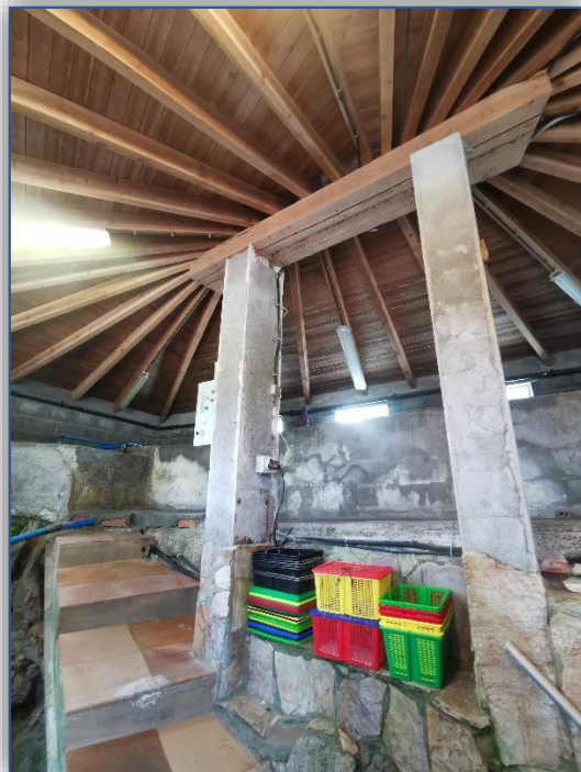
Imagen 08. Interior cetárea – elemento 2 – detalle pilares y forjado
