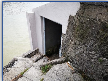
Imágenes 03-04.- Exterior de las cetáreas
