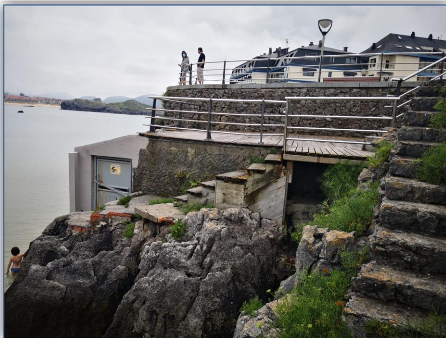
Imagen 01. Vista cetárea – elemento 1 -desde su lado noroeste
