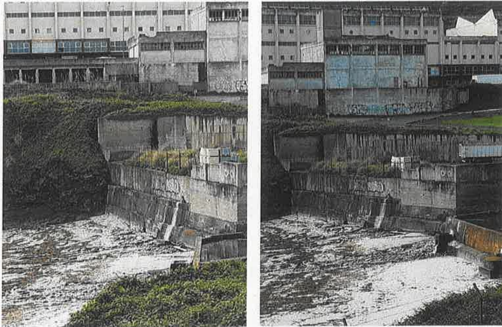
Fotografía 1: Detalle de muros y relleno ocupación zona DPMT
