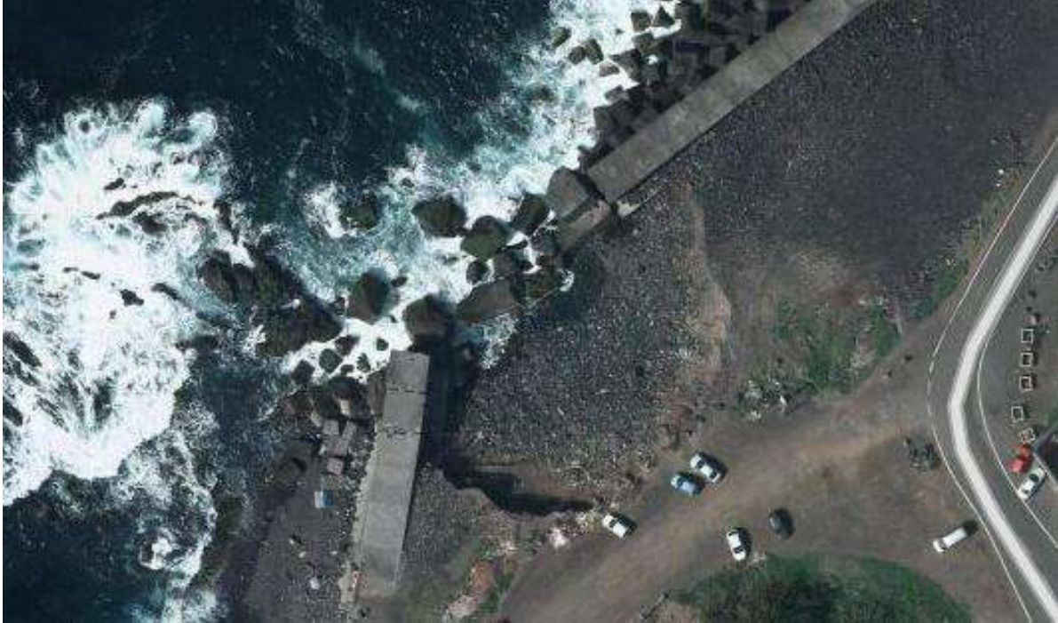
Depósitos de playa depositados en la zona de rotura del dique
