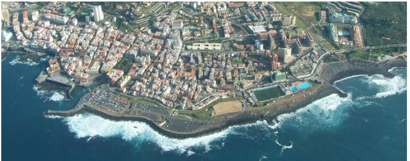
Foto aérea lateral del frente costero del parque marítimo.
