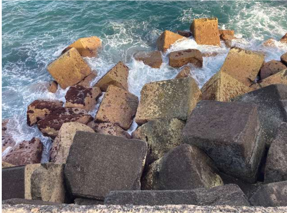
Imágenes actuales de la zona de reparación, taludes del socavón al relleno existente y escasos bloques de protección de 25-30 tn al pie del espaldón coronado a la cota +10
