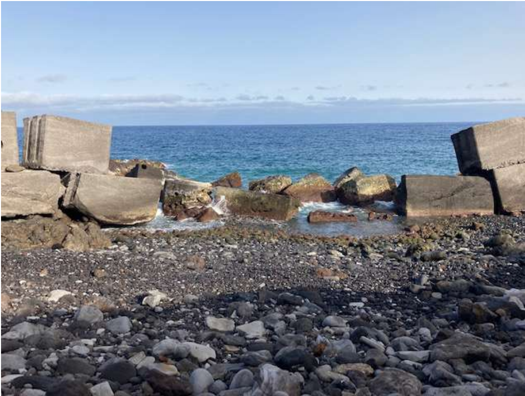
Imágenes actuales de la zona de reparación, bloques movidos del espaldón y falta de bloques de protección en el frente marítimo
