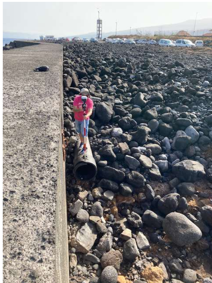
Fotografía 3.2. Toma de instalaciones a reponer
