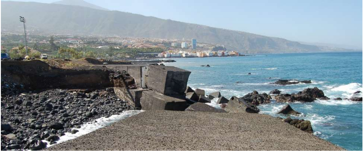
Afloramiento de las coladas de traquibasalto en la zona del Picacho del Mero
