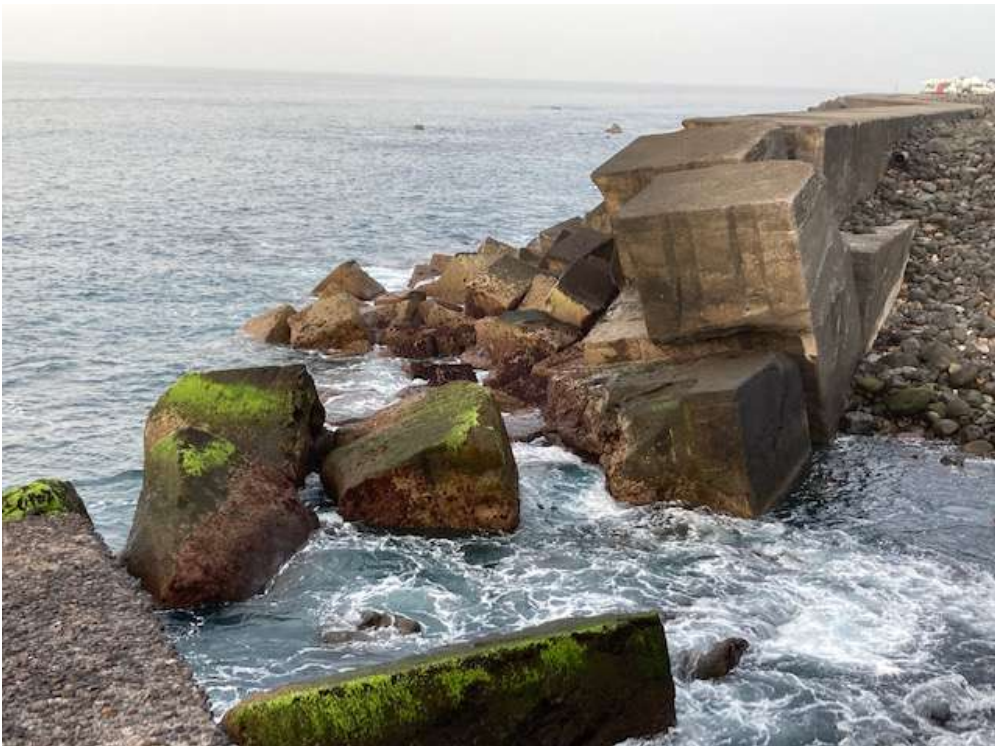
Imágenes actuales de la zona de reparación con bloque de gran peso del espaldón
