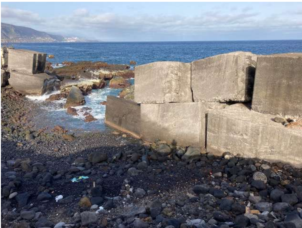
Imágenes actuales de la zona de reparación, bloques movidos del espaldón y falta de bloques de protección en el frente marítimo
