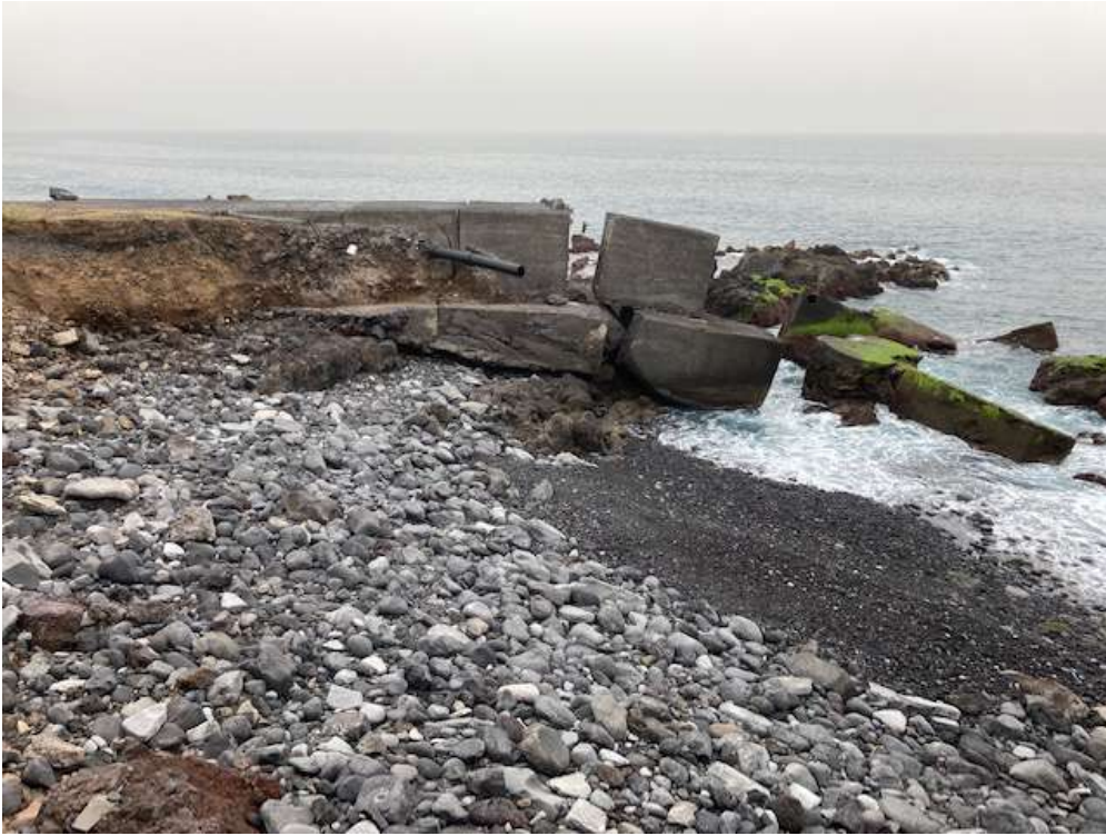
Imágenes actuales de la zona de reparación con bloque de gran peso del espaldón
