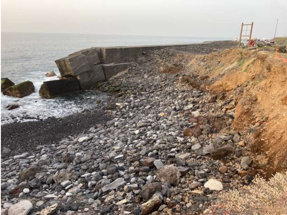
Imágenes actuales de la zona de reparación, taludes del socavón al relleno existente y escasos bloques de protección de 25-30 tn al pie del espaldón coronado a la cota +10
