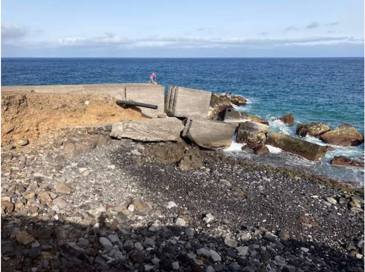
Fotografía 3.3. Toma de estado actual bloques.
