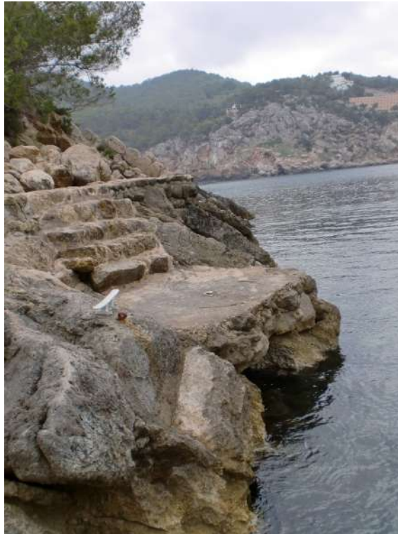
Fotografía 2.- Escaleras de acceso al embarcadero y superficie de hormigón del embarcadero.
