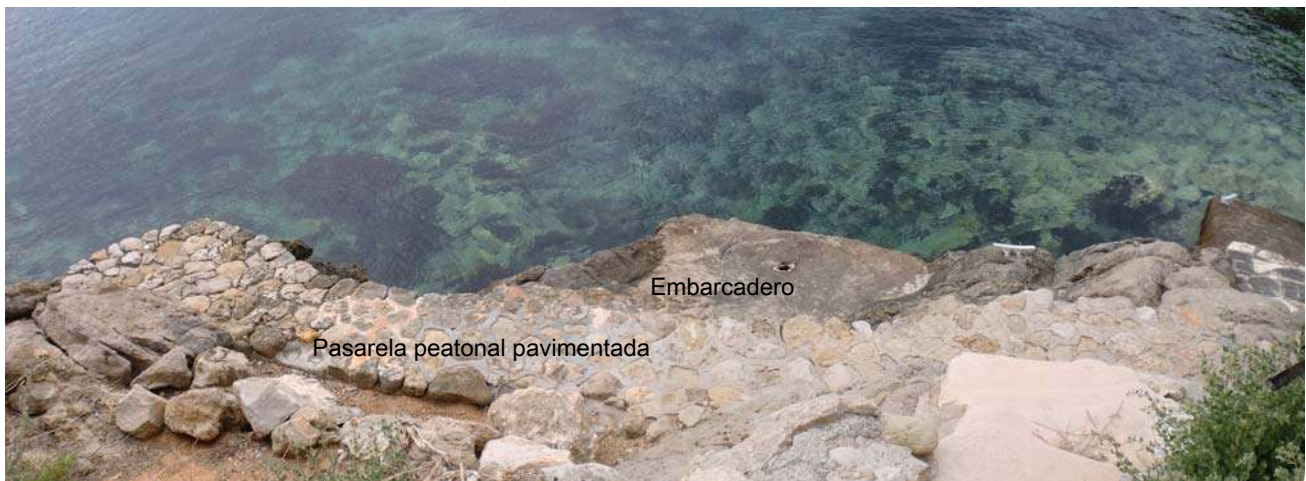
Figura 3.- Vista general del embarcadero tomada desde la caseta varadero y pasarela peatonal que le da acceso. Se aprecia el fondo marino que rodea al embarcadero es de roca suelta colonizada con cobertura de algas pardas.
