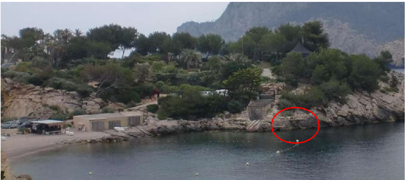
Figura 5.- A la izquierda, la playa del Pas de S´Illa con el chiringuito, a su lado las tres casetas varadero adosadas y una cuarta más alejada, con sus rampas de acceso al agua. A la izquierda de la cuarta caseta varadero se encuentra el pequeño embarcadero.
