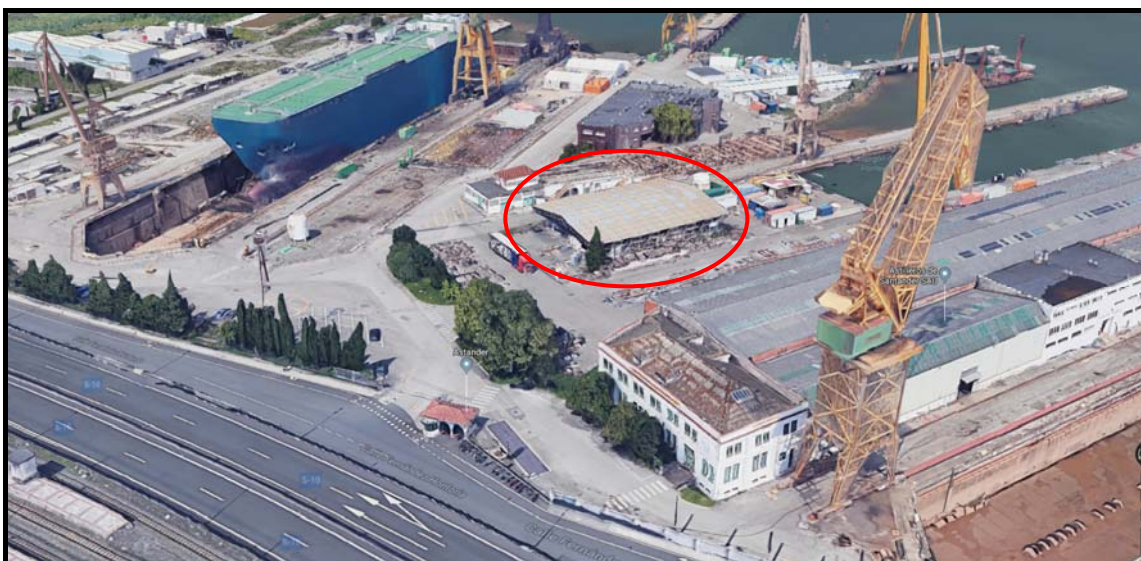
Vista y localización de la nave a reformar en las instalaciones de Astander
