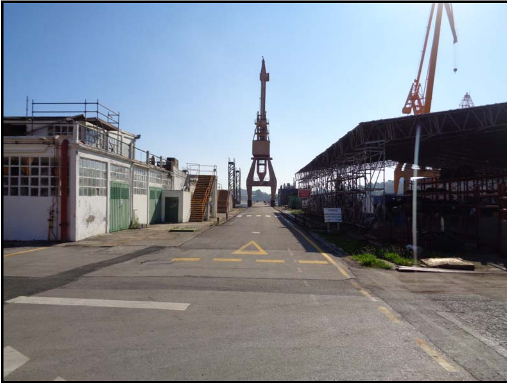
Vista del entorno del emplazamiento previsto para la nave (zona Norte).
