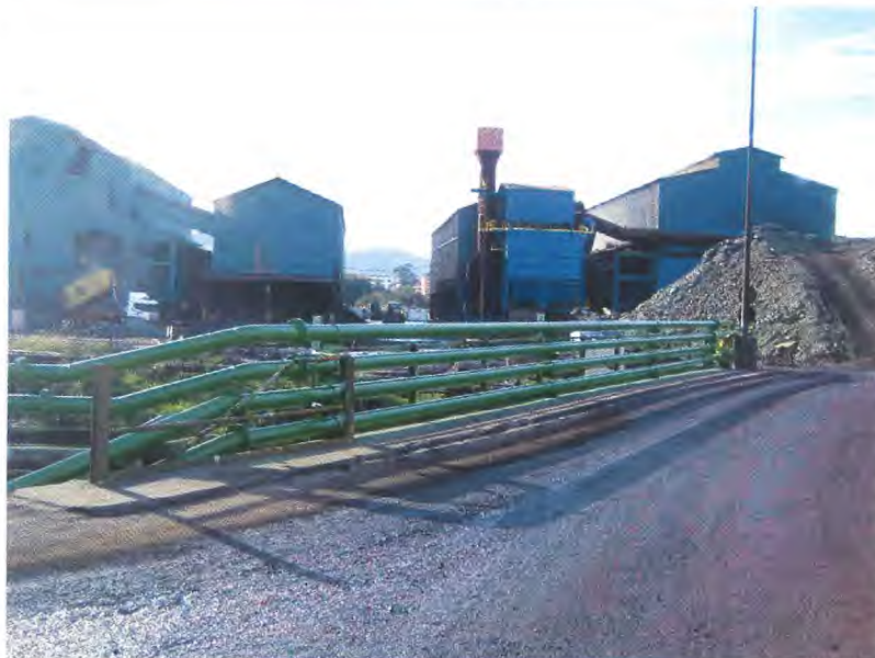
Fotografías del puente desde la parte superior, mostrando parte de las tuberías de servicios de fábrica que lo cruzan.
