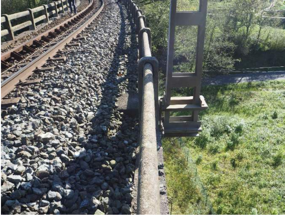
201029 069 Banqueta de balasto y anclaje de poste de catenaria en lado derecho
