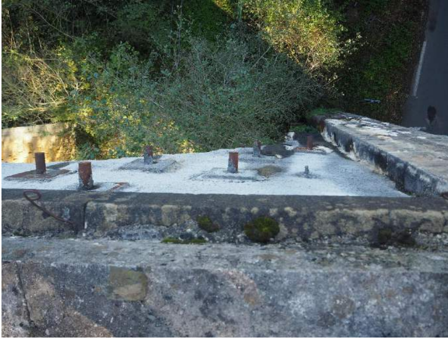
201029 041 Bulones y gunita en vano 6 lado izquierdo
