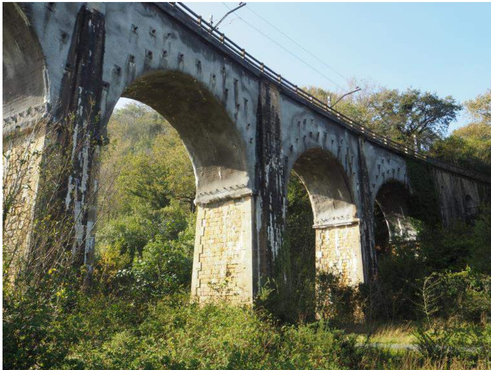
Figura 3.2.5. Vista de las pilas de la estructura
