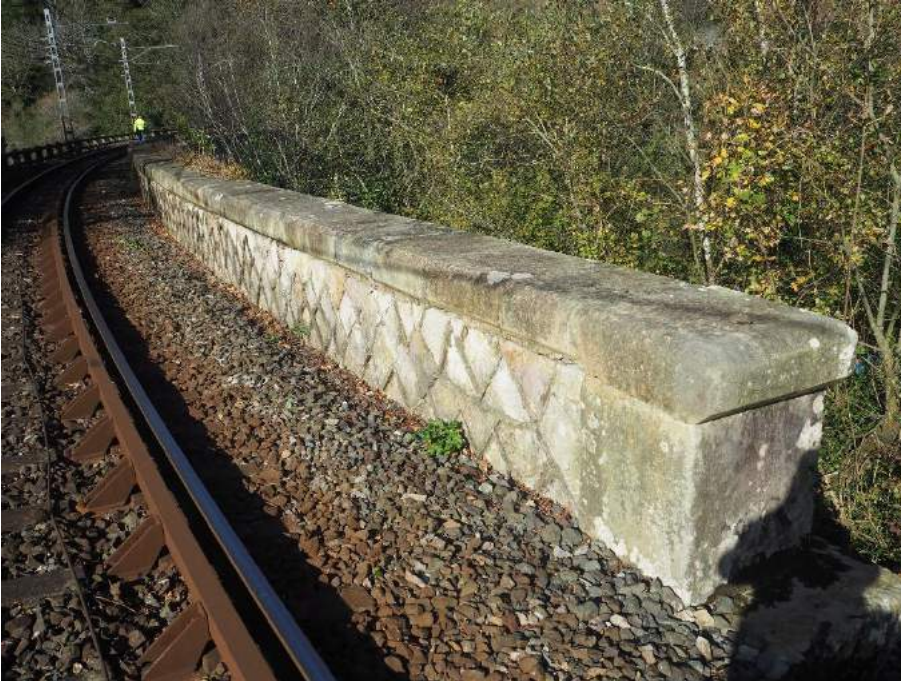
201029 007 Arqueta de servicios en estribo 2 lado izquierdo
