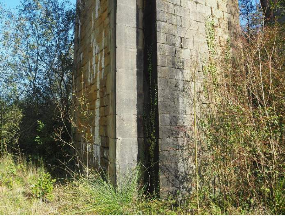
201029 147 Aristones derecho pila 5 lado vano 5
