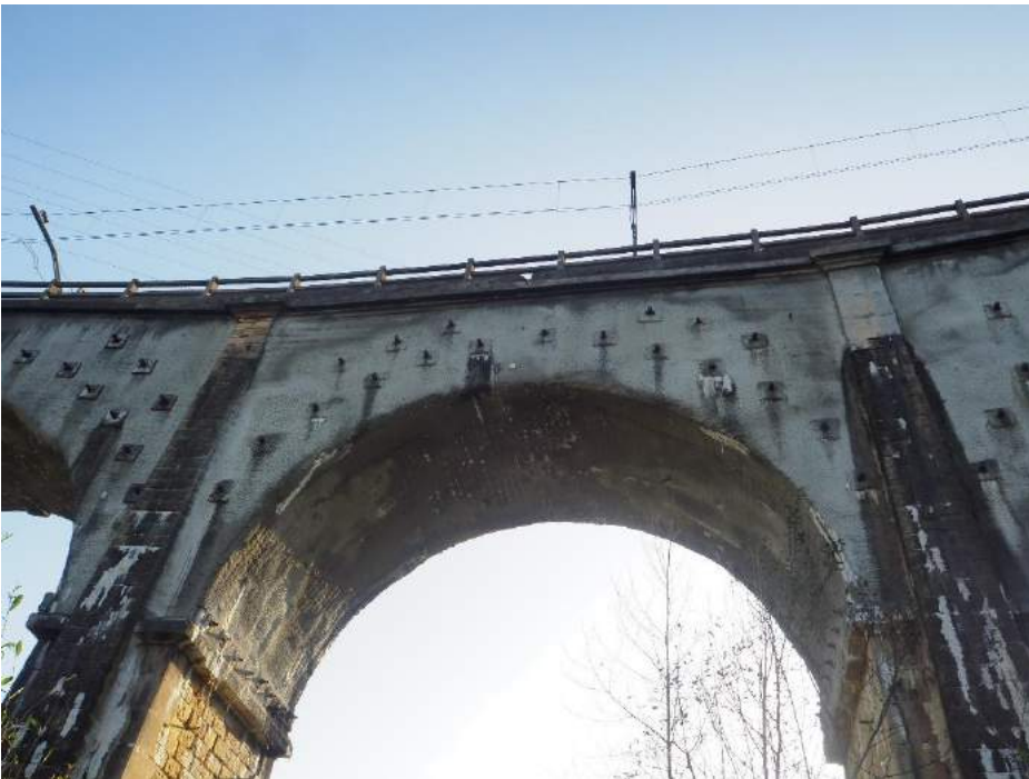
201029 180 Bóveda vano 4 lado izquierdo con bulones y gunita
