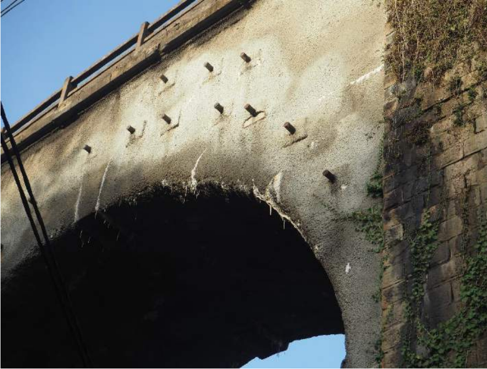
201029 223 Detalle de anclajes de bulones en bóveda vano 1 lado derecho
