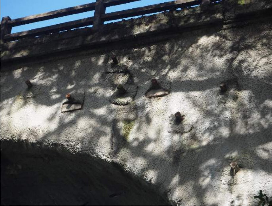
201029 103 Detalle de los bulones y anclajes en bóveda vano 7 lado derecho
