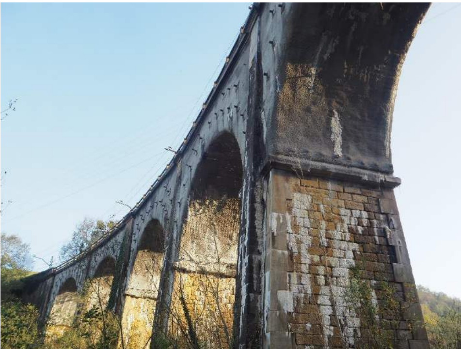
201029 248 Vista inferior de bóvedas desde vano 2
