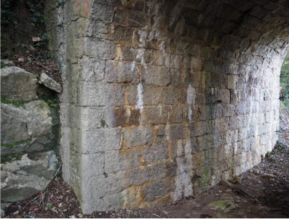
201029 271 Hastial de bóveda para paso de camino en muro en vuelta derecho estribo 1
