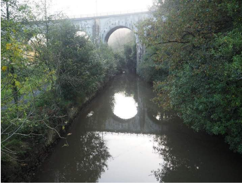
201029 249 Cauce bajo vano 2
