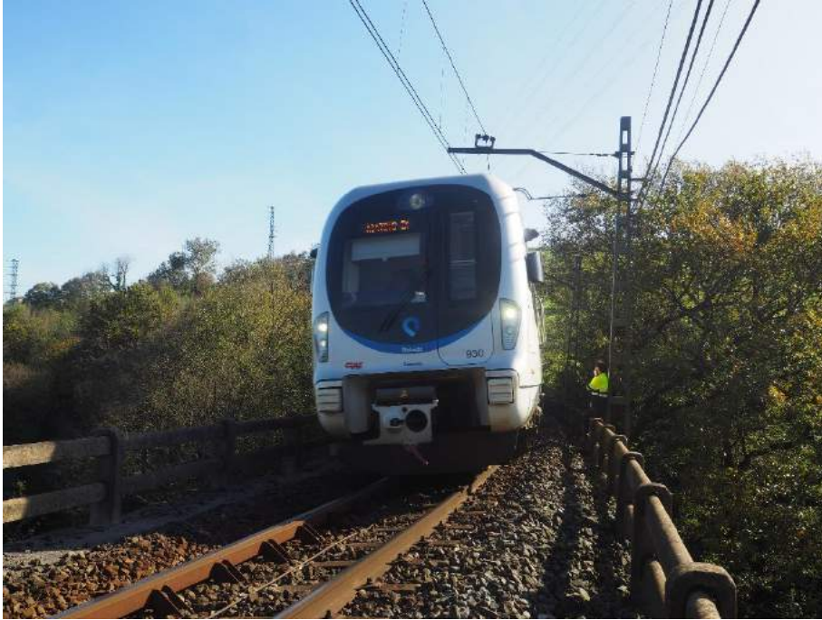
201029 045 Tren de pasajeros desde estribo 2 sentido Bilbao
