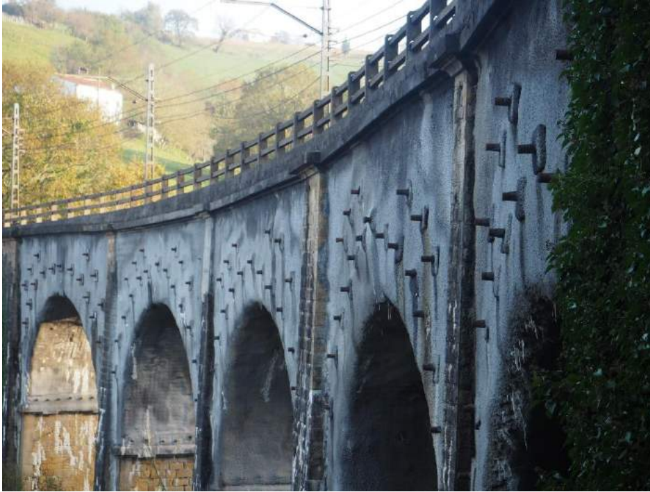
201029 261 Deformación en imposta por asiento en lado izquierdo
