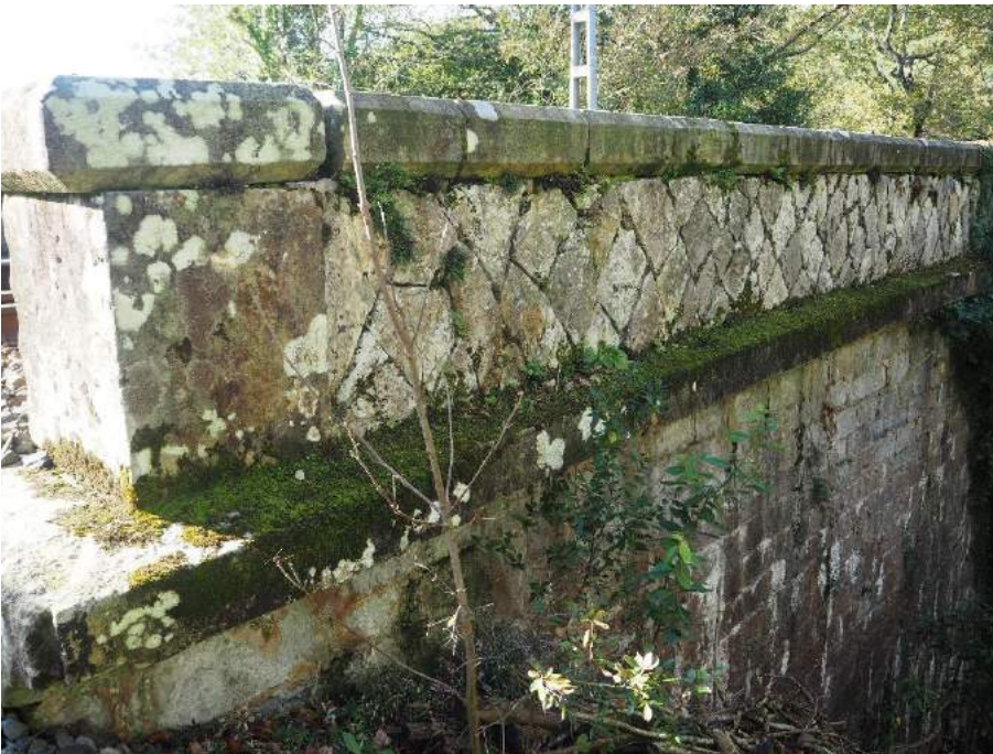
201029 008 Murete izquierdo de fábrica en buen estado
