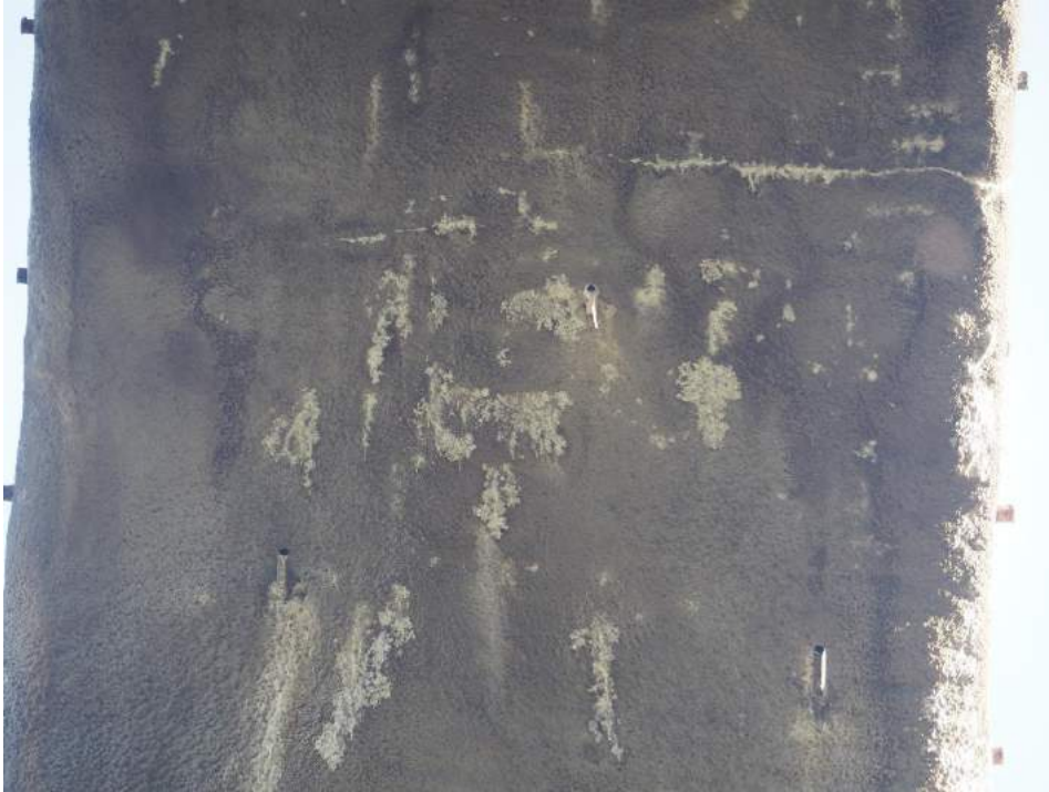
201029 205 Detalle de mechinales en bóveda vano 6
