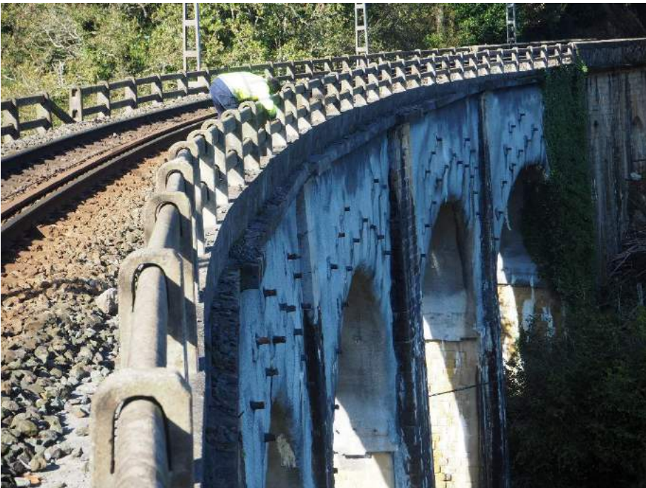
201029 048 Deformación en imposta por asiento en lado izquierdo
