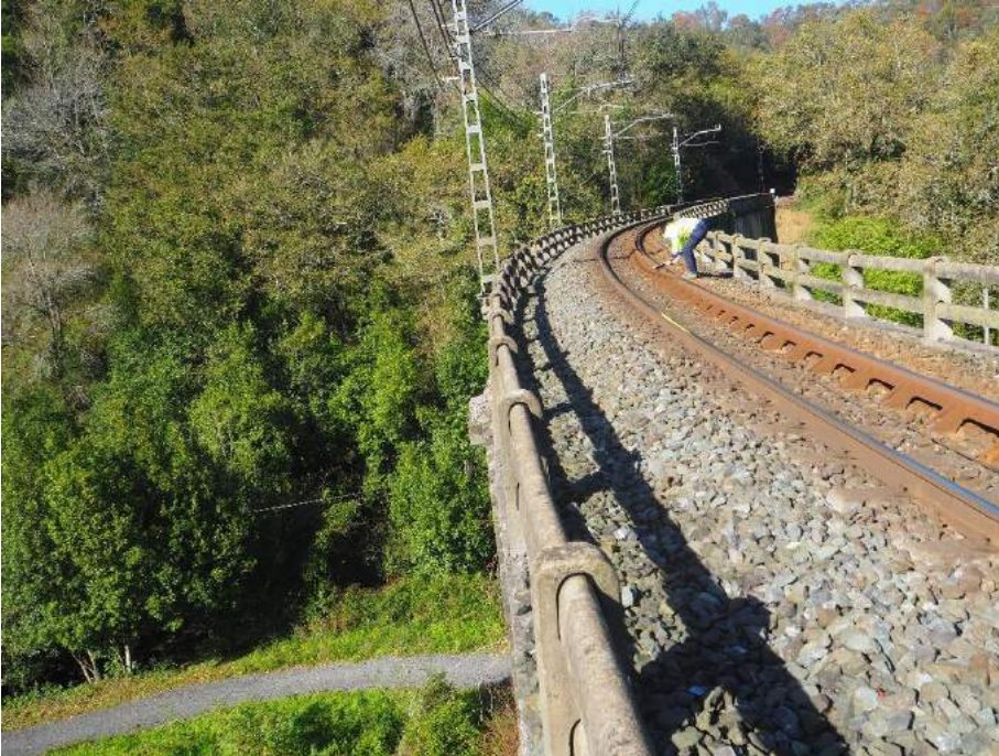
201029 055 Barandilla y banqueta de balasto en lado izquierdo
