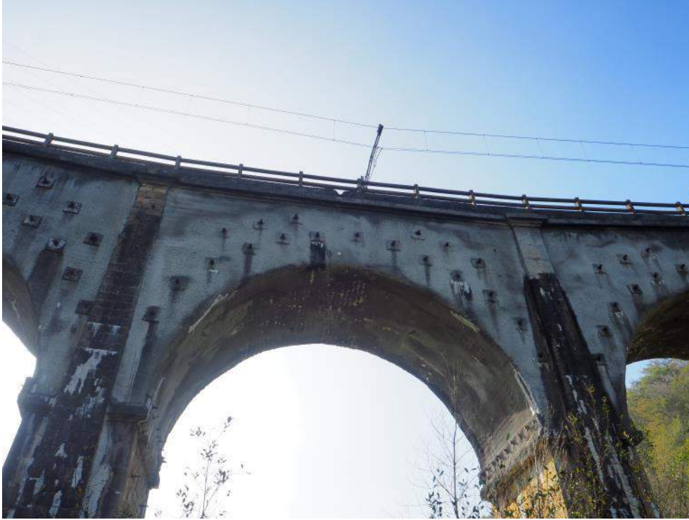
Figura 4. Vista de una de la bóveda del vano 4
