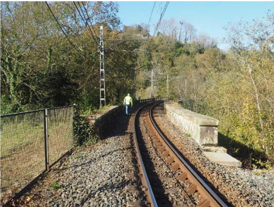
201029 004 Plataforma desde estribo 2.
