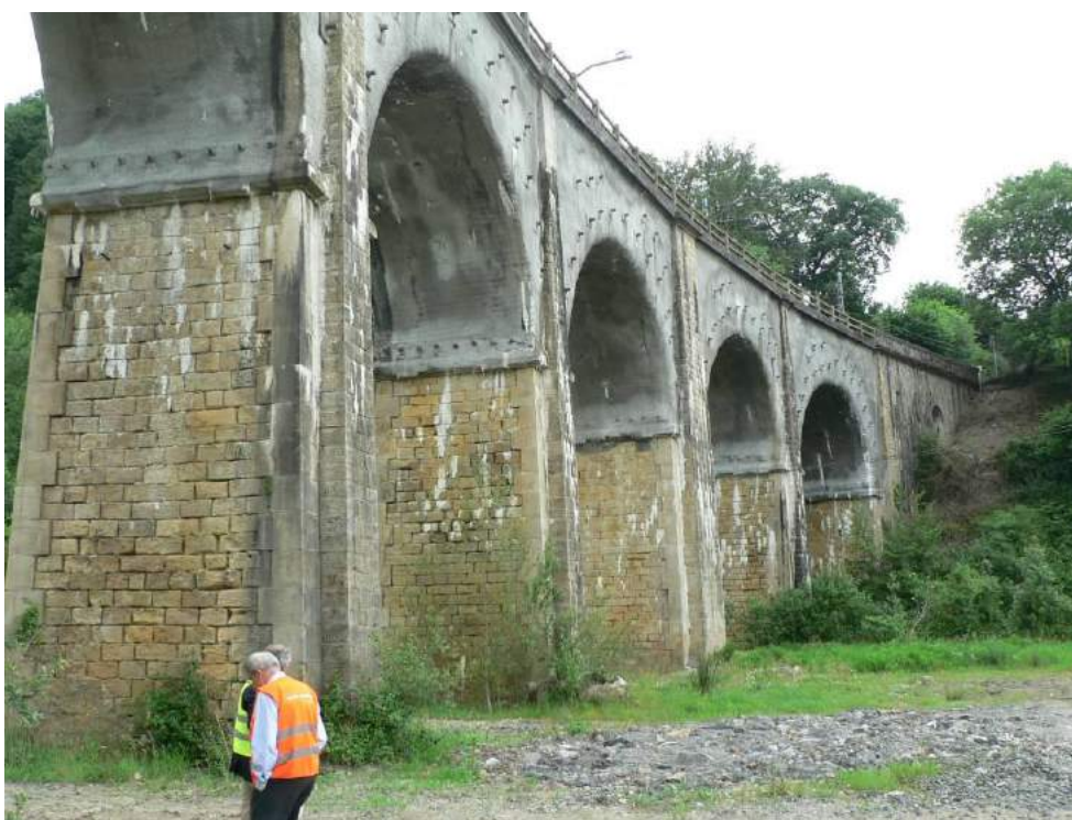
Figura 5. Vista de estribo 1 y de las pilas 1 a 4
