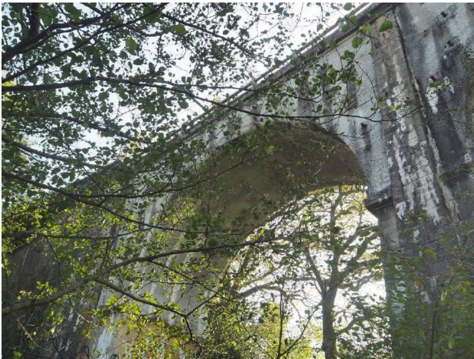
201029 162 Bóveda vano 7 lado izquierdo con bulones y gunita
