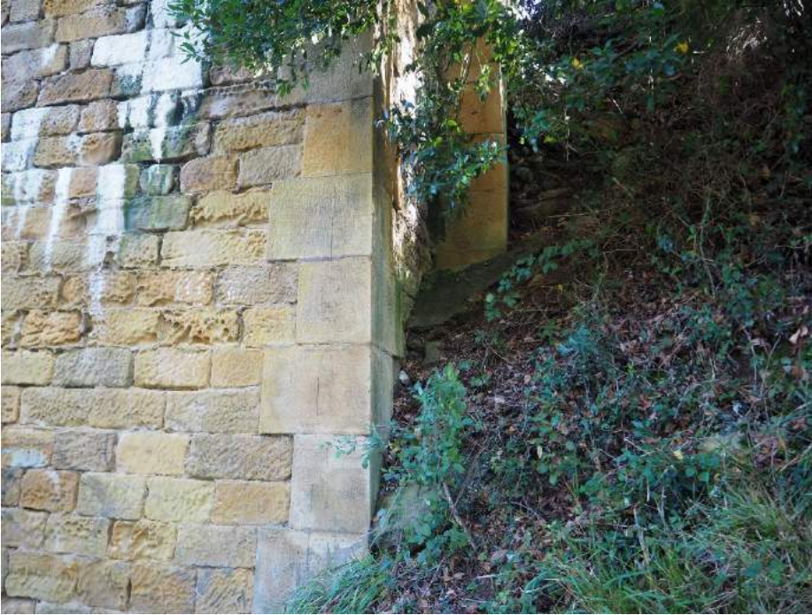
201029 111 Aristones laterales de estribo 2 en buen estado
