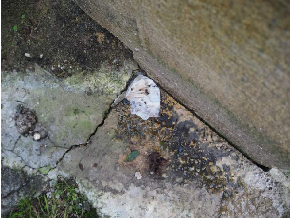
201029 237 Detalle de separación entre torta de hormigón y pila 2 lado vano 2
