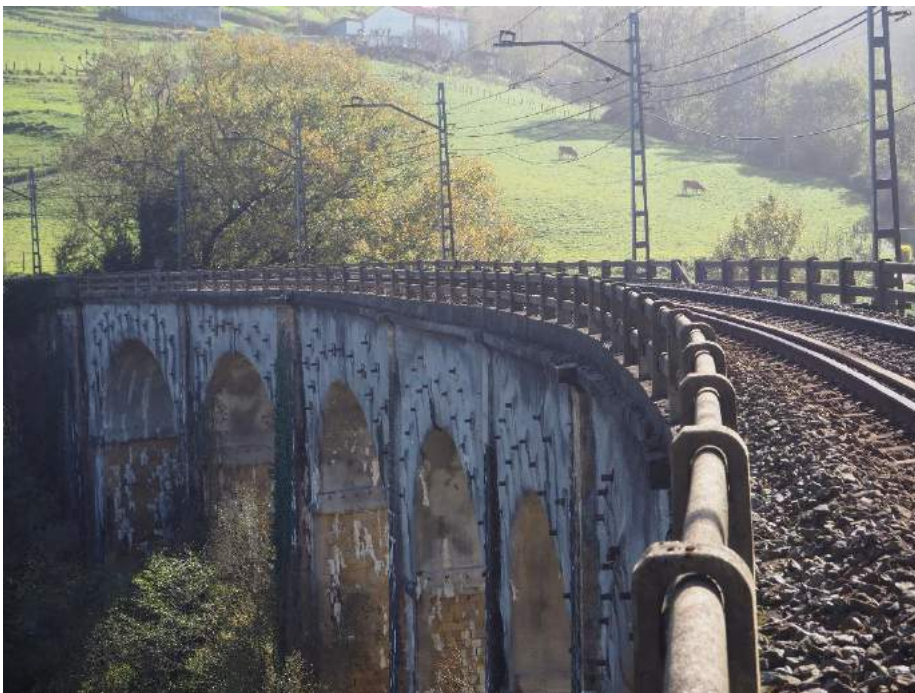
201029 090 Deformación en imposta por asiento en lado izquierdo
