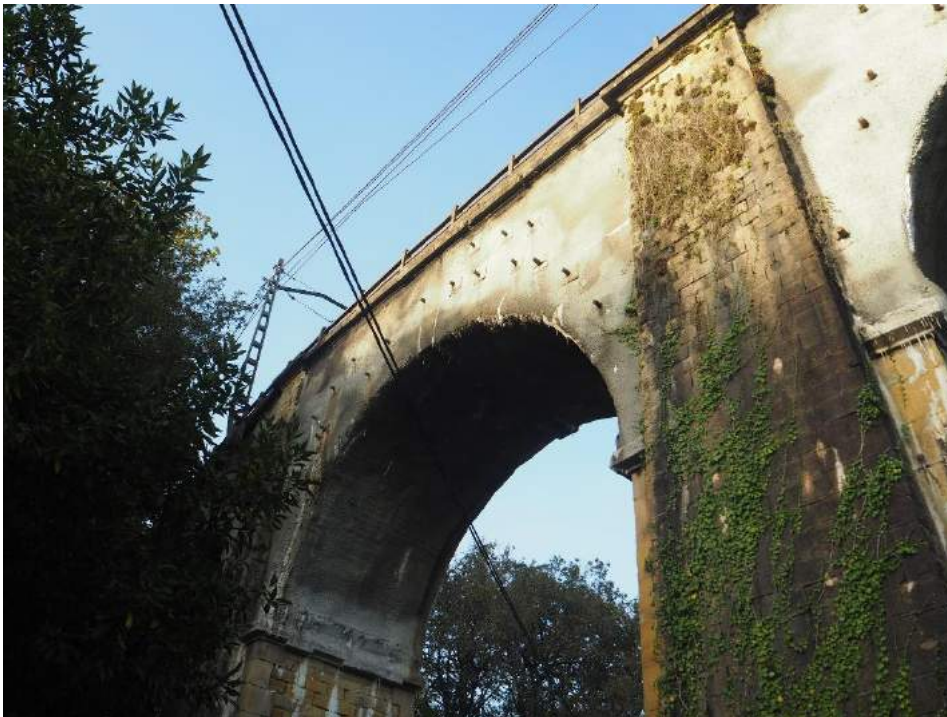
201029 222 Bóveda vano 1 lado derecho con bulones y gunita
