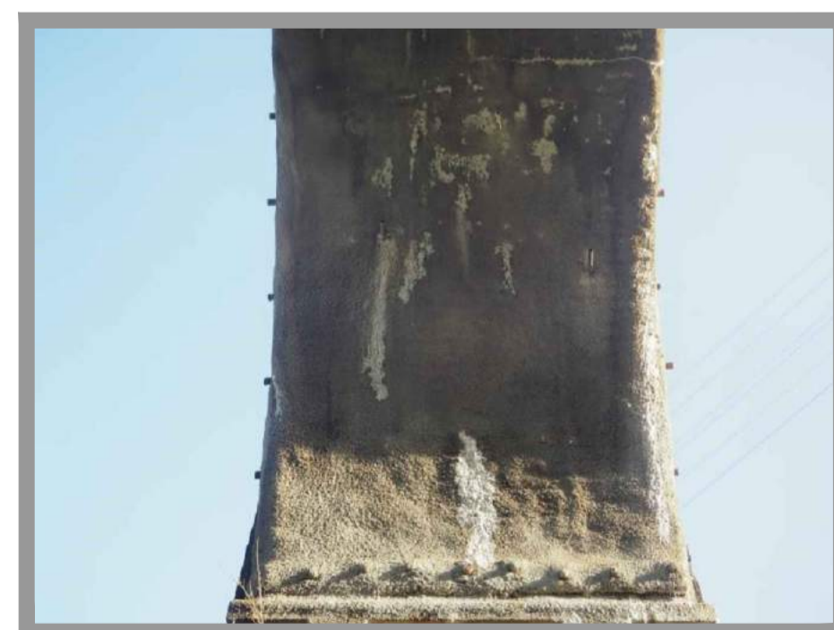
ACTUACIÓN 6 EJECUCIÓN DE NUEVOS MECINALES EN BÓVEDAS Y TÍMPANOS
