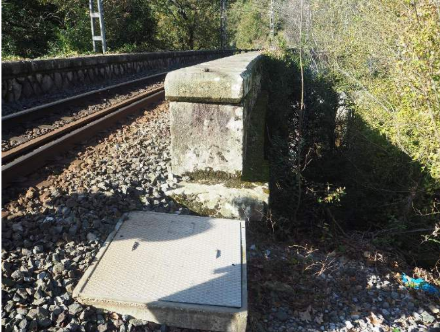
201029 005 Murete izquierdo de fábrica en buen estado
