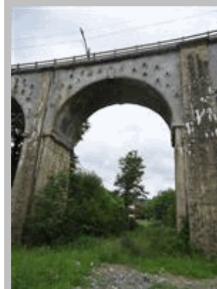
26 Vista de vano 6
