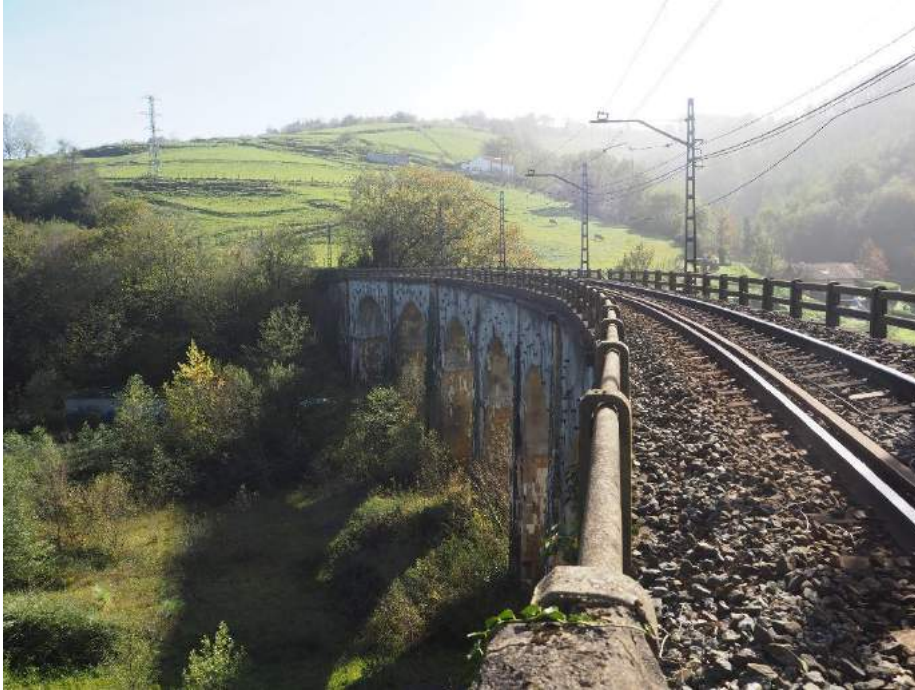
201029 089 Deformación en imposta por asiento en lado izquierdo
