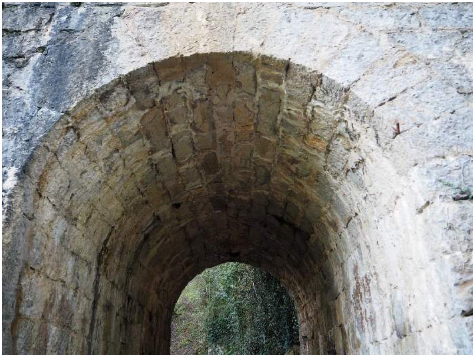
201029 254 Bóveda para paso de camino en muro en vuelta izquierdo estribo 1
