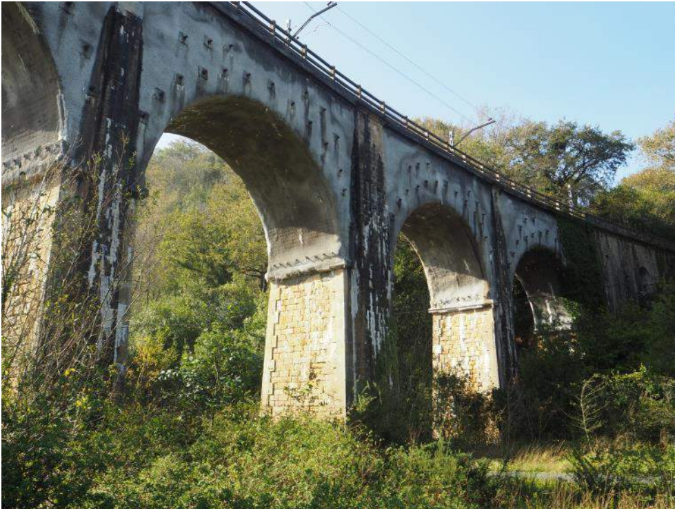
Figura 5. Vista de las pilas de la estructura
