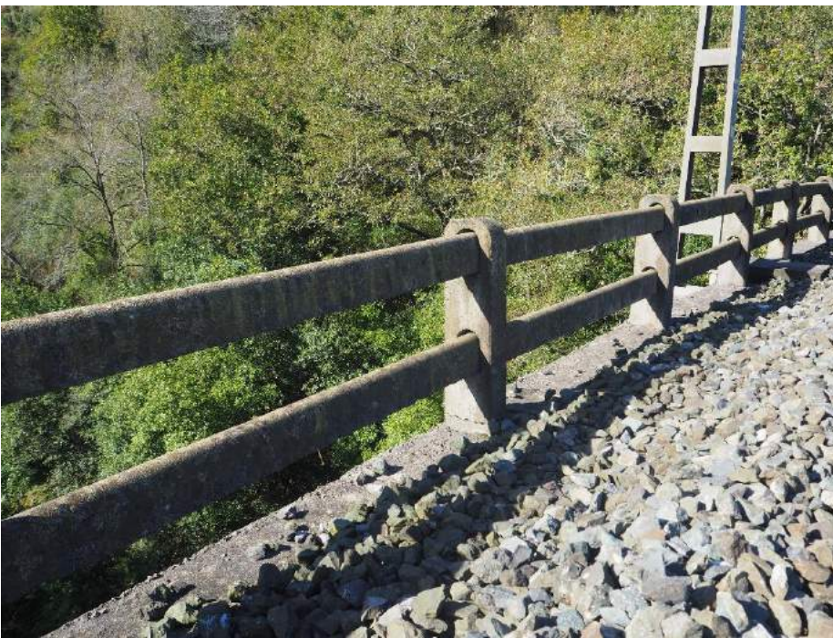
201029 076 Barandilla en lado derecho y poste de catenaria
