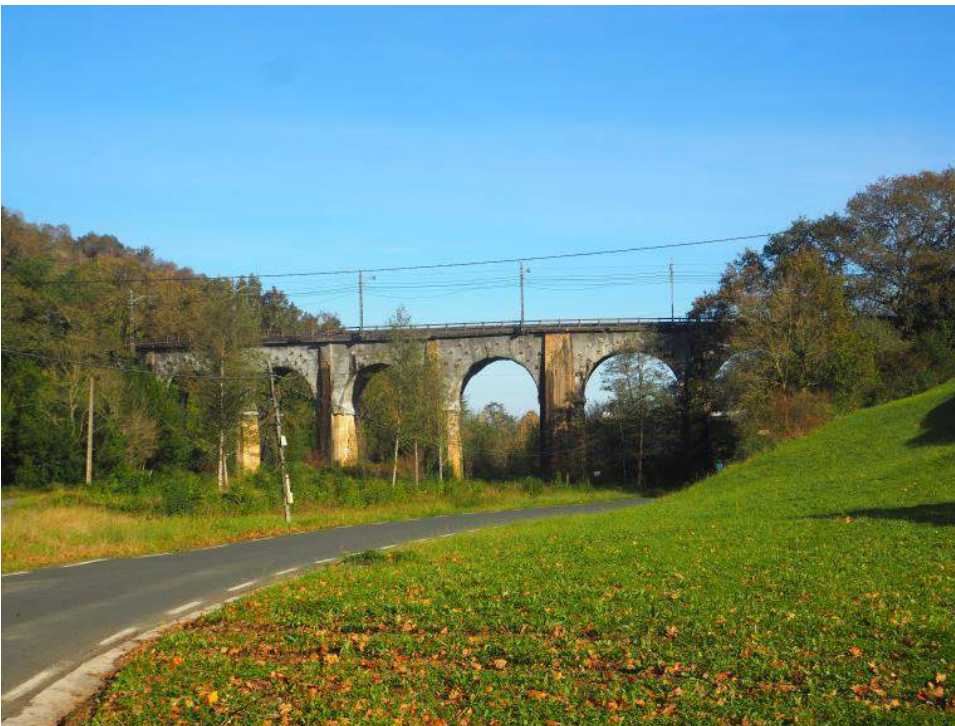
Figura 3.3. Alzado derecho del viaducto de Aia-Orio
