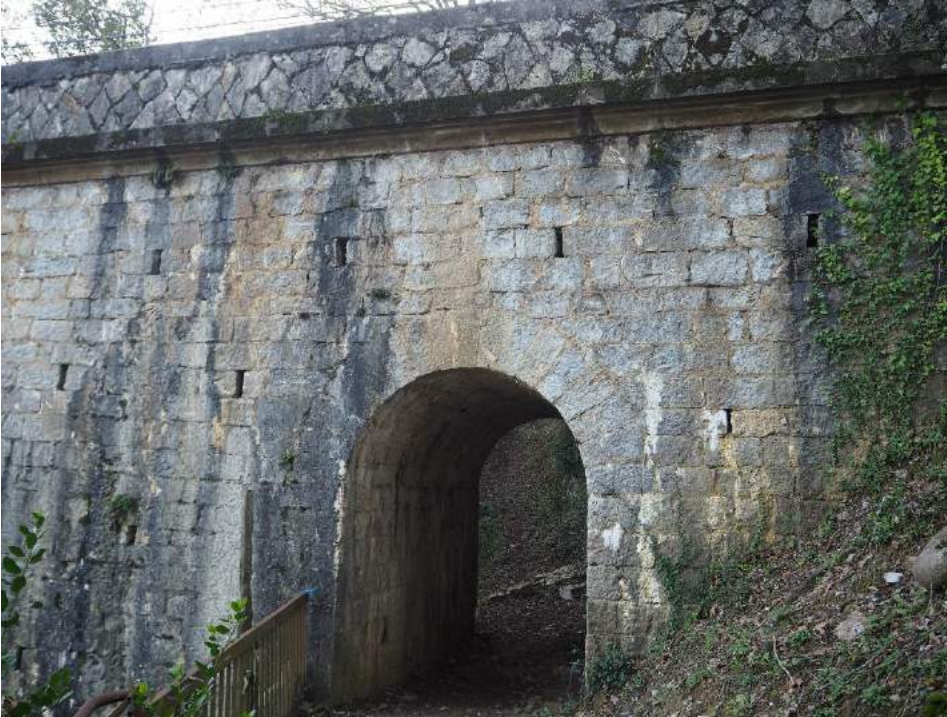
201029 251 Bóveda para paso de camino en muro en vuelta izquierdo estribo 1
