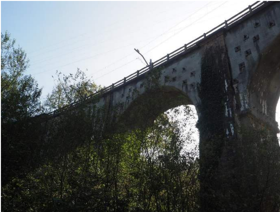
201029 137 Bóvedas vano 6 y 7 lado izquierdo
