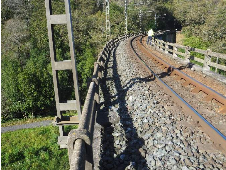
201029 049 Barandilla y banqueta de balasto en lado derecho
