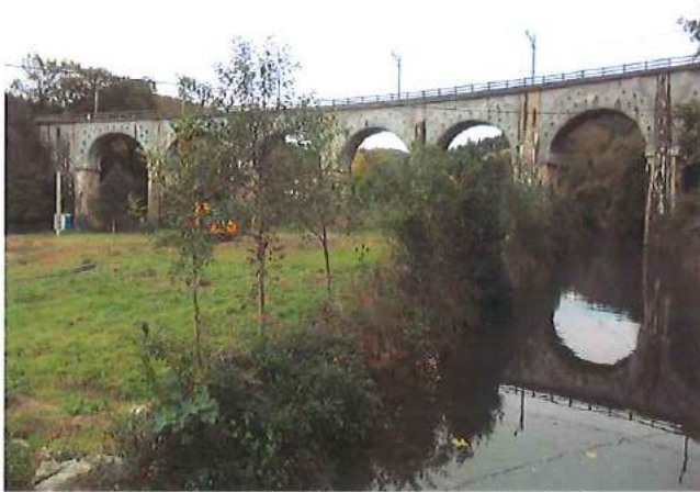
Vista general del viaducto de Aia-Orio
