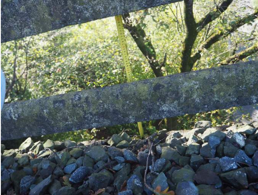
201029 025 Aparentes 45 cm de espesor adicional de balasto
