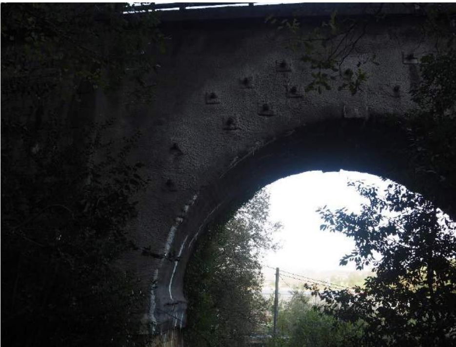
201029 276 Bulones y gunita en bóveda vano 1 lado derecho
