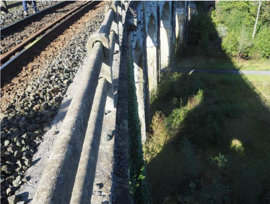
201029 044 Barandilla de hormigón en lado izquierdo
