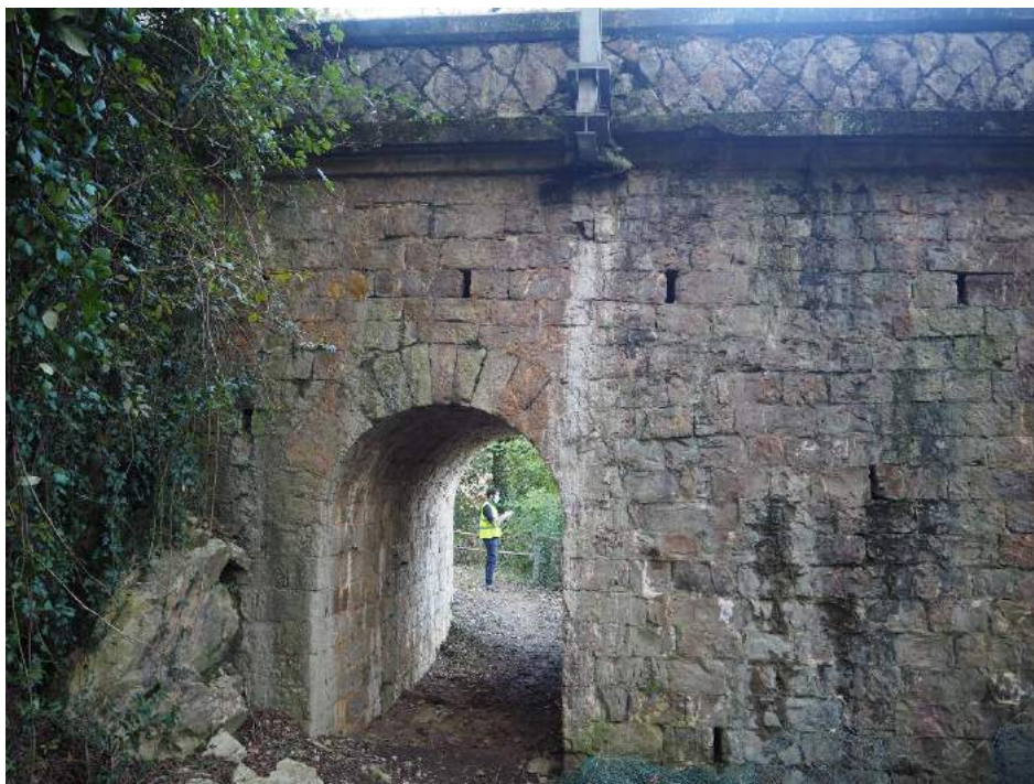
201029 265 Bóveda para paso de camino en muro en vuelta derecho estribo 1
