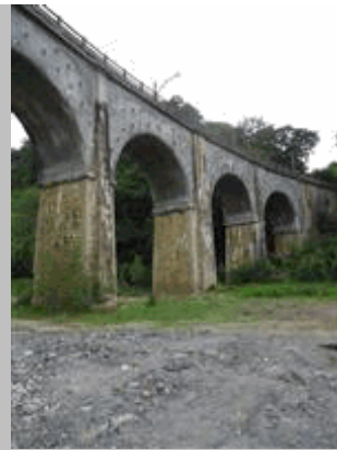
29 Vista de vanos 3, 2 y 1
