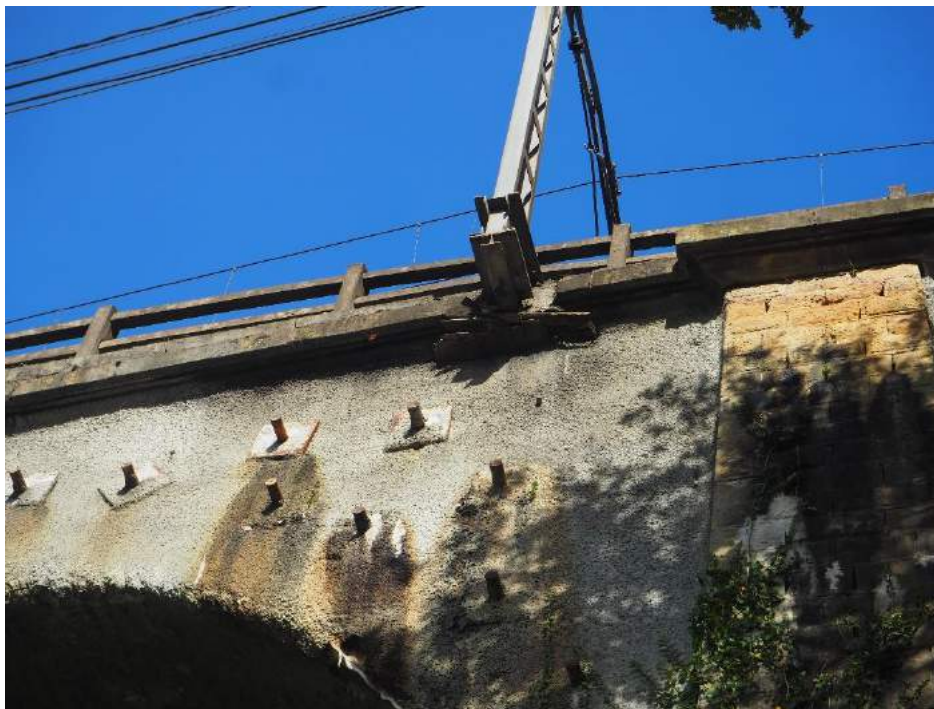
201029 130 Anclaje de poste de catenaria bóveda 6 lado derecho
