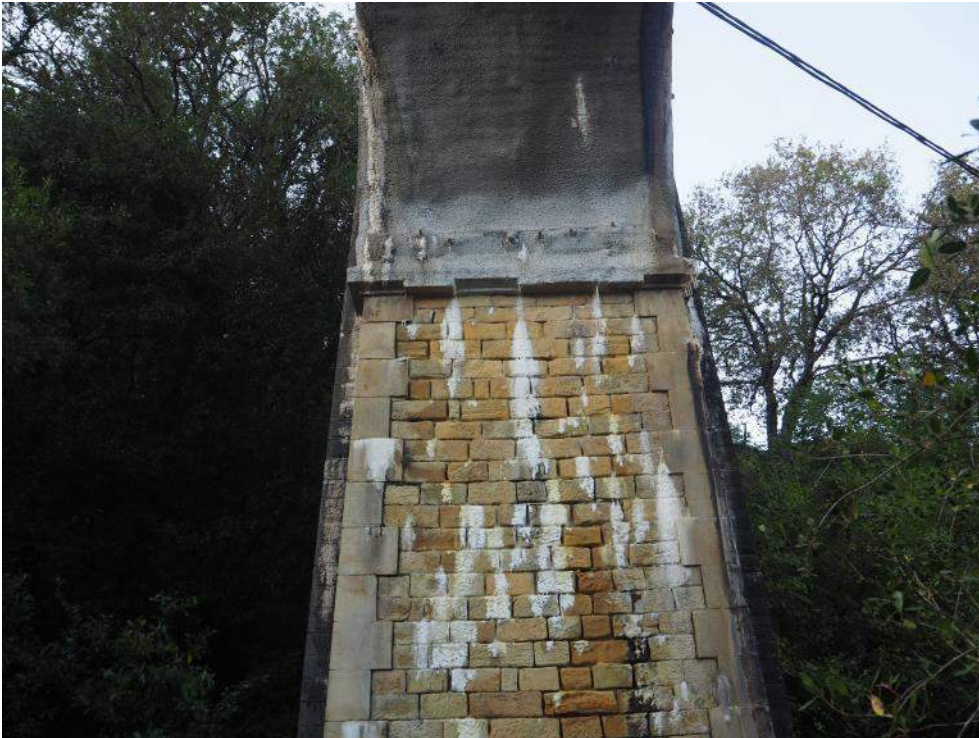
Figura 2. Anclajes en cabeza de pila realizados mediante bulones pasantes
