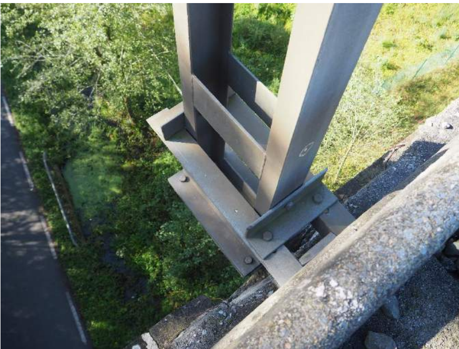
201029 036 Anclaje de poste de catenaria en lado derecho sobre vano 7
