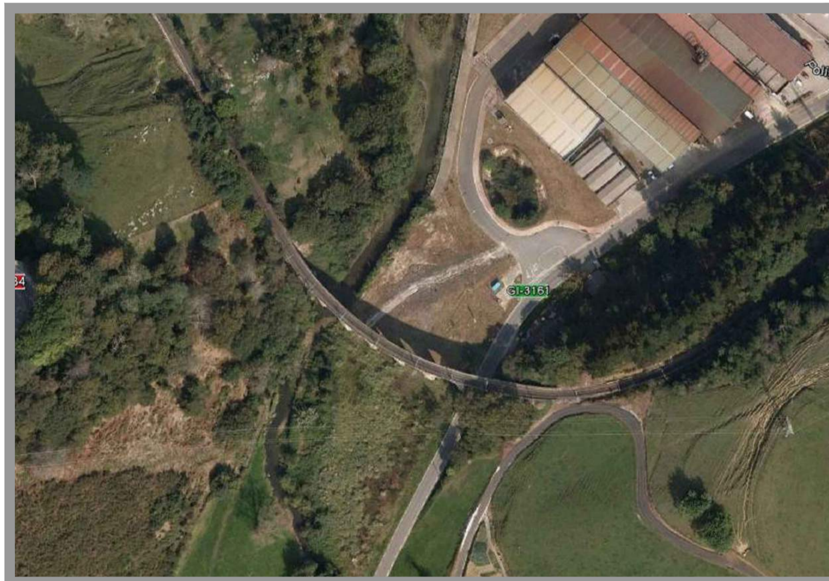
LOCALIZACIÓN DEL VIADUCTO EN EL PK 089/293 DE LA LÍNEA BILBAO-DONOSTIA
