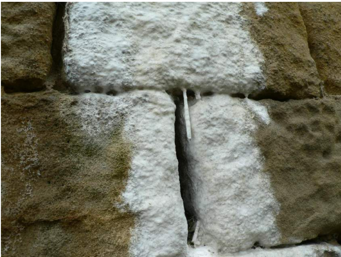
Figura 2. Manchas calcáreas en pila
