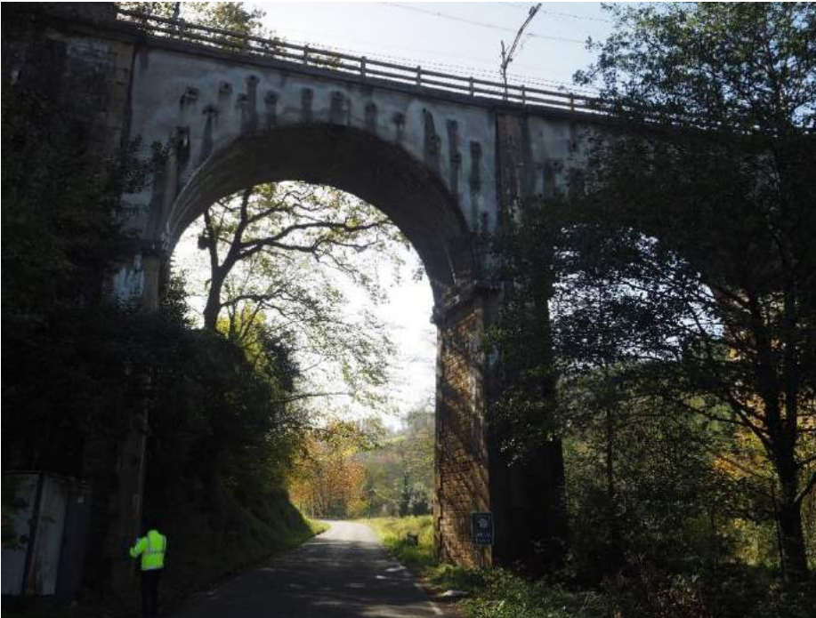
201029 115 Bóveda vano 7 lado izquierdo con bulones y gunita
