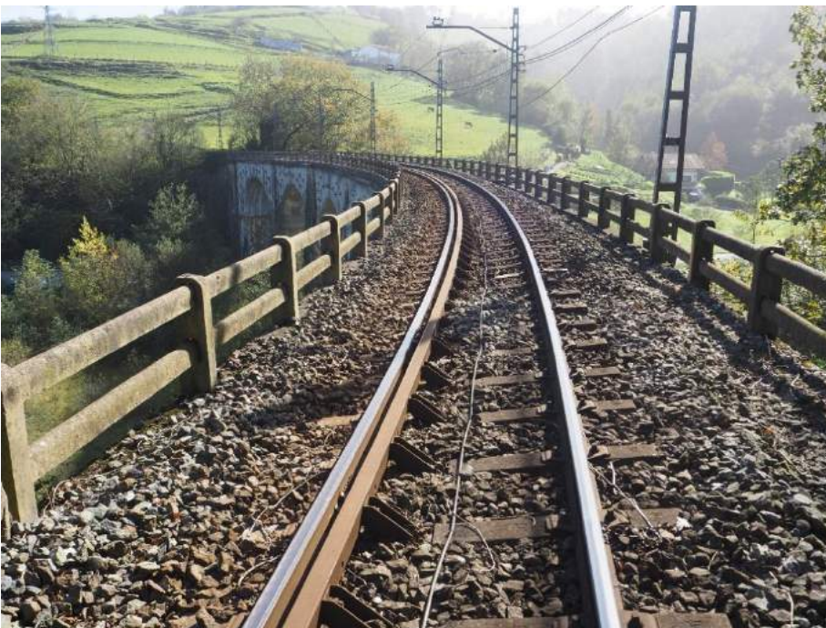
201029 088 Plataforma ferroviaria desde estribo 1
