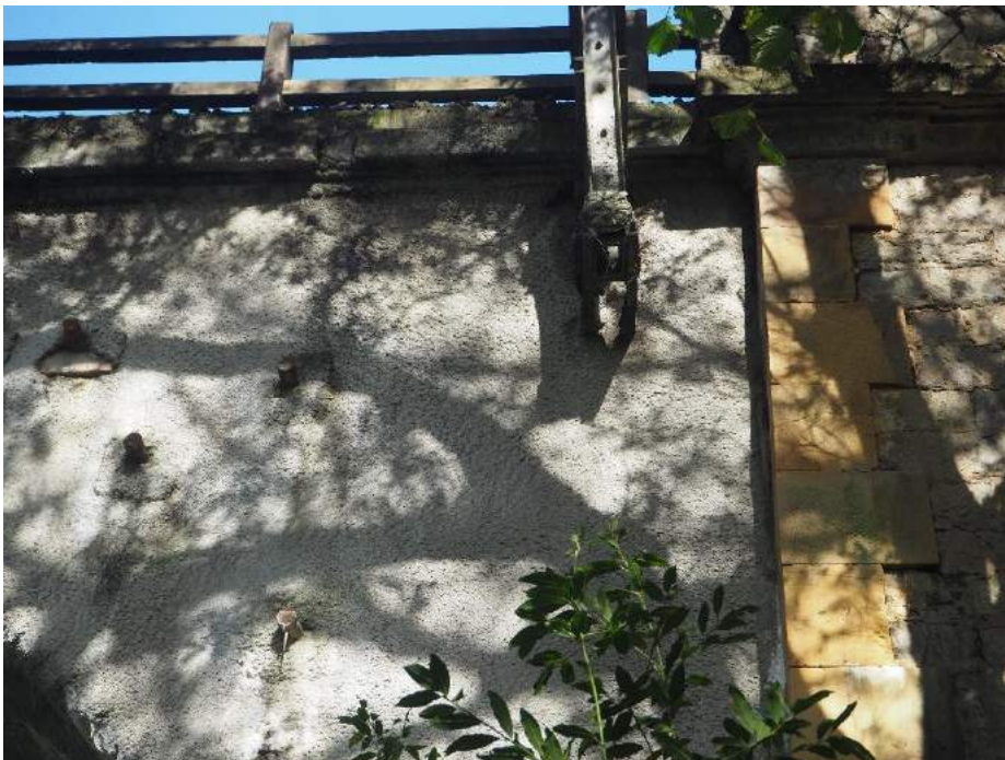
201029 106 Bóveda vano 7 lado derecho con bulones y gunita
