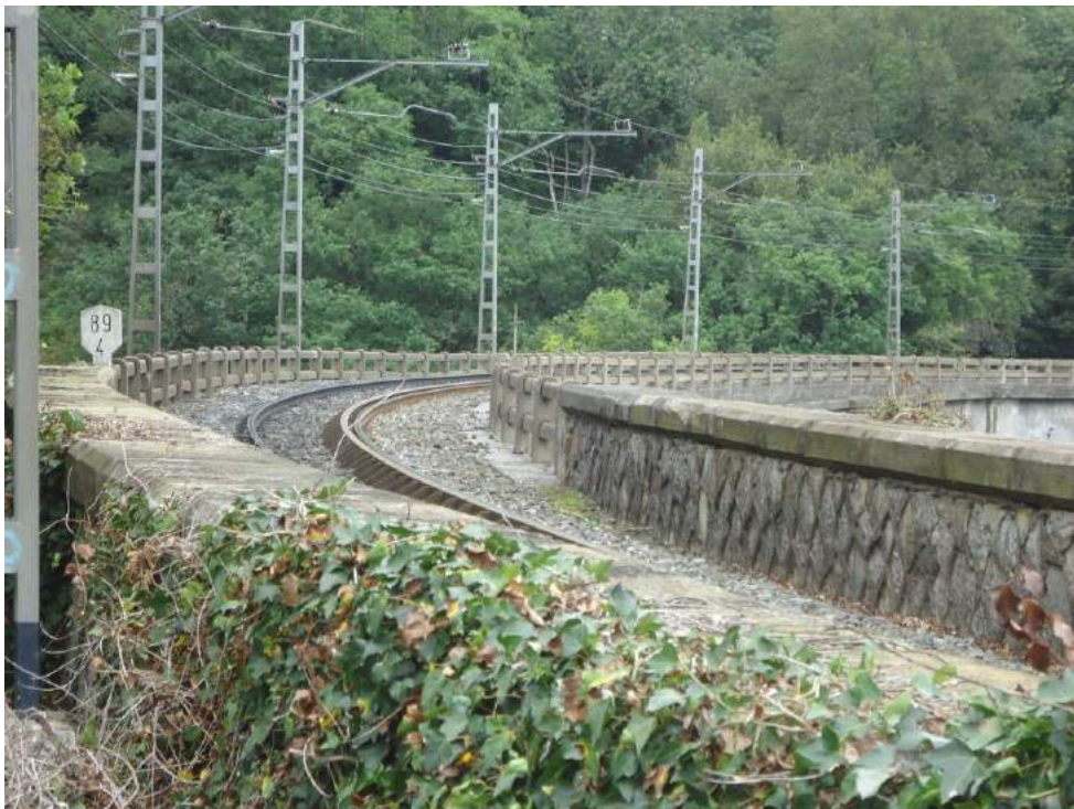
Figura 6. Vista del asiento registrado en las pilas P-2, P-3, P-4 y P-5 desde el estribo 2
