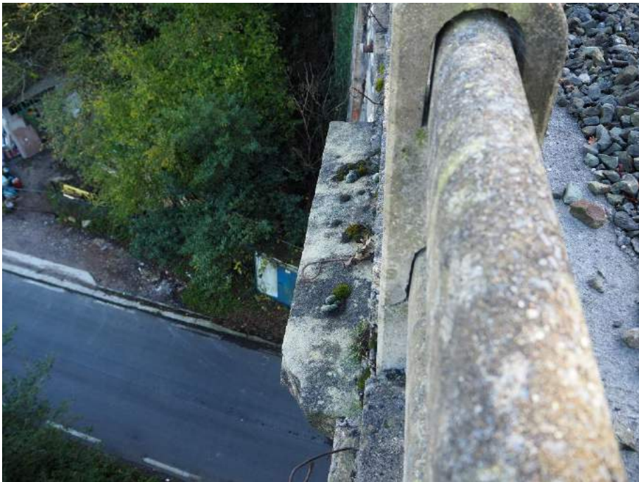
201029 042 Imposta de fábrica en pila 6 lado izquierdo
