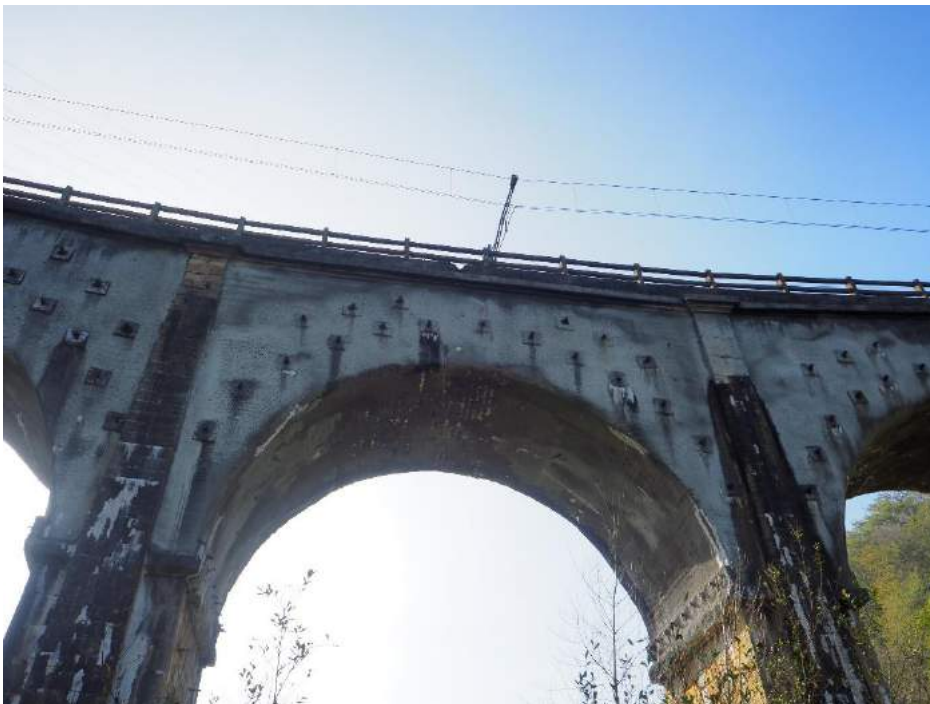
201029 174 Bóveda vano 4 lado izquierdo con bulones y gunita
