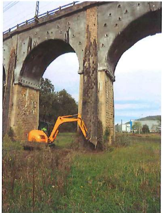
Vista general durante la ejecución de calicata C-P3
