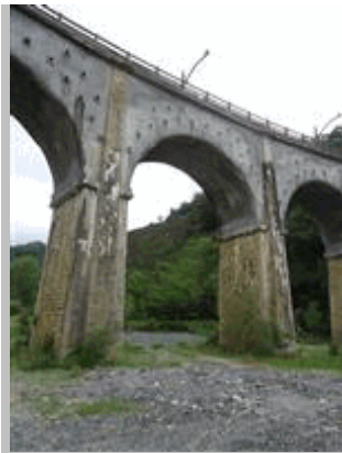
28 Vista de vano 4
