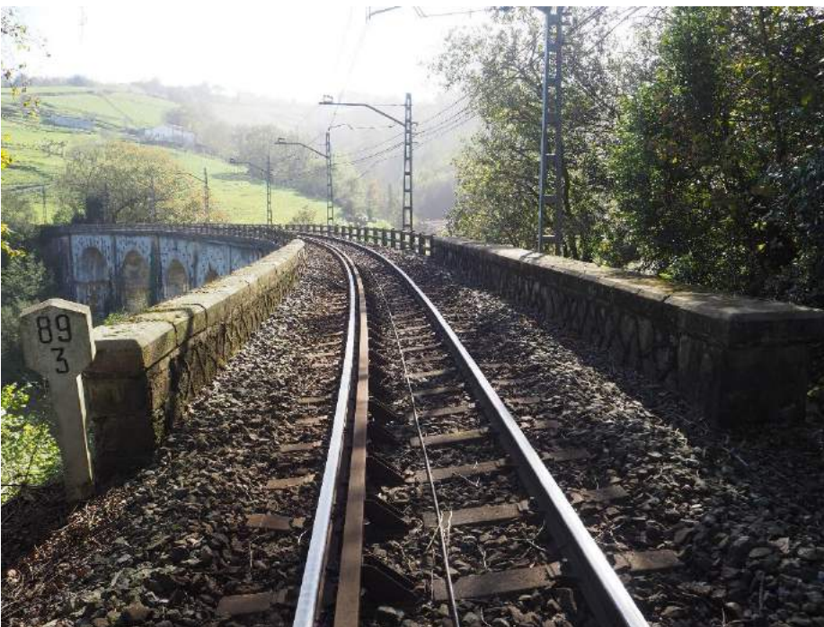
201029 092 Plataforma ferroviaria desde estribo 1
