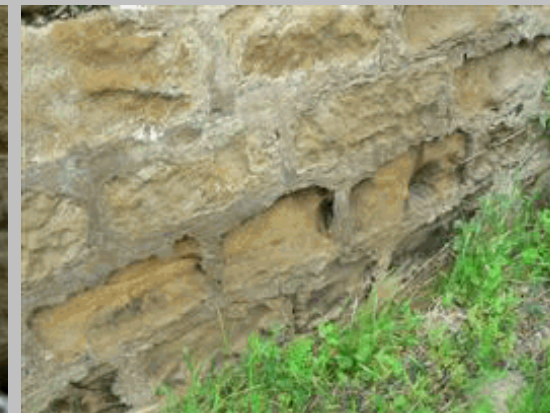
06 Alveolización por empleo de morteros de cemento
