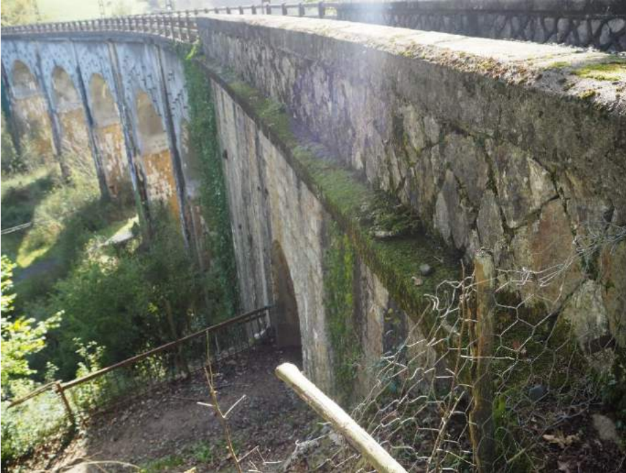
201029 095 Bóveda de paso de camino y muro en vuelta izquierdo de estribo 1
