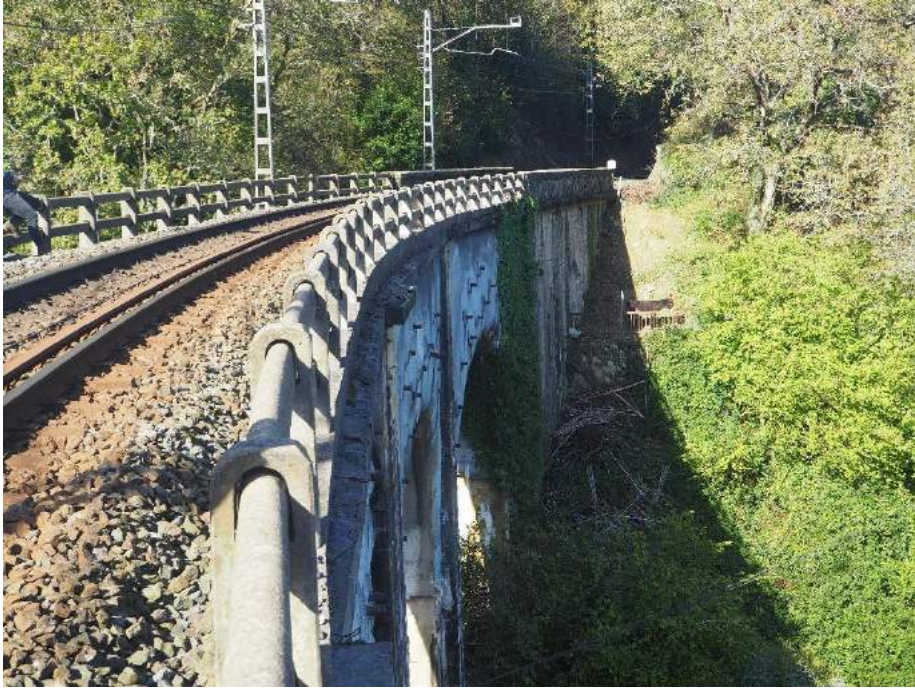
201029 077 Imposta en lado izquierdo desde vano 4 hacia estribo 1
