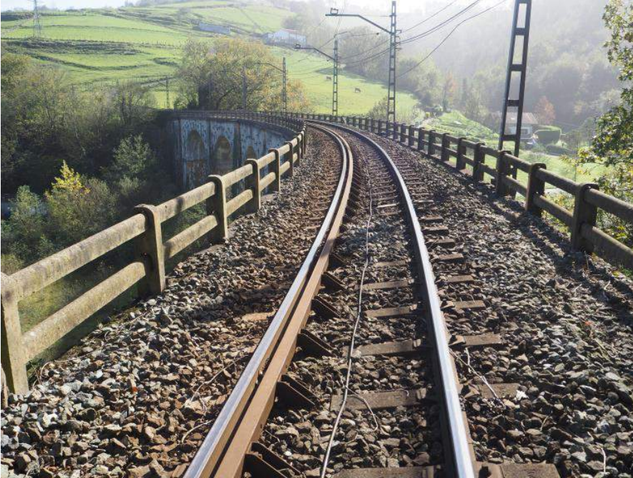
Figura 3.2.3. Vista de la plataforma desde el estribo 1
