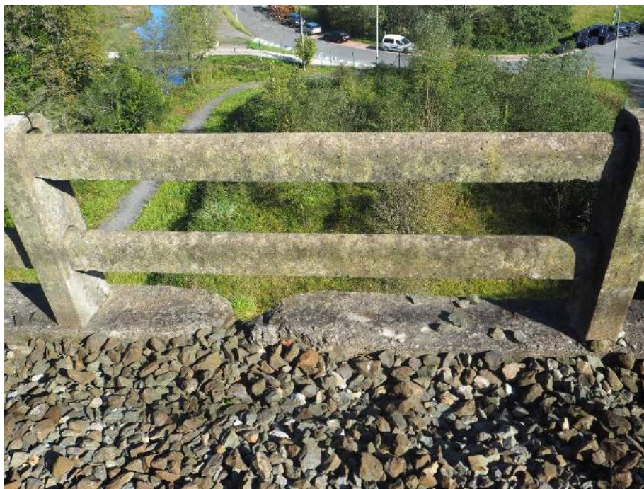
201029 066 Rotura de murete de anclaje de barandilla lado izquierdo sobre vano 4
