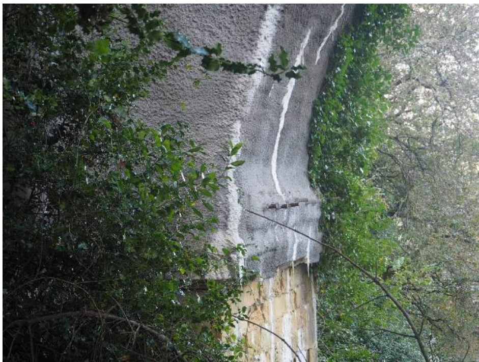
201029 277 Bulones en cabeza de estribo 1
