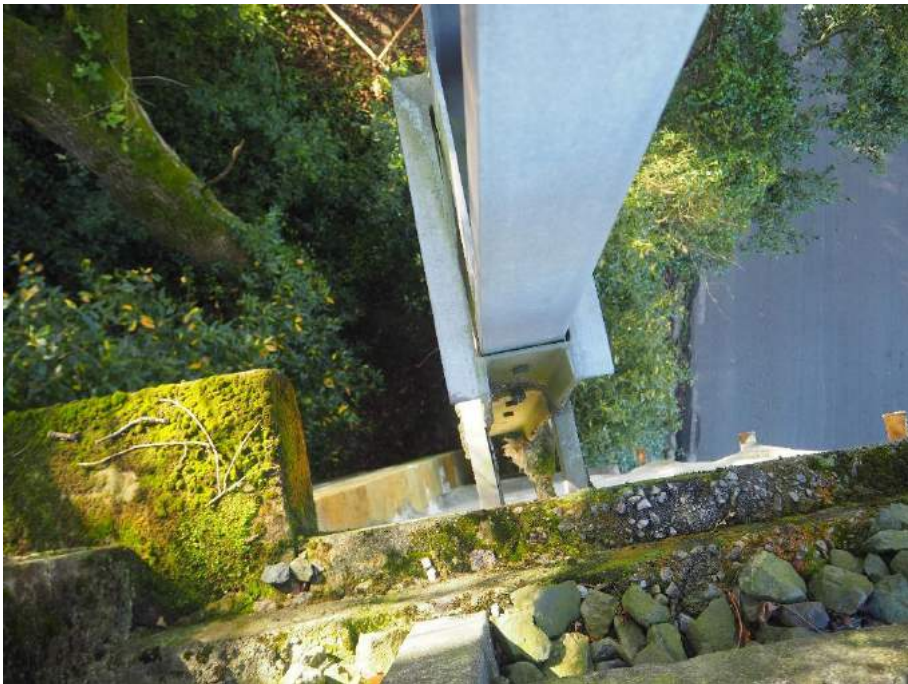
201029 022 Anclaje de poste de catenaria en lado derecho estribo 2
