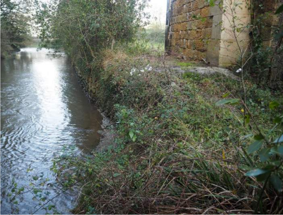
201029 227 Cauce de arroyo bajo vano 2
