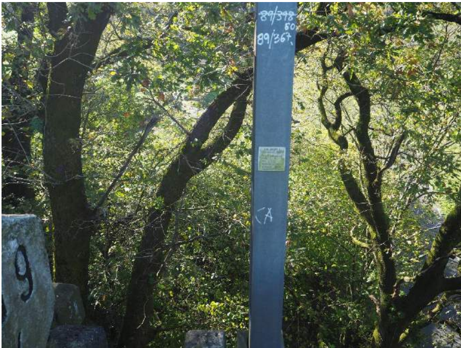
201029 026 Poste de catenaria en lado derecho estribo 2
