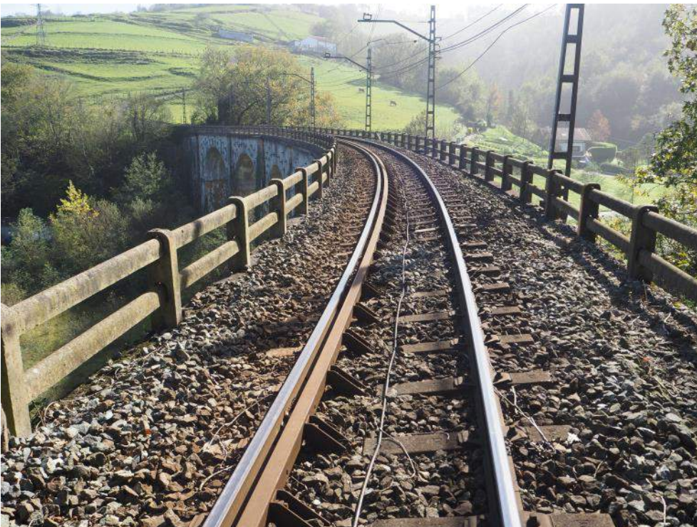
Figura 3. Vista de la plataforma desde el estribo 1
