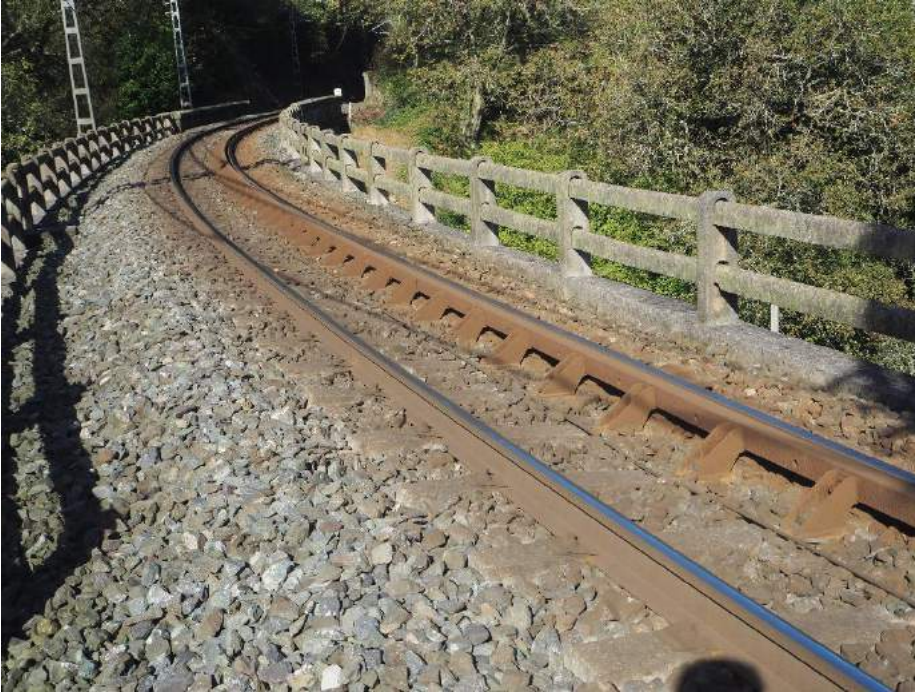
201029 071 Banqueta de balasto, carriles y encarriladora
