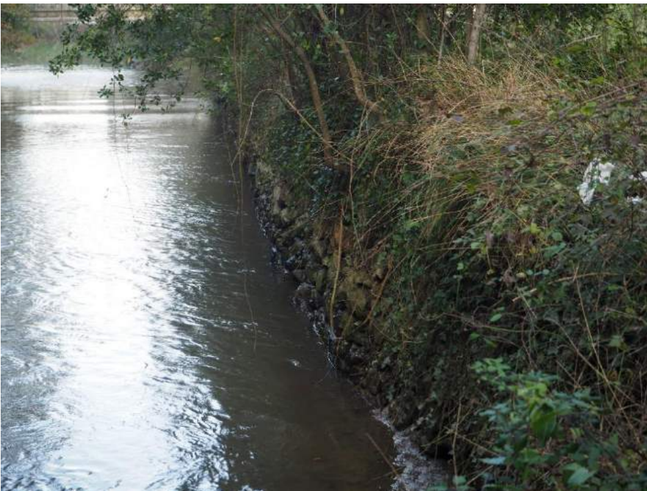
201029 228 Muro de fábrica en encauzamiento de cauce en vano 2
