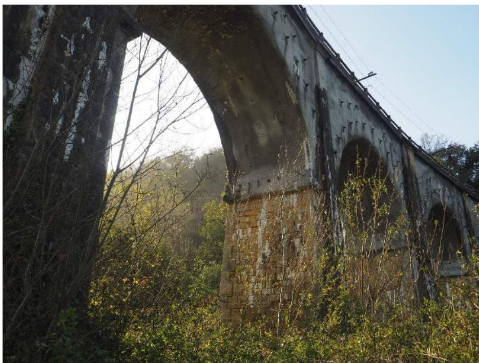
201029 190 Vista inferior de vanos 2, 3 y 4 desde lado izquierdo
