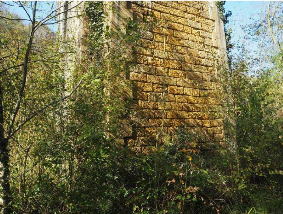
201029 155 Pila 5 lado vano 6 con arenización
