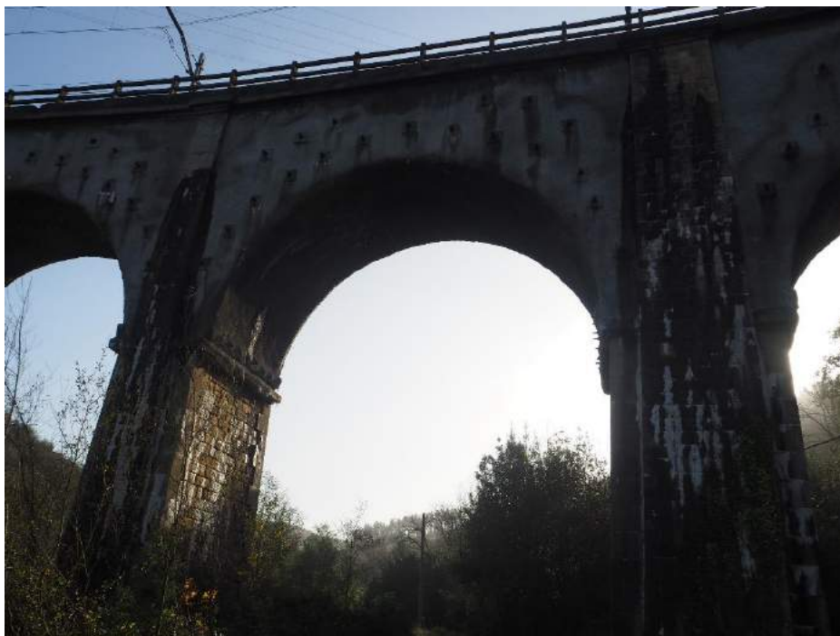
201029 193 Bóveda vano 3 lado izquierdo con bulones y gunita
