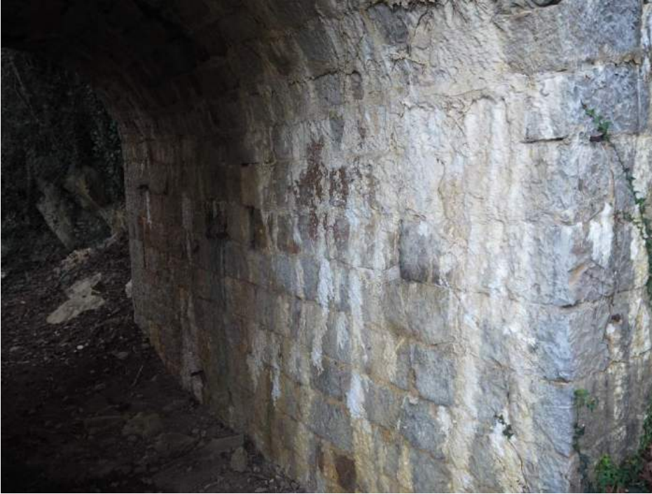
201029 255 Hastial de bóveda para paso de camino en muro en vuelta izquierdo estribo 1
