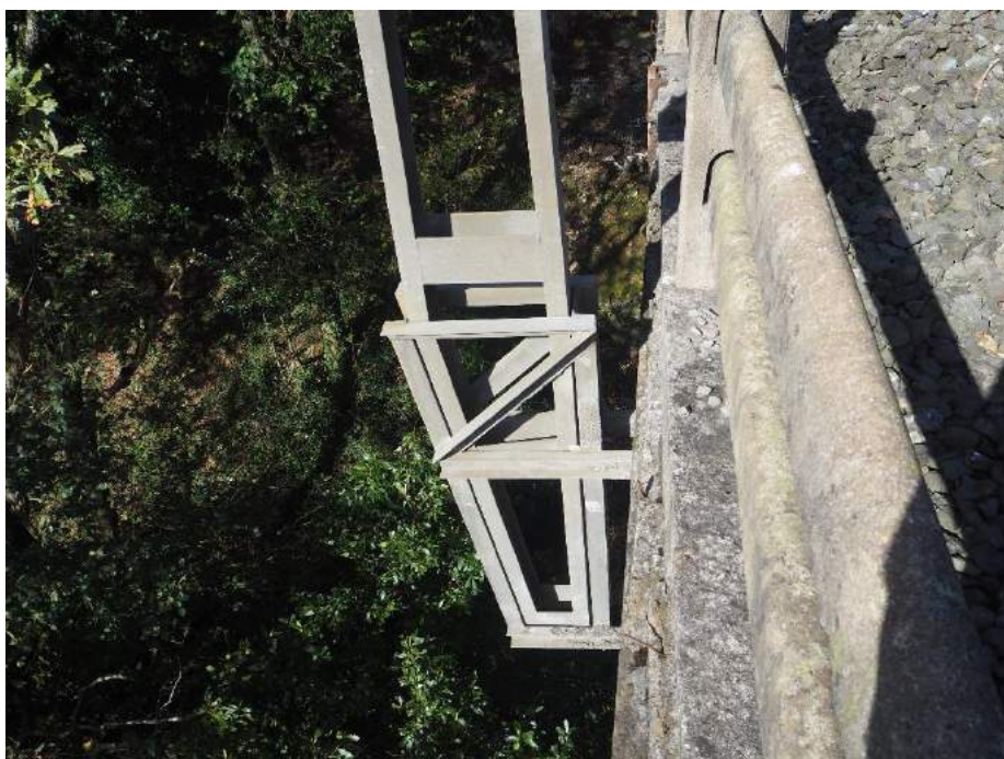
201029 082 Detalle de anclaje de poste de catenaria en lado izquierdo
