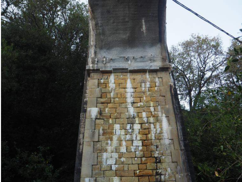
Figura 7. Anclajes en cabeza de pila realizados mediante bolones pasantes
