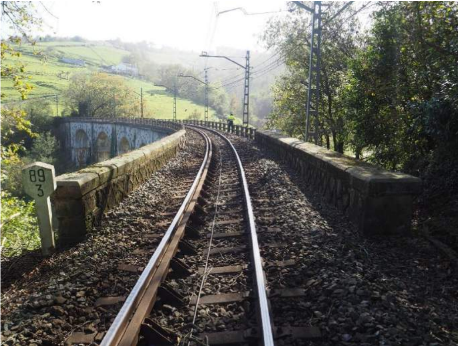
201029 099 Plataforma ferroviaria desde estribo 1
