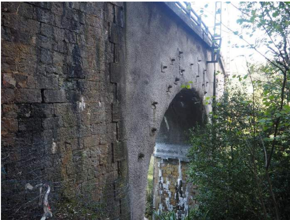
201029 274 Bulones y gunita en bóveda vano 1 lado derecho
