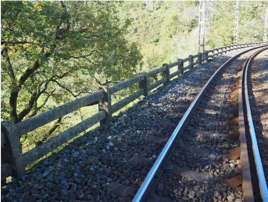
201029 018 Barandilla en lado derecho desde estribo 2
