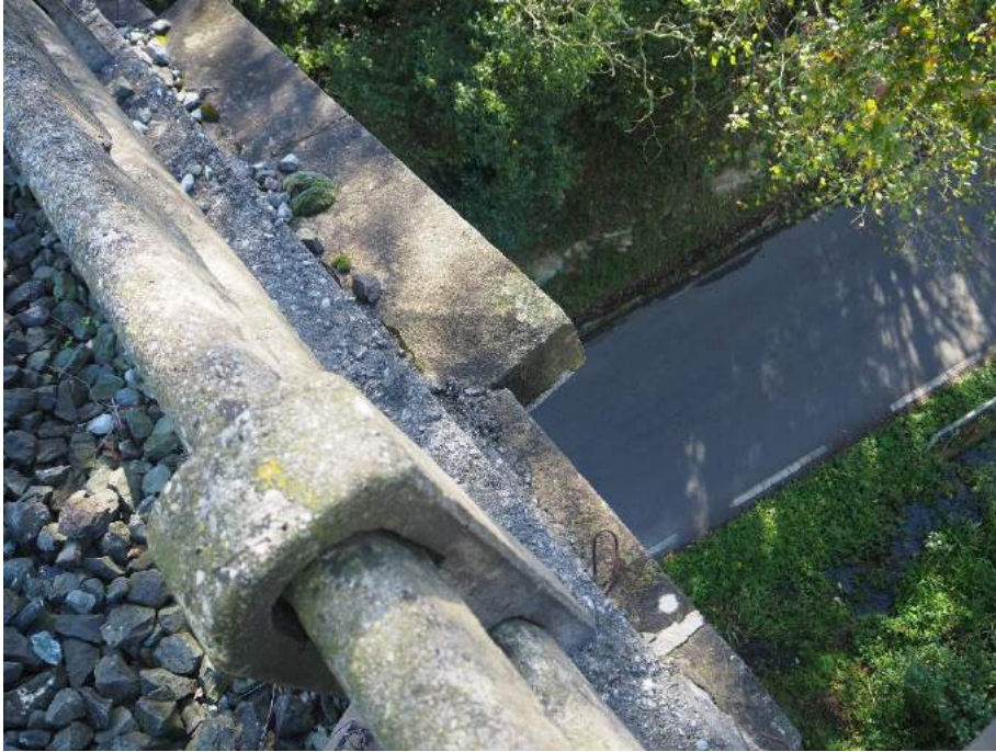
201029 037 Imposta de fábrica en pila 6 lado derecho
