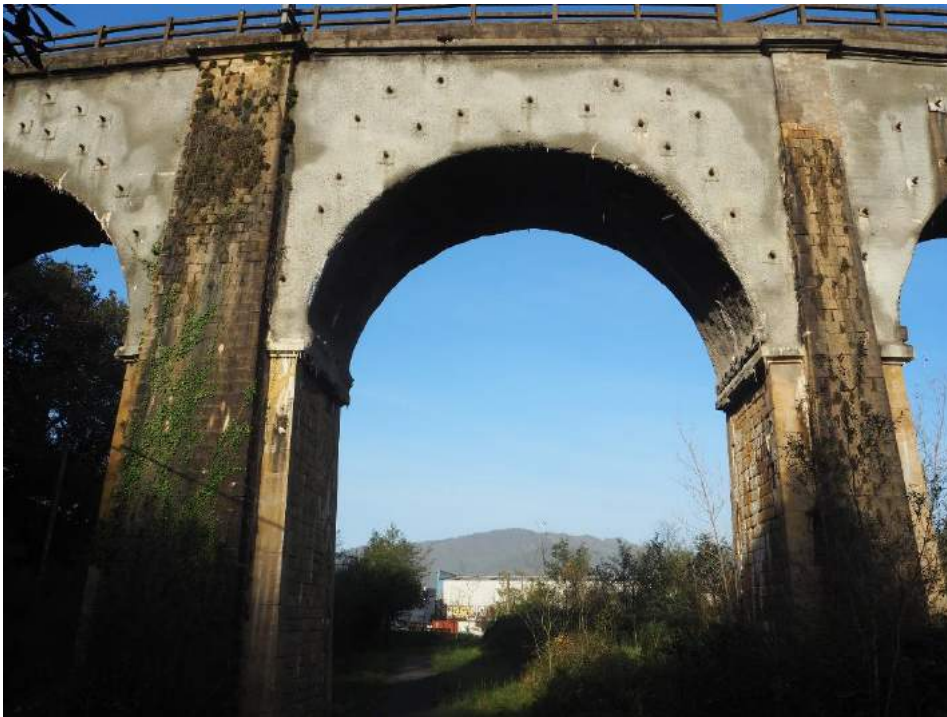
201029 210 Bóveda vano 3 lado derecho con bulones y gunita
