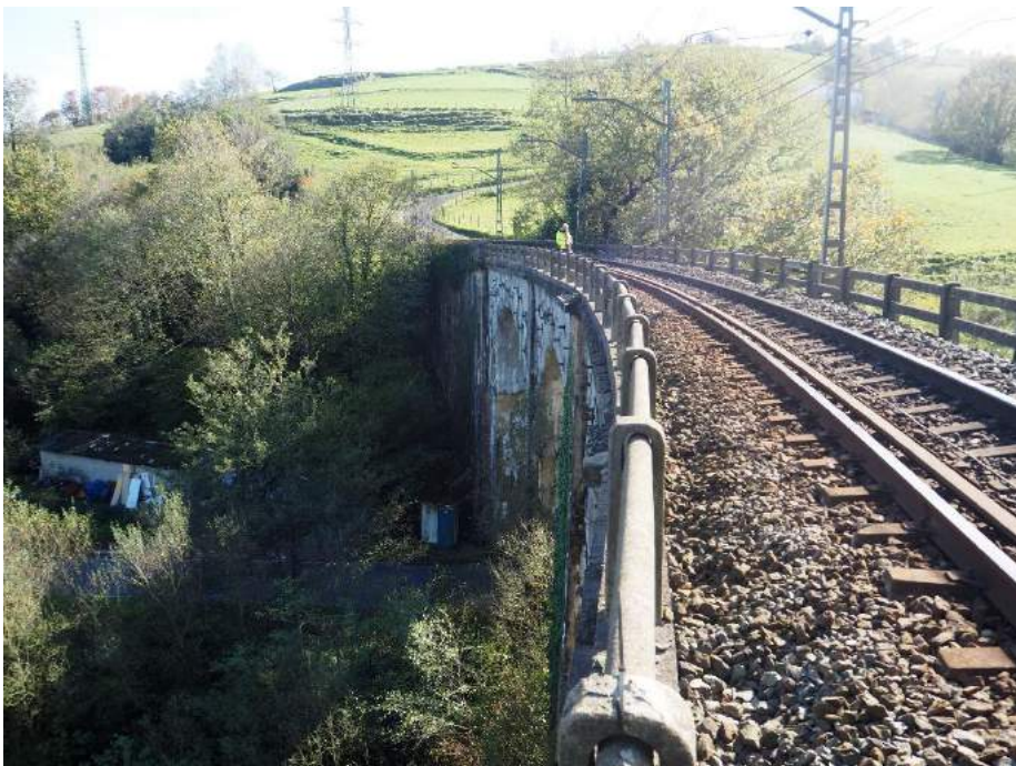
201029 078 Imposta en lado izquierdo desde vano 4 hacia estribo 2
