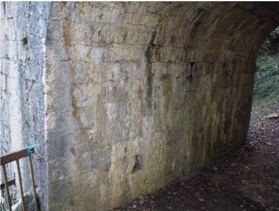
201029 256 Hastial de bóveda para paso de camino en muro en vuelta izquierdo estribo 1
