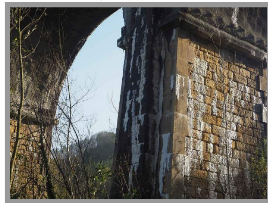
ACTUACIÓN 2 LIMPIEZA GENERAL DE TODOS LOS PARAMENTOS DE FÁBRICA DE PILAS Y MUROS FRONTALES DE ESTRIBOS CON AGUA A PRESIÓN DE HASTA 80 BARES PARA ELIMINACIÓN DE COSTRAS CALCÁREAS, EFLORESCENCIAS E INCRUSTACIONES
