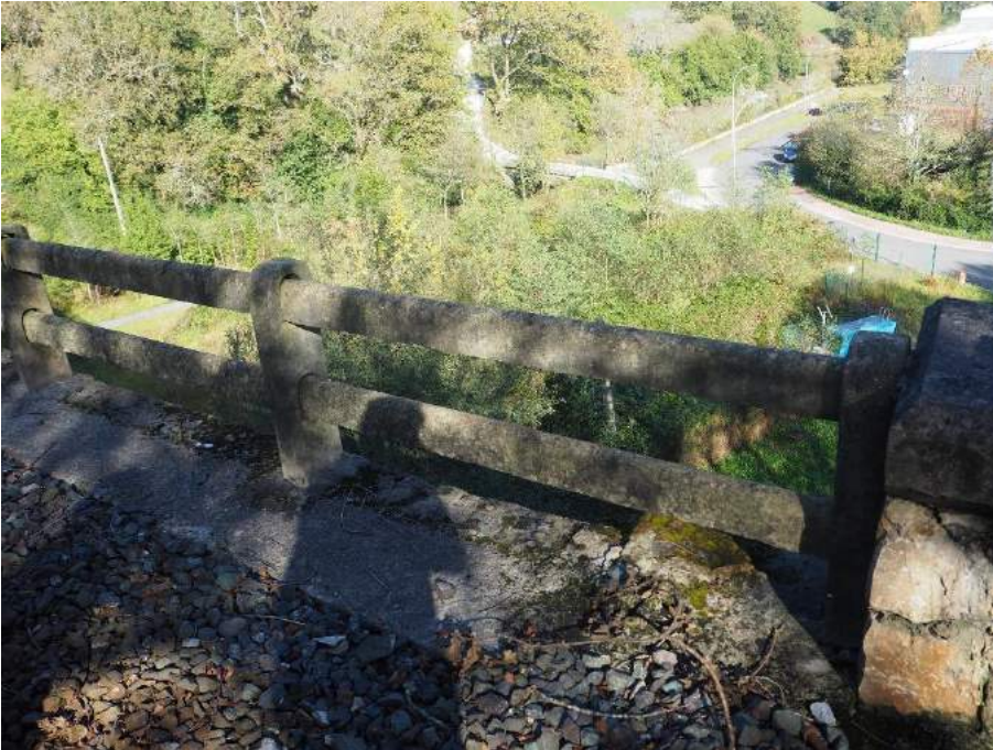
201029 016 Barandilla lado izquierdo junto estribo 2
