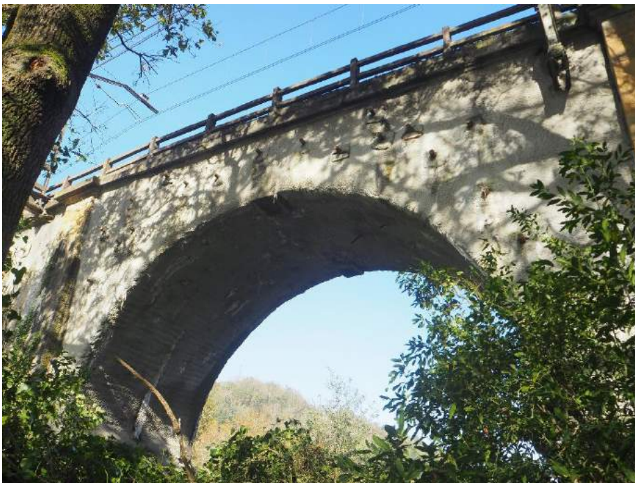
201029 102 Bóveda vano 7 lado derecho con bulones y gunita
