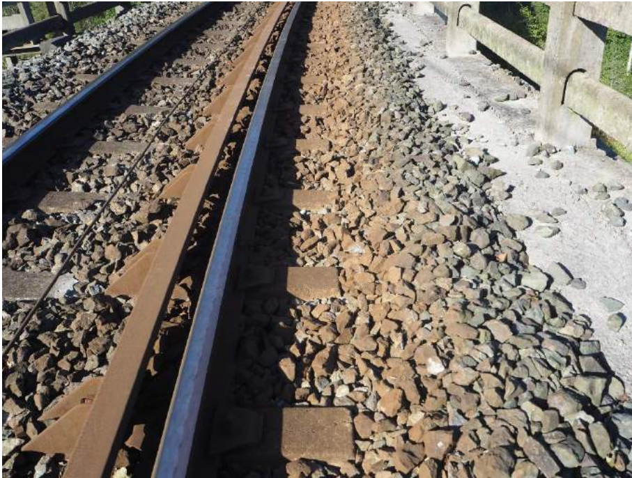
201029 046 Barandilla y banqueta de balasto en lado izquierdo
