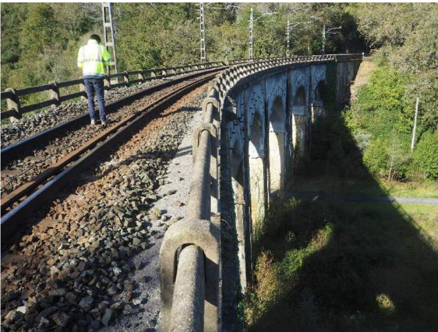
201029 040 Deformación en imposta por asiento en lado izquierdo
