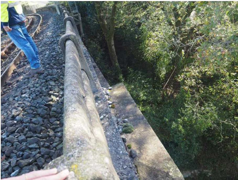
201029 038 Imposta de fábrica en pila 6 lado derecho
