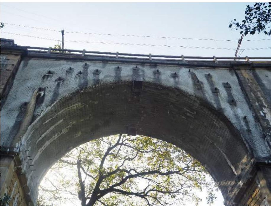
201029 116 Bóveda vano 7 lado izquierdo con bulones y gunita
