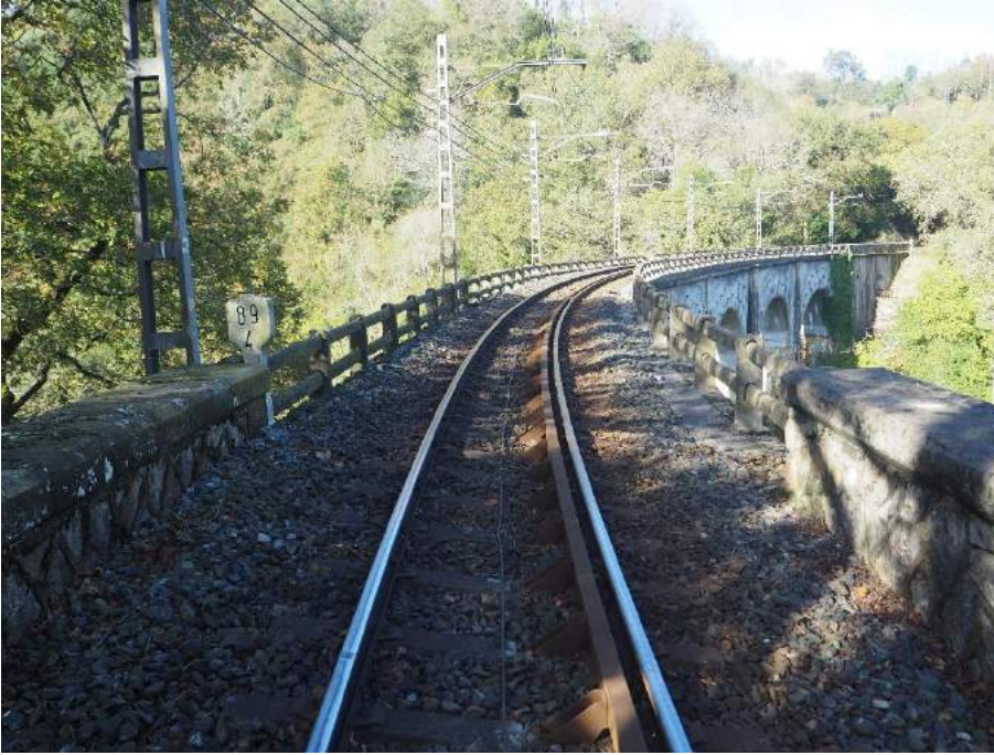
201029 015 Plataforma desde estribo 2
