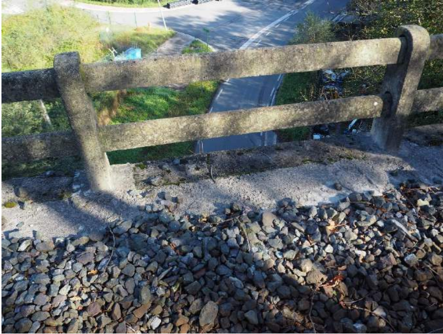
201029 029 Barandilla y canalta de hormigón en lado izquierdo sobre vano 7
