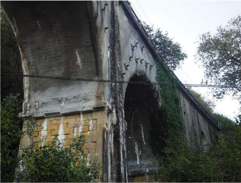
201029 247 Vista inferior de bóveda vano 1
