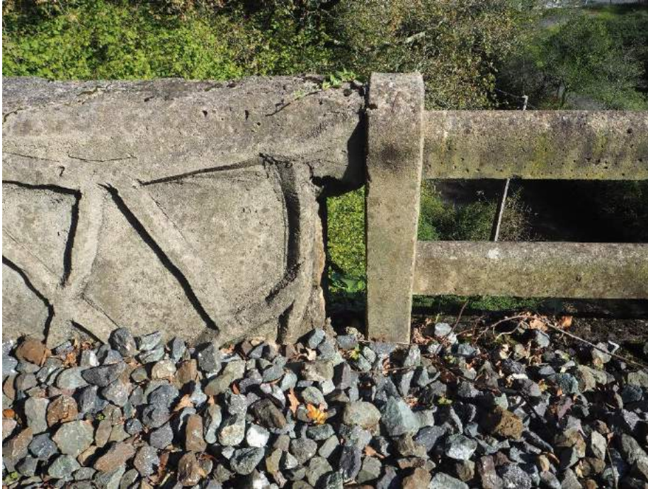
201029 085 Conexión de murete derecho de fábrica con barandilla en estribo 1
