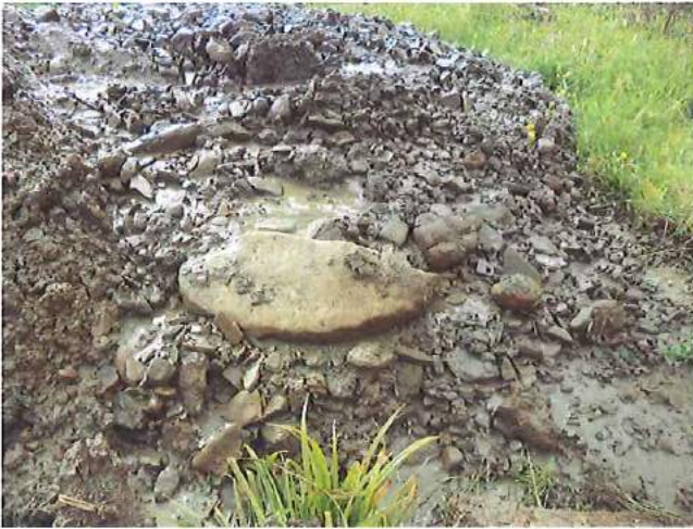
Relleno dispuesto sobre el terreno natural, extraído durante la ejecución de la calicata C-P3
