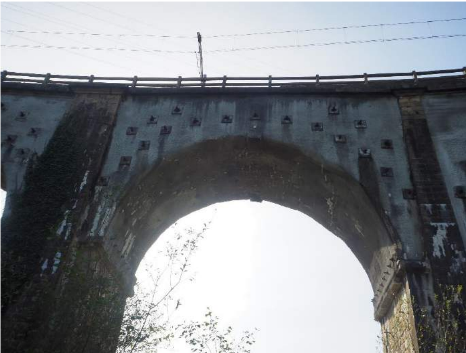
201029 140 Bóveda vano 5 lado izquierdo con bulones y gunita
