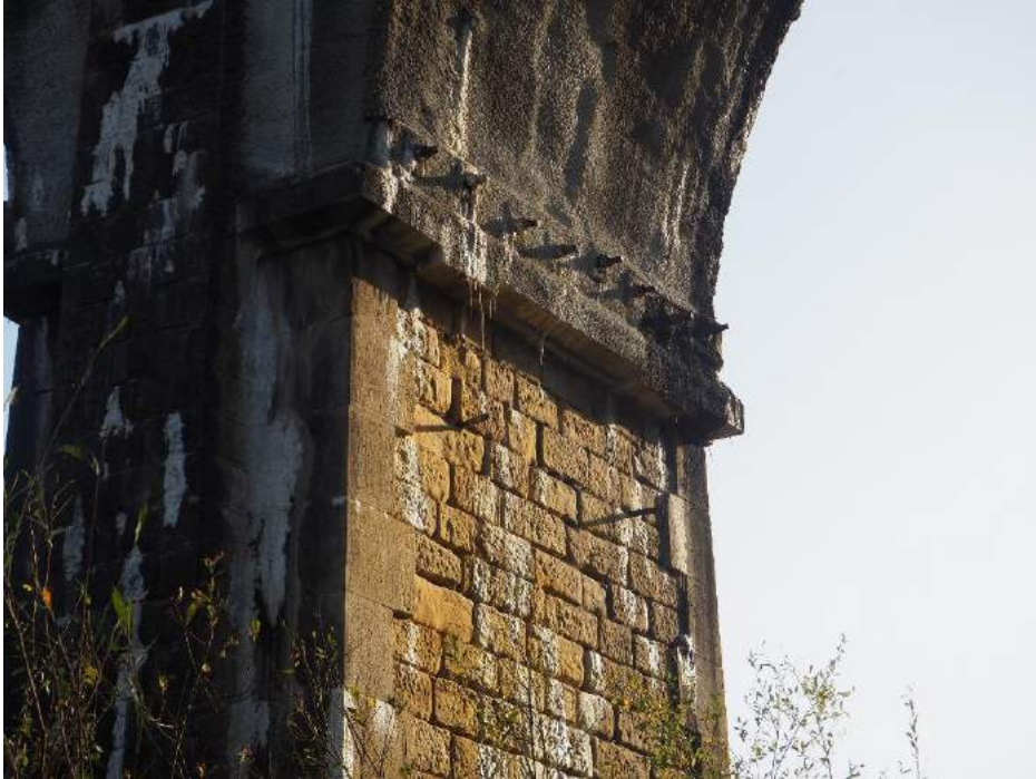
201029 181 Anclajes en cabeza de pila 4 lado vano 4 y mechinales
