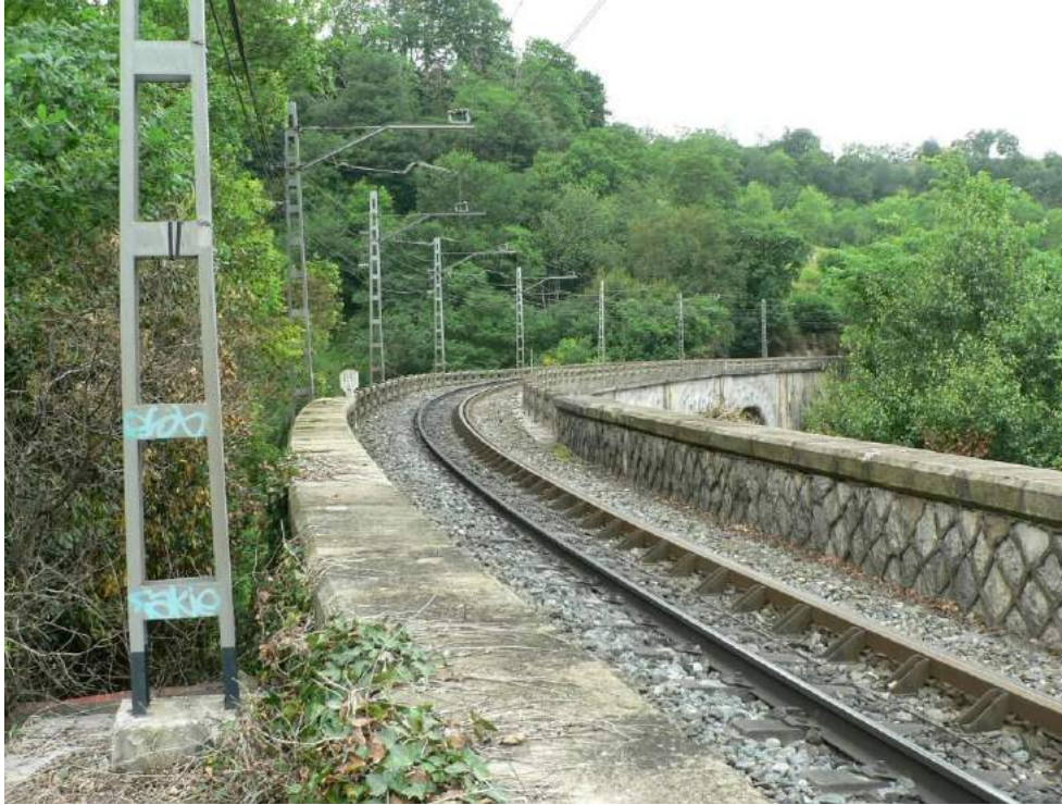
Figura 3. Vista de la plataforma desde el estribo 2
