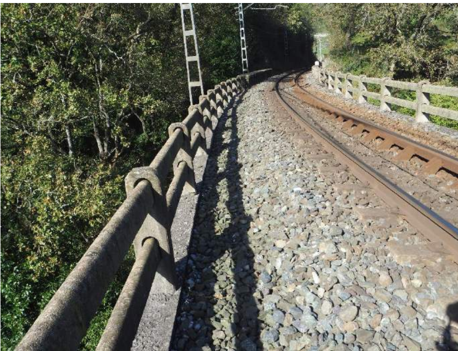
201029 080 Banqueta de balasto en lado derecho sobre vano 4
