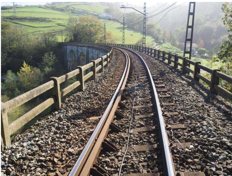
Figura 3. Vista de la plataforma desde el estribo 1
