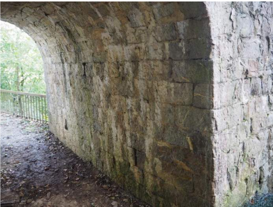
201029 272 Hastial de bóveda para paso de camino en muro en vuelta derecho estribo 1
