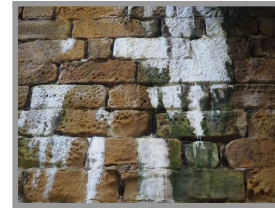
ACTUACIÓN 5 APLICACIÓN DE HIDROFUGANTE-CONSOLIDANTE EN TODA LA SUPERFICIE DE PILAS
