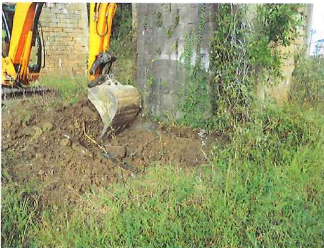
Ejecución de calicata C-P3
