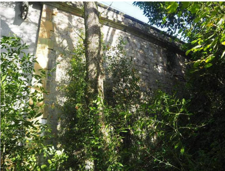
201029 100 Muro en vuelta derecho estribo 2
