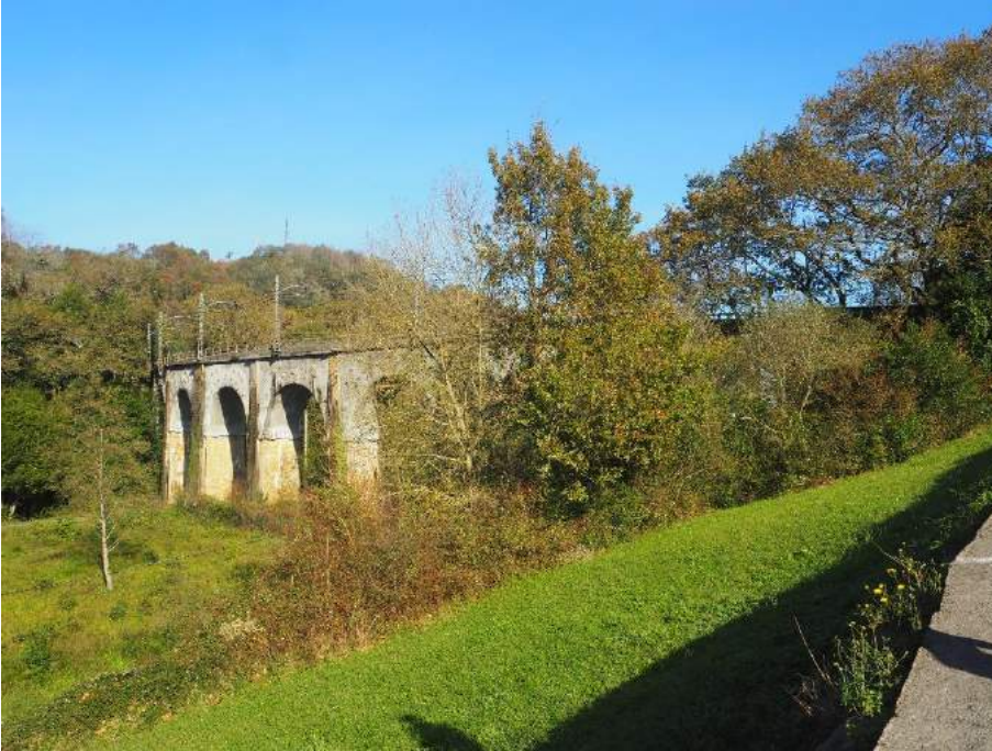
201029 003 Vista en escorzo desde estribo 2 lado derecho
