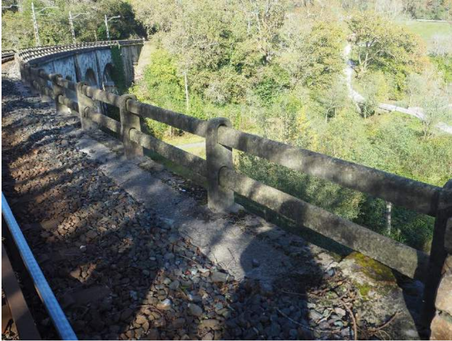
201029 017 Barandilla y canalta de hormigón en lado izquierdo desde estribo 2
