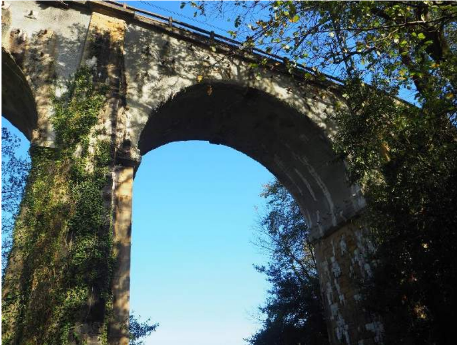
201029 105 Anclaje de poste de catenaria en bóveda vano 7 lado derecho
