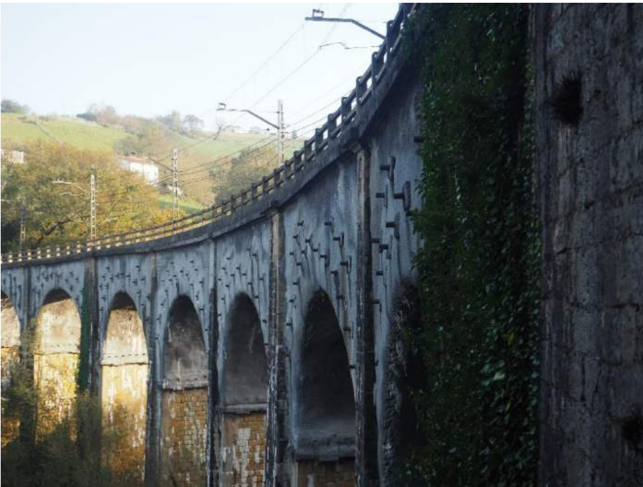
201029 260 Deformación en imposta por asiento en lado izquierdo
