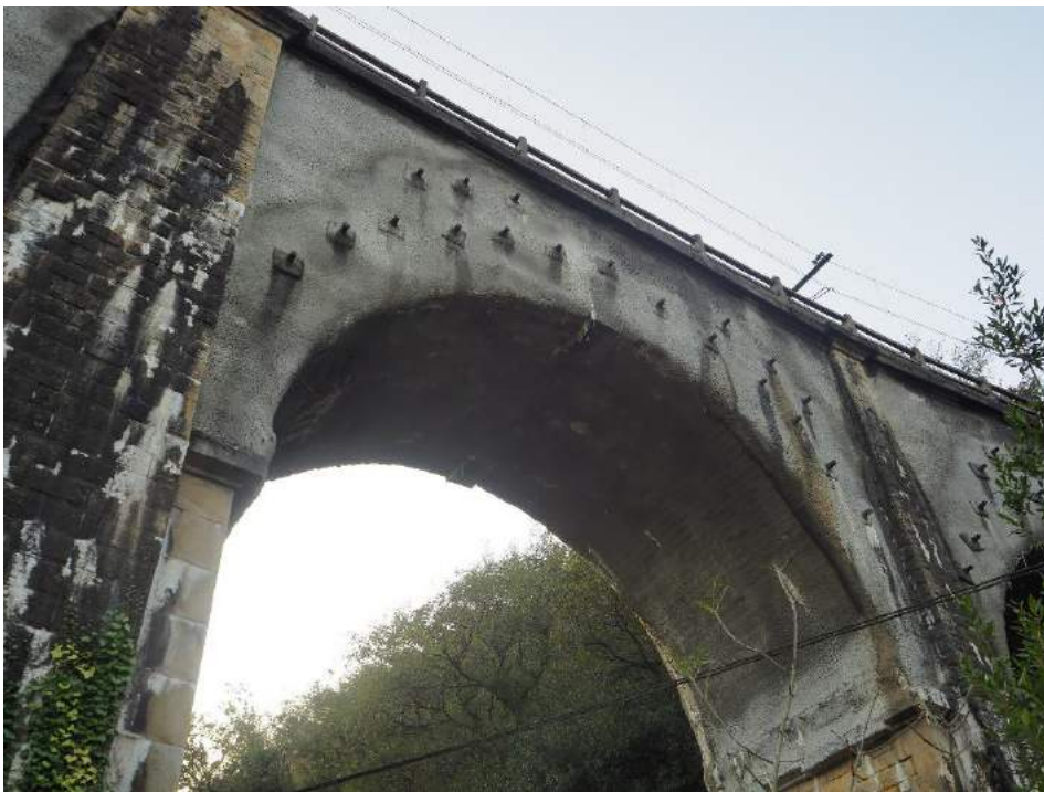
201029 246 Bóveda vano 2 con bulones y gunita
