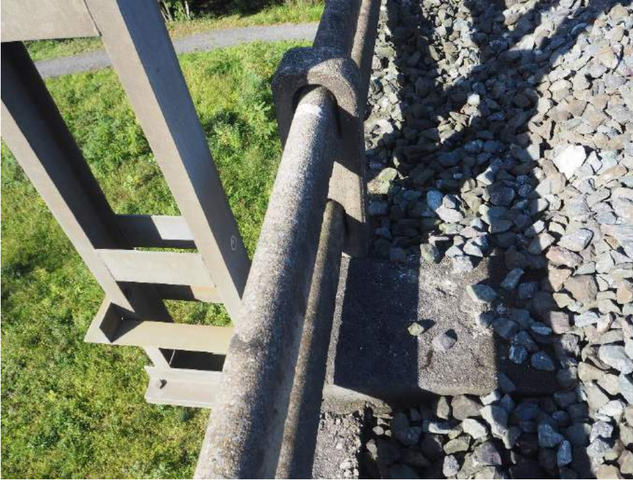
201029 051 Zuncho de anclaje de poste de catenaria en lado derecho
