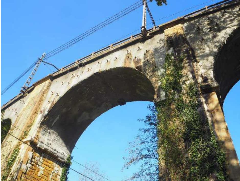
201029 129 Bóveda vano 6 lado derecho con bulones y gunita
