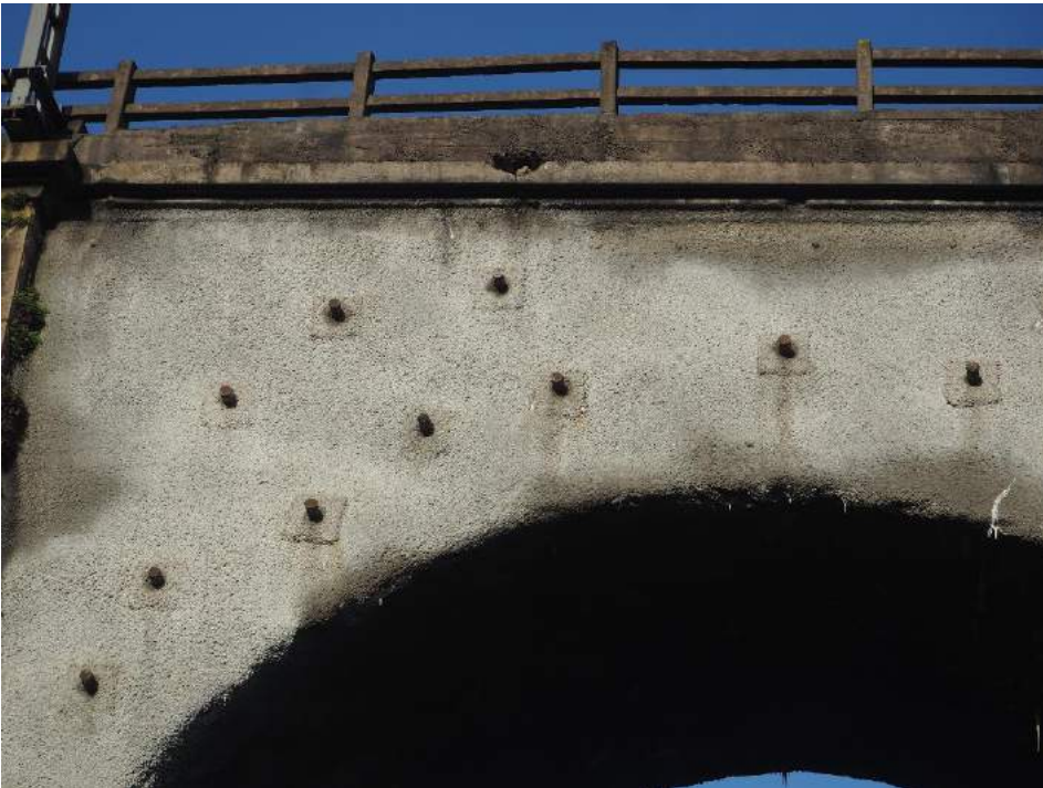
201029 212 Anclajes de bulones en bóveda vano 3 lado derecho
