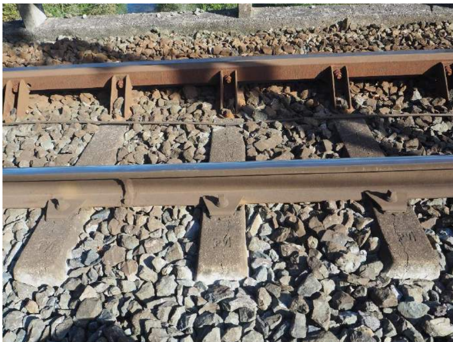
201029 081 Traviesas fisuradas
