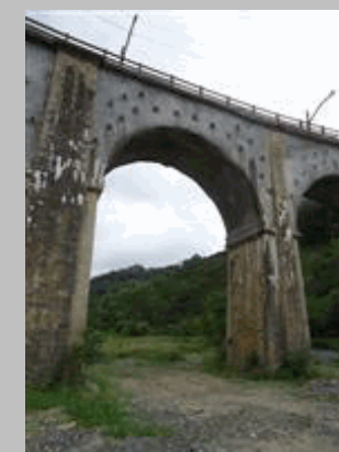
27 Vista de vano 5
