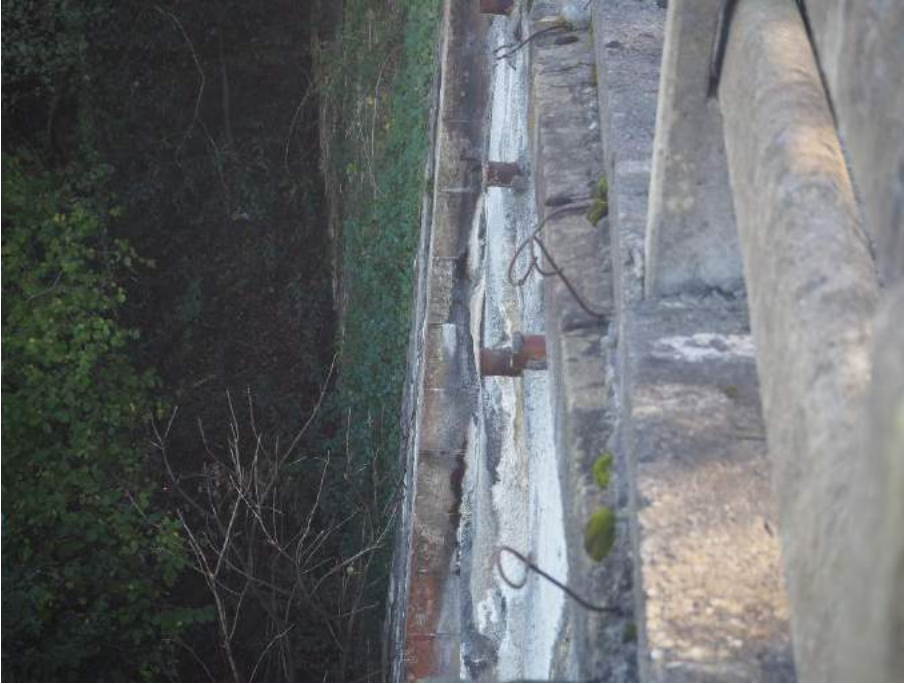
201029 043 Bulones y gunita en vano 7 lado izquierdo
