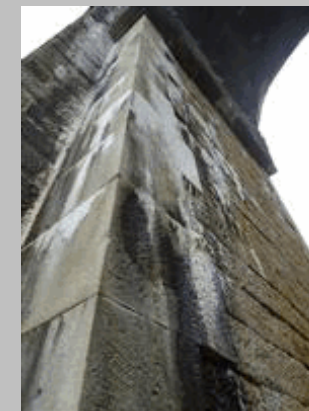
38 Costras calcáreas en pila
