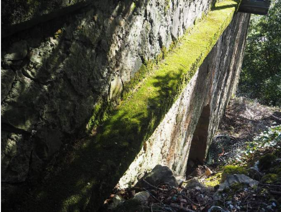
201029 097 Bóveda de paso de camino y muro en vuelta derecho de estribo 1
