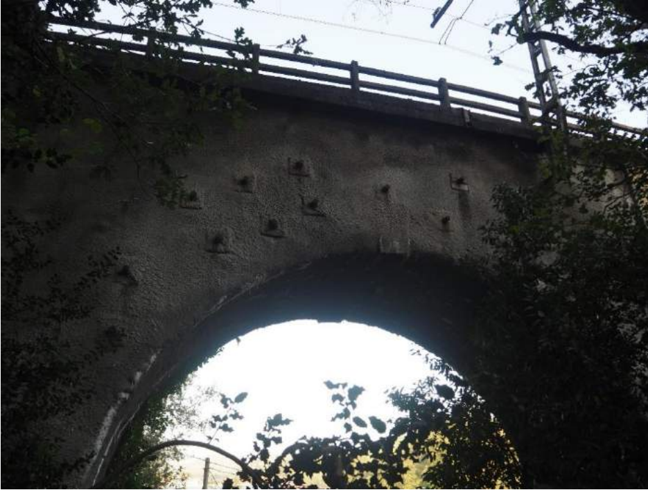
201029 275 Bulones y gunita en bóveda vano 1 lado derecho
