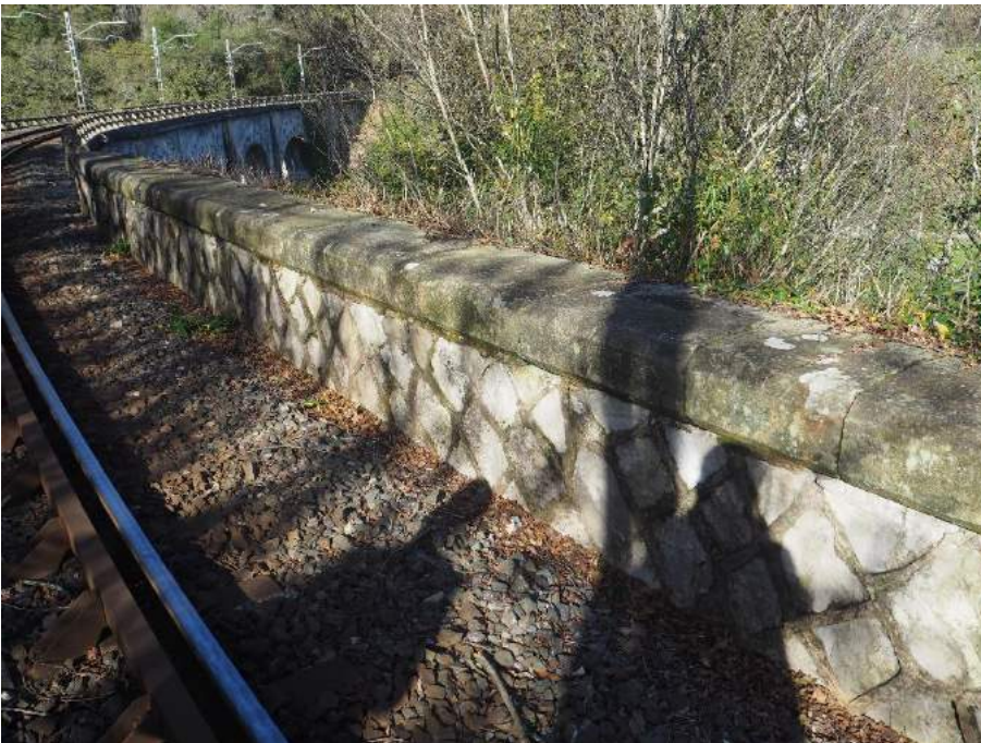
201029 012 Murete izquierdo de fábrica en buen estado
