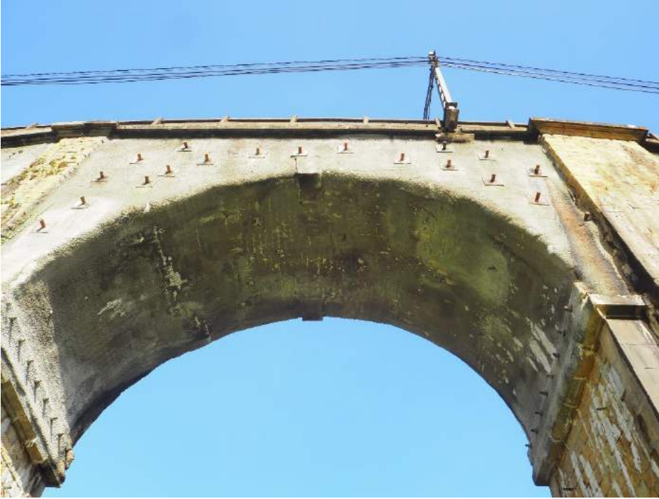
201029 163 Bóveda vano 5 lado derecho con bulones y gunita
