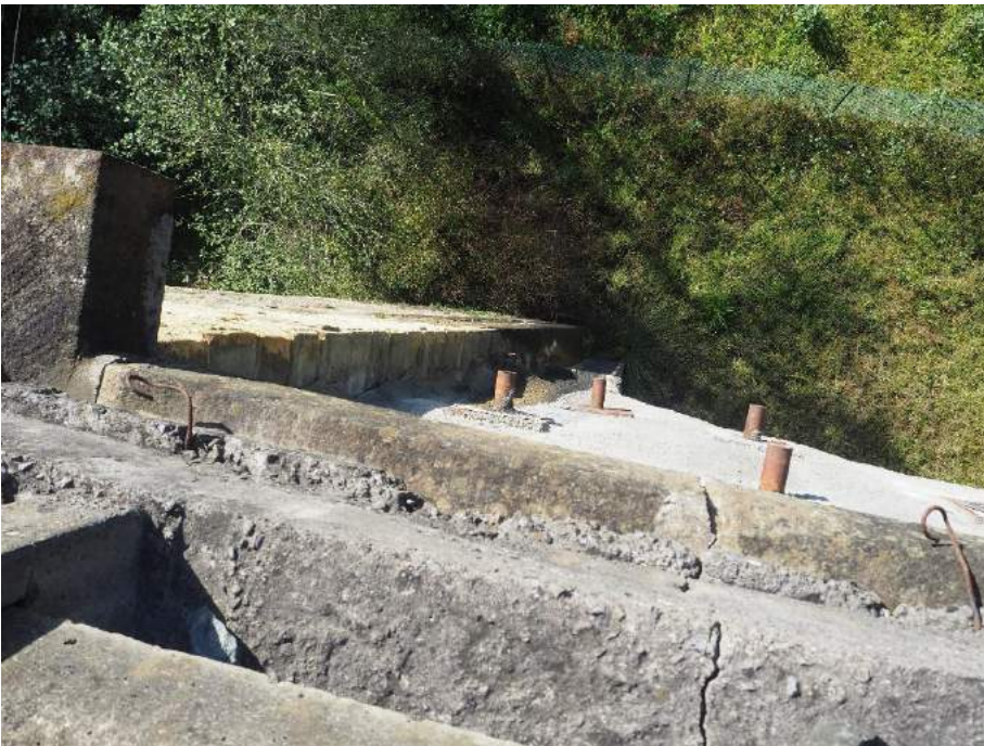
201029 052 Bulones y gunita en vano 5 lado izquierdo
