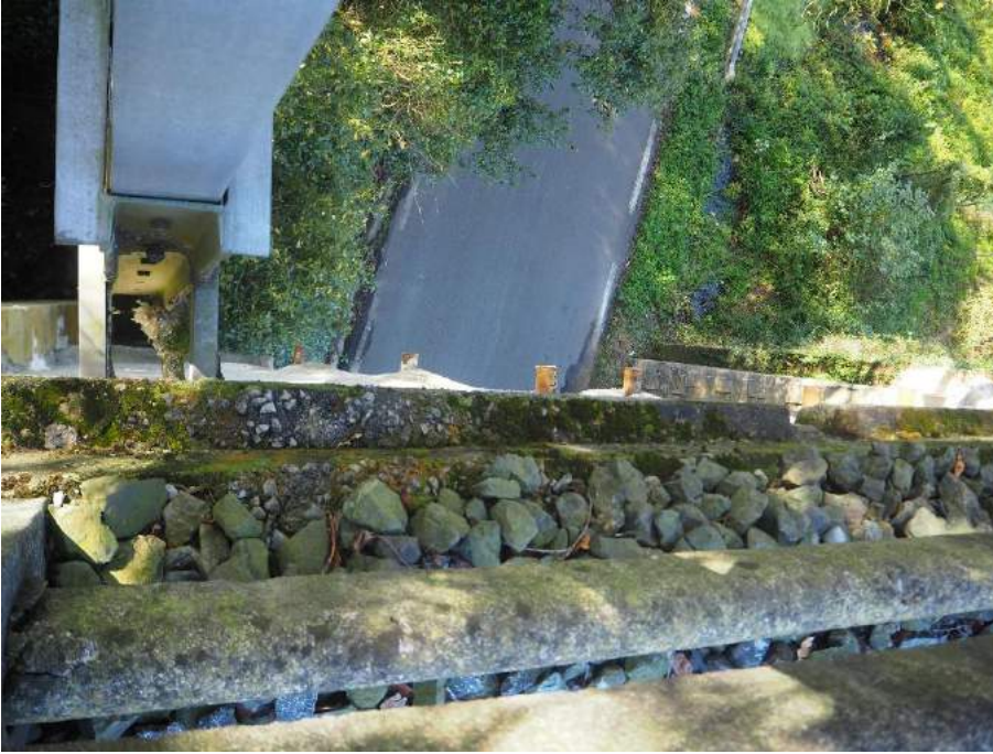
201029 023 Anclaje de poste de catenaria y bunones en lado derecho estribo 2
