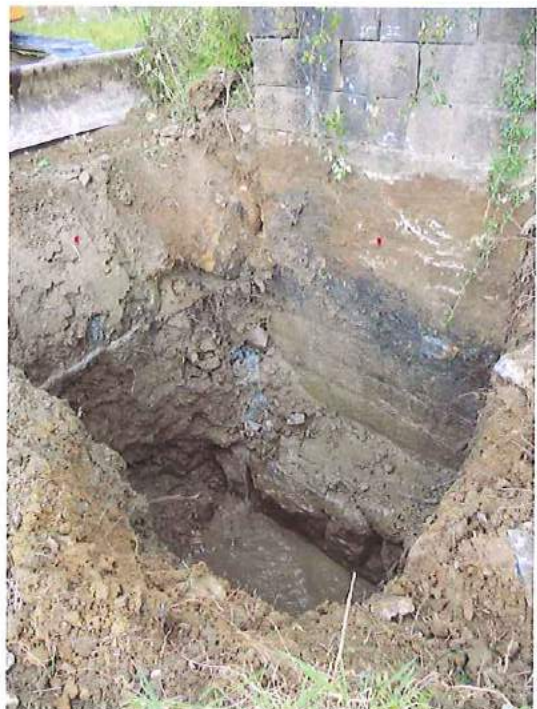
Cimentación y terreno de alrededor en la calicata C-P3
