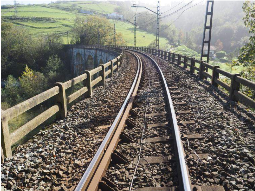
Figura 3. Vista de la plataforma desde el estribo 1
