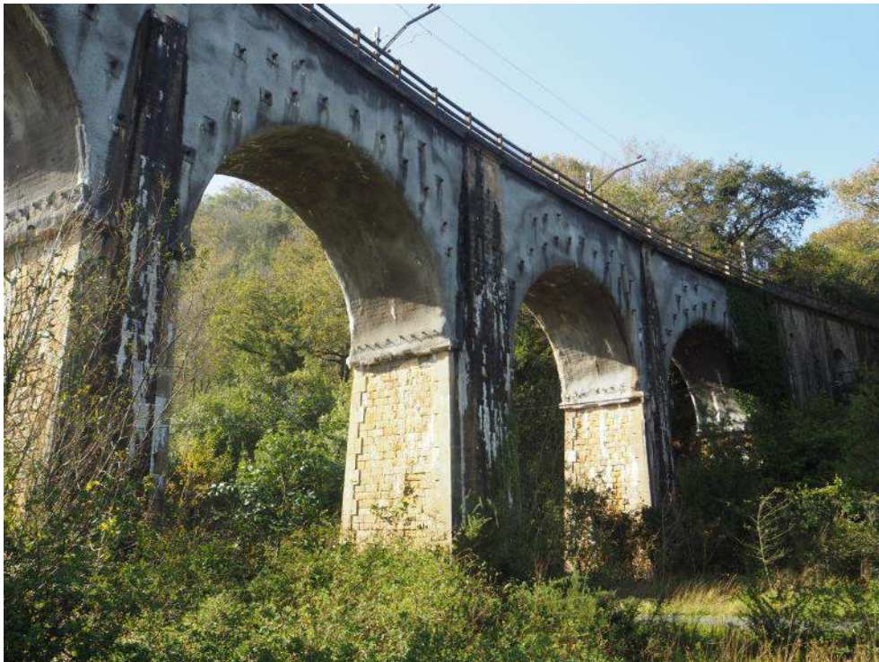
Figura 5. Vista de las pilas de la estructura
