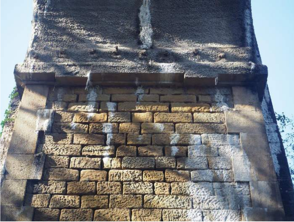
201029 123 Bulones en pila 6 y arranque de bóveda
