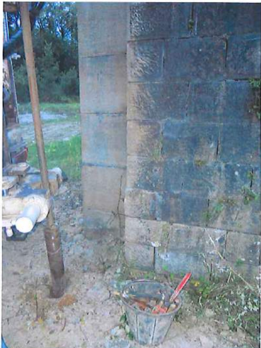
Equipo de sondeo emplazado junto a uno de los apoyos del puente
