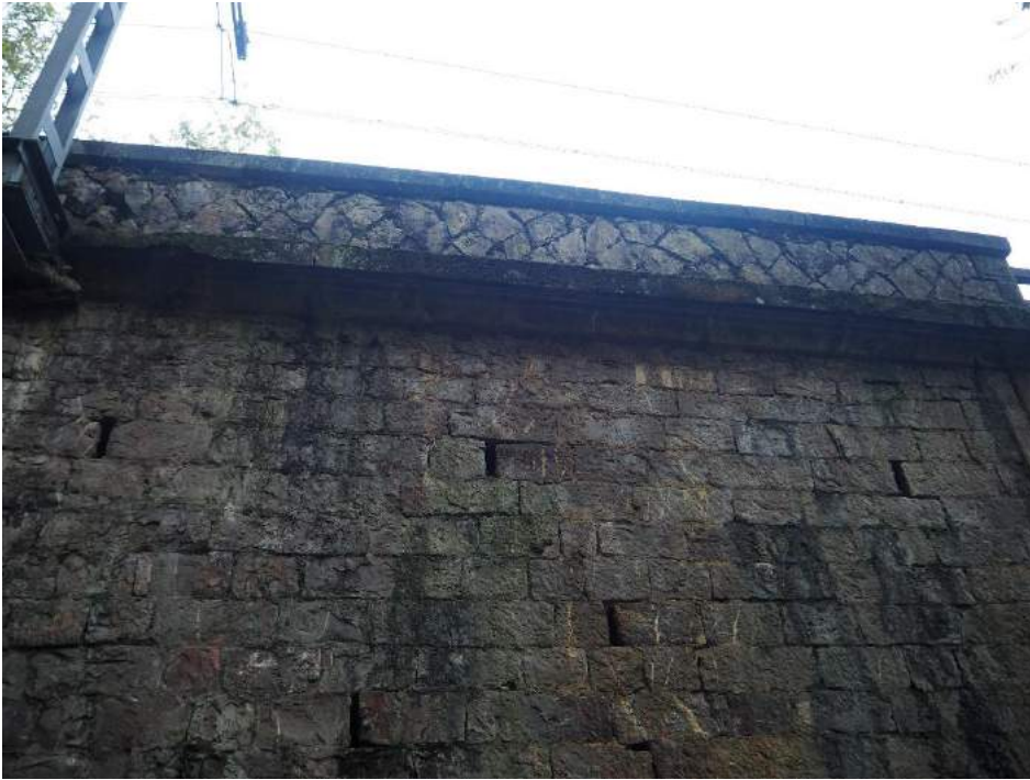
201029 269 Murete de plataforma lado derecho
