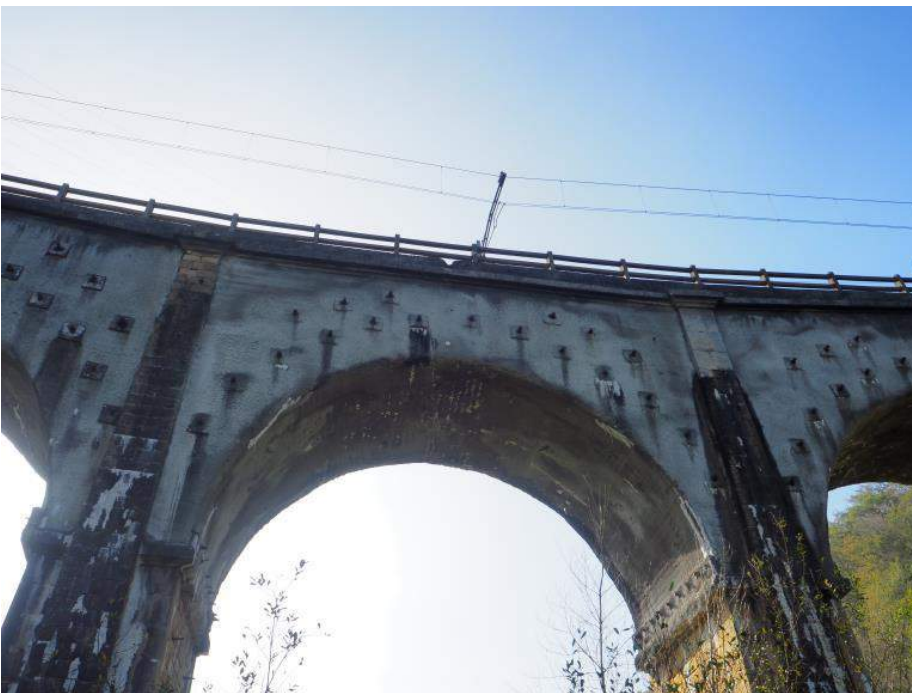
Figura 3.2.4. Vista de una de la bóveda del vano 4
