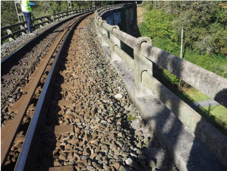
201029 058 Barandilla y banqueta de balasto en lado derecho
