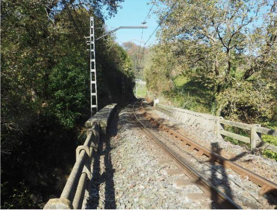
201029 083 Plataforma sobre estribo 1
