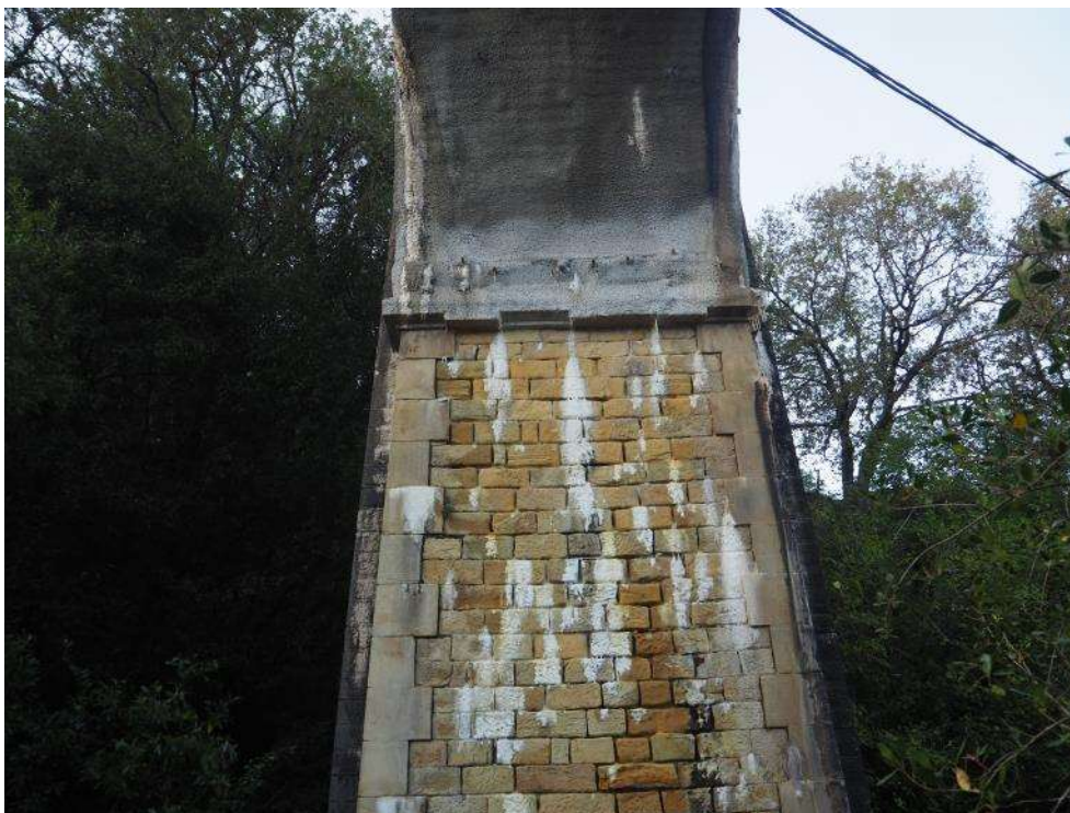
Figura 7. Anclajes en cabeza de pila realizados mediante bulones pasantes
