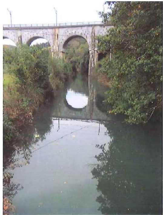
Arroyo bajo el vano 6
