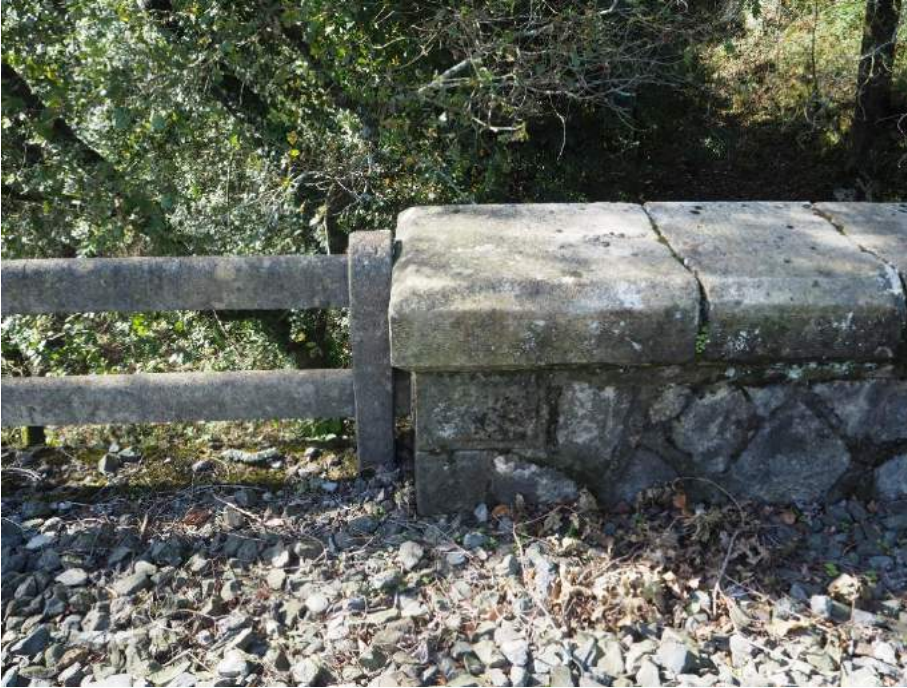
201029 087 Conexión de murete izquierdo de fábrica con barandilla en estribo 1
