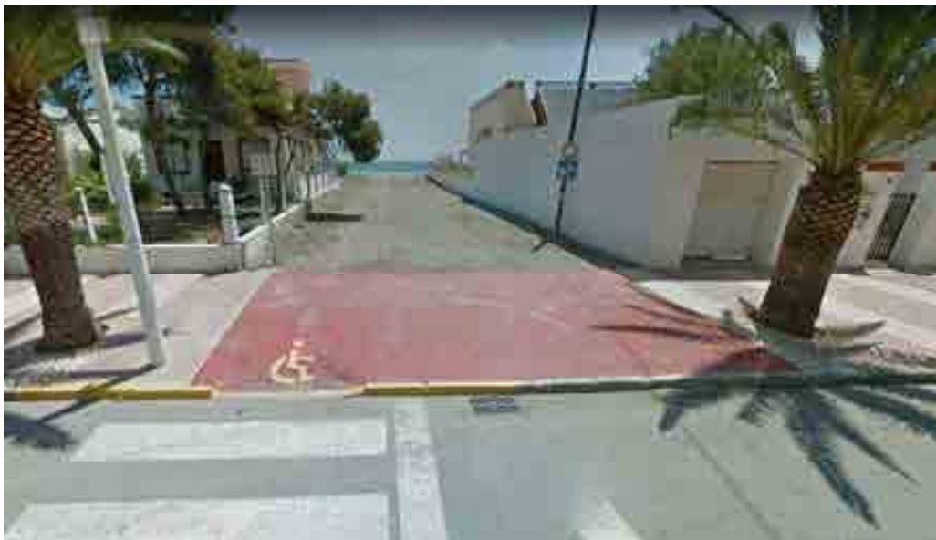
Ejemplos de travesías sin pavimentación en la zona Sur de la Avda. Mare Nostrum.
