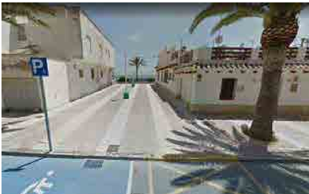
Ejemplos de travesías pavimentadas en la zona Norte de la Avda. Mare Nostrum.
