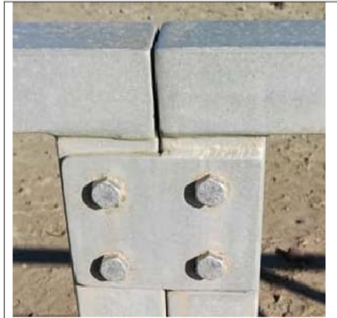
Imagen 18: Tornillería dispuesta en barandillas de la pasarela y del mirador.
