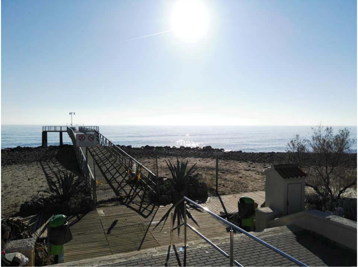
Vista general de la pasarela y pantalán objeto de la actuación.
