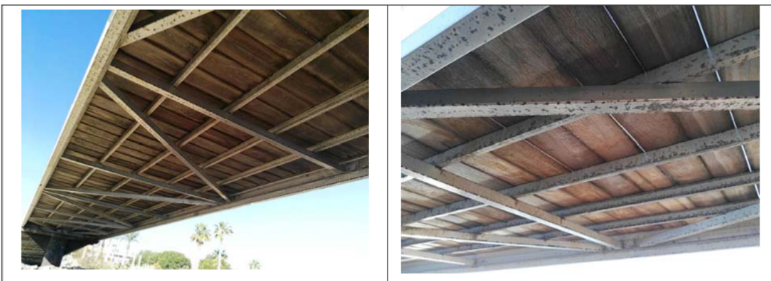
Imagen 19 y 20: Vista de la estructura triangulada de aluminio que forma el tablero de la pasarela..
