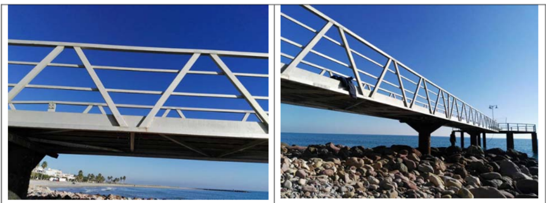
Imagen 21 y 22: Vista de la celosía lateral de la pasarela.
