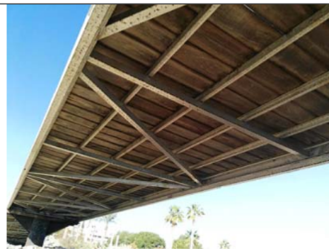
Imagen 5. Vista estructura triangular del tablero
