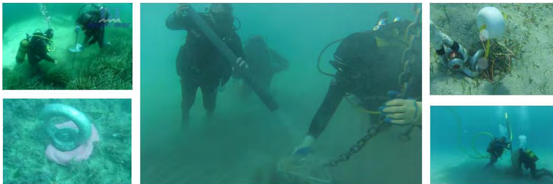
Imágenes del proceso de instalación de los anclajes.
