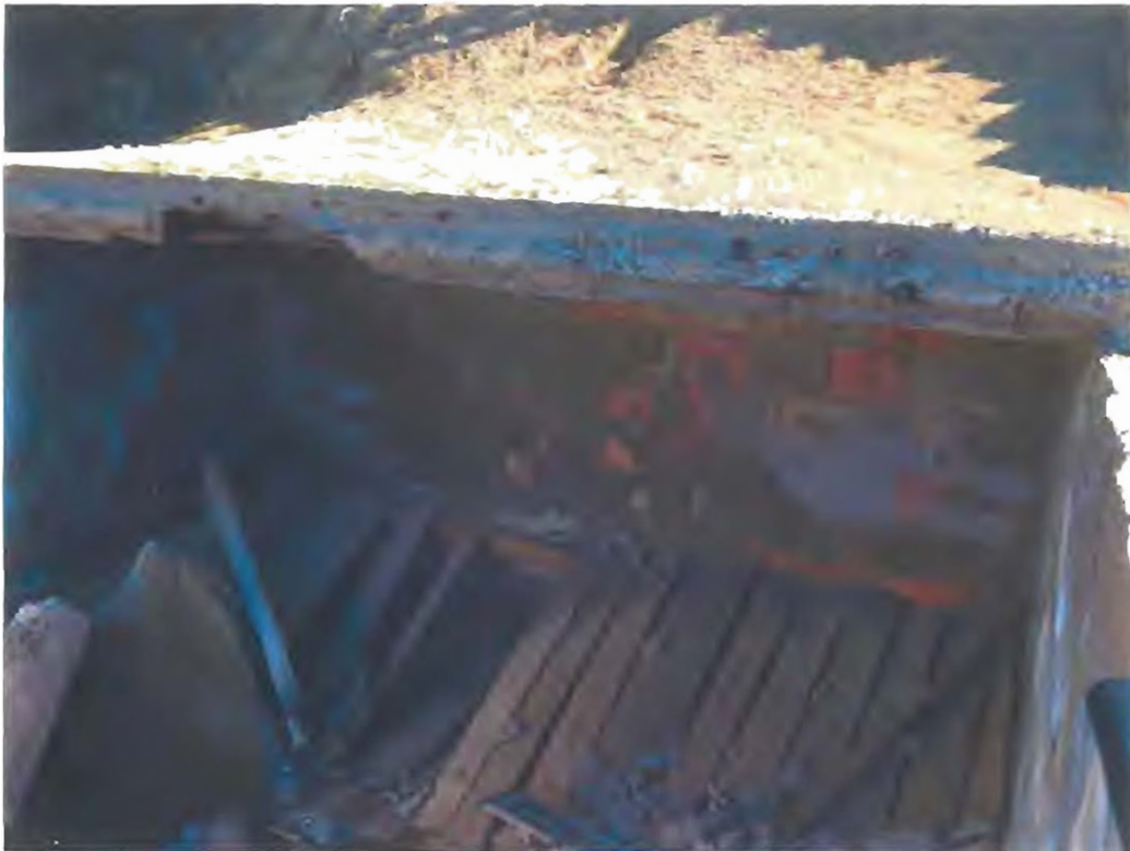
Estado de la zona posterior
