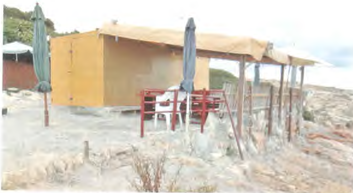
Foto 1. Vista de Instalaciones en zona de dominio público
