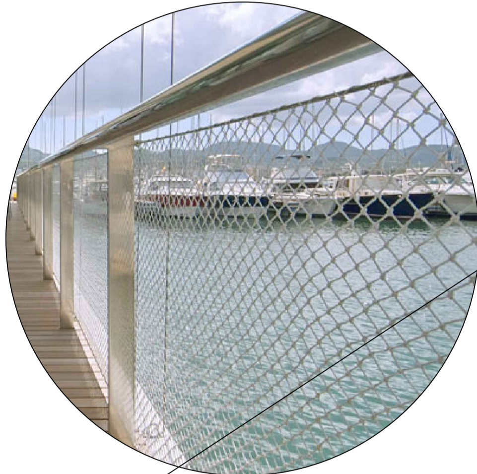
DETALLE BARANDILLA PERIMETRAL DE ACERO INOXIDABLE Y ENTRAMADO DE CUERDA
