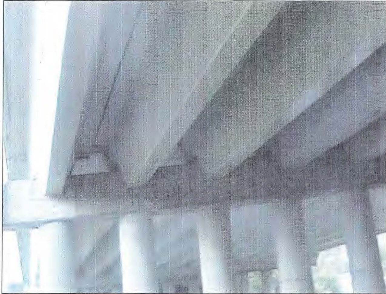
Foto 5. Vista de la estructura del Puente Internacional de Bidasoa.
