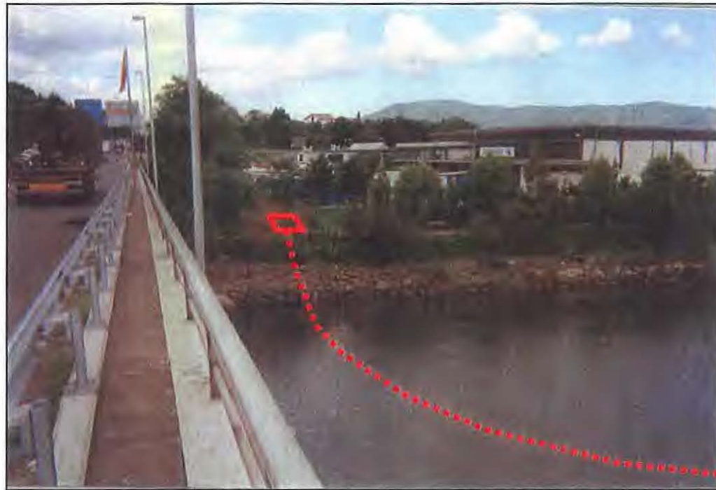
Perforación. Visita general desde el lado francés
