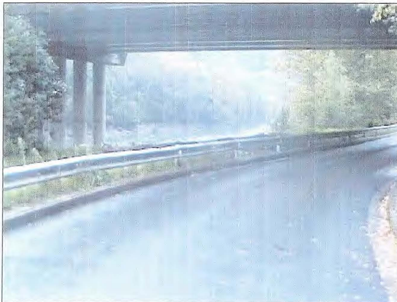
Foto 1. Vista del Puente Internacional de Bidasoa. También se observa el río Bidasoa y la carretera por debajo del puente.
