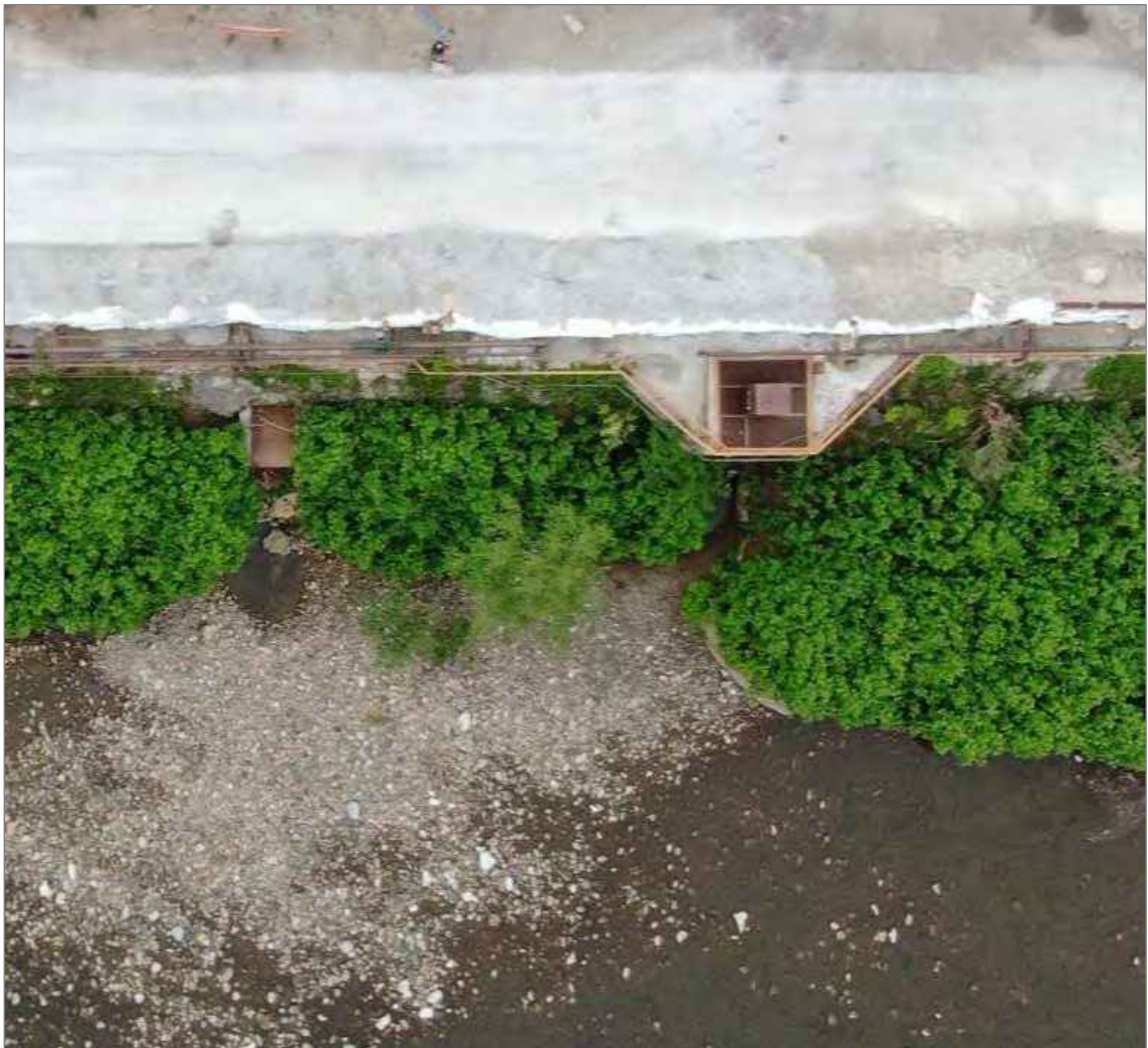
Fotografía 12. Puntos de Vertido 1 y 2 a la Ría de San Martín de la Arena.
