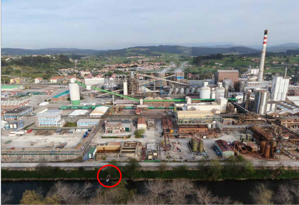
Fotografía 19. Punto de Vertido 3 de SOLVAY QUÍMICA, S.L.: Salida actual de agua tratada tras EDARI en la margen derecha de la Ría de San Martín de la Arena.
