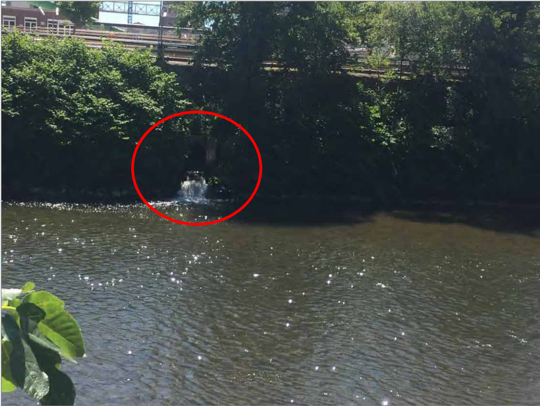
Fotografía 15. Punto de Vertido 3: Salida de agua tratada de la EDARI.
