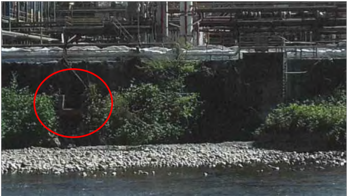
Fotografía 14. Punto de Vertido 2: Salida de la alcantarilla secundaria de achique, actualmente cubierta por vegetación.
