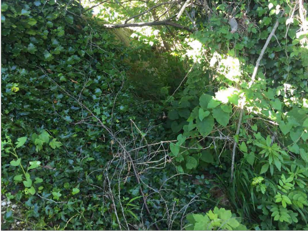
Fotografía 28. Punto de Vertido 3: Detalle del muro de encauzamiento de la ría, cubierto por vegetación, en zona de salida del tubo de agua tratada de la EDARI.
