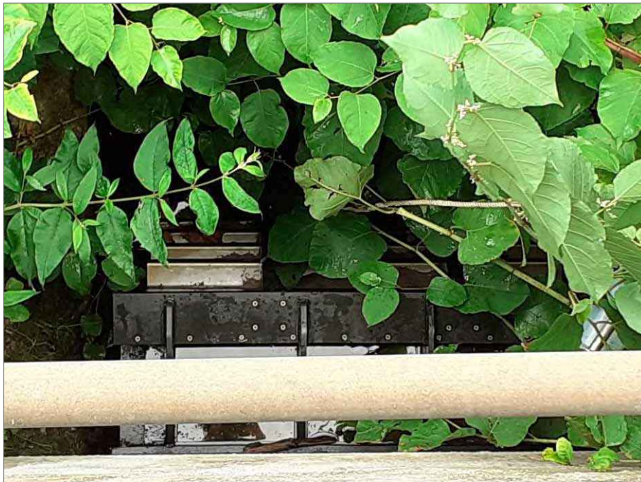
Fotografía 3. Punto de Vertido 1: Detalle de compuerta tipo clapeta antirretorno.
