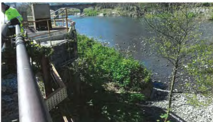
1. Arqueta del aliviadero
