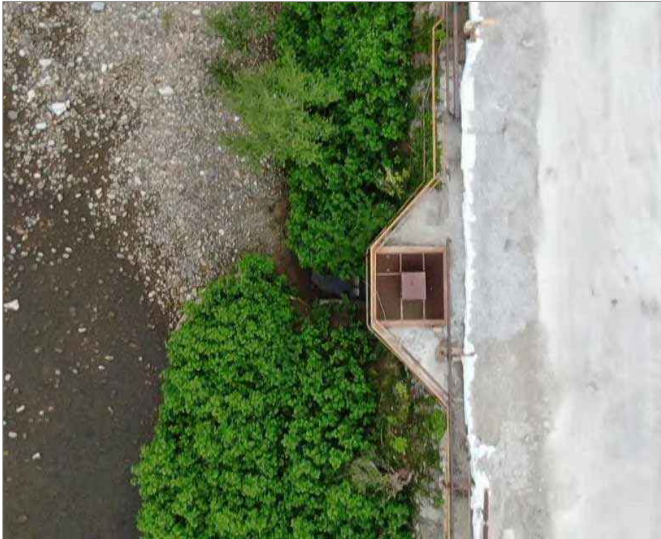
Fotografía 1. Vista aérea de infraestructuras asociadas al Punto de Vertido 1 (Ocupación DPMT= 13,7 m 2 )
