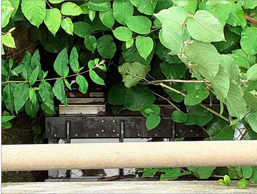
Fotografía 7. Punto de Vertido 1: Detalle de compuerta tipo clapeta antirretorno.
