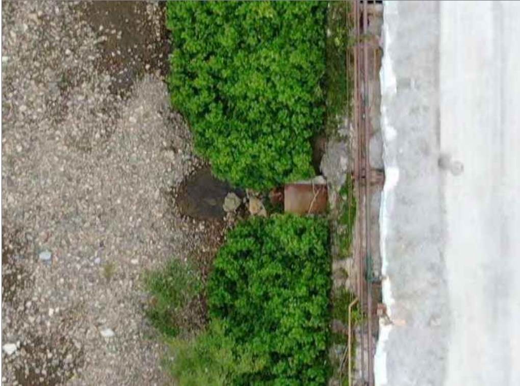
Fotografía 5. Vista aérea de infraestructuras asociadas al Punto de Vertido 2 (Ocupación DPMT= 4 m 2 ).
