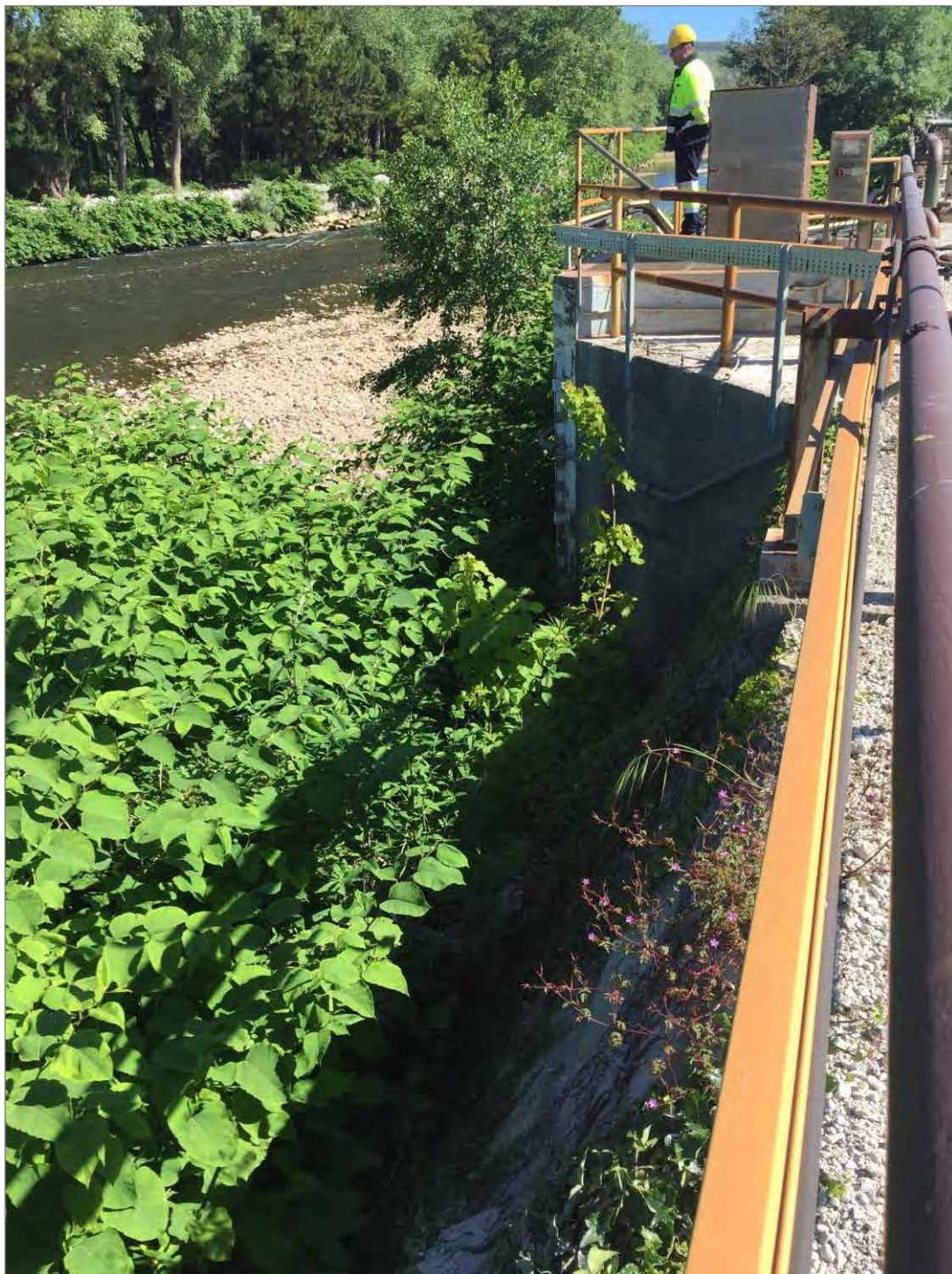
Fotografía 4. Punto de Vertido 1: Arqueta asociada al vertido ubicada en zona de dominio público marítimo-terrestre (vista hacia aguas abajo).
