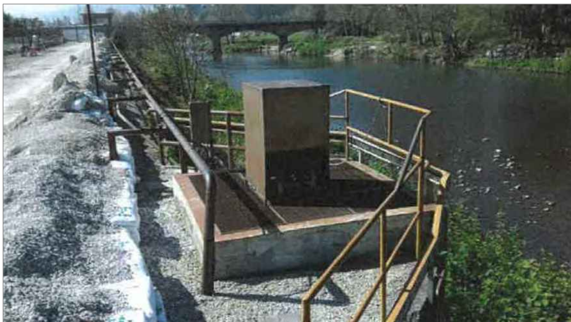
Fotografía 5. Punto de Vertido 1: Detalle de la arqueta asociada al vertido ubicada en zona de dominio público marítimo-terrestre (vista hacia aguas arriba).
