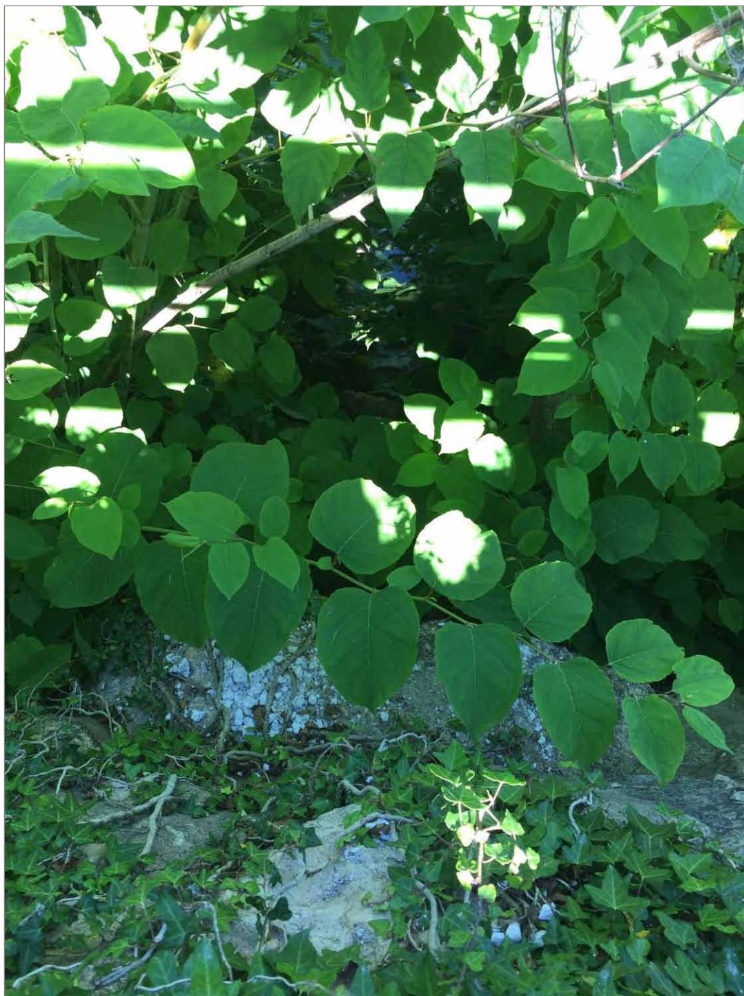
Fotografía 16. Punto de Vertido 2: Salida de la alcantarilla secundaria de achique, actualmente cubierta por vegetación.
