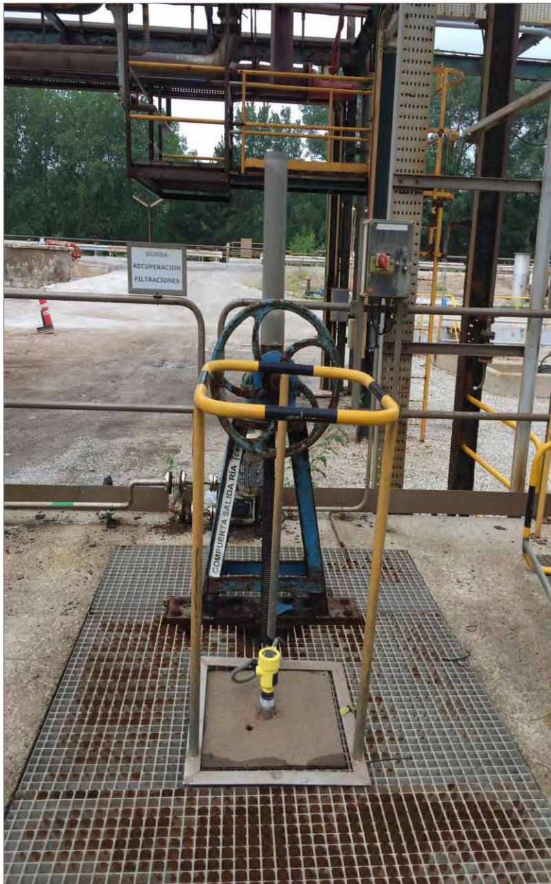
Fotografía 4. Compuerta general de cierre tipo canal (1,5 m x 1,6 m) existente sobre la alcantarilla general en el foso de bombeo a EDARI.
