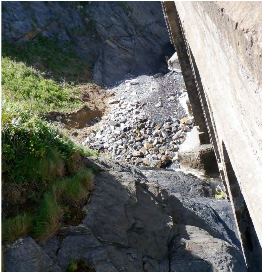
Figura 103. Tamaño de los cantos rodados en el entrante de costa en el lado tierra del viaducto de Mundaka.
