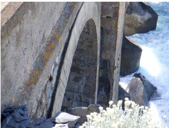
Figura 36. Bóveda de hormigón
