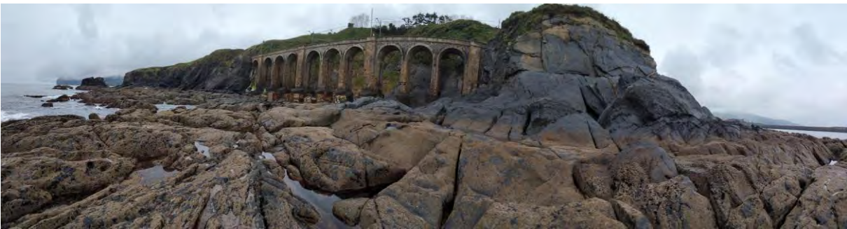
Figura 16. Cala donde se ubica el viaducto
