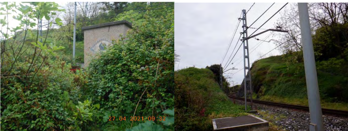
Figura 17. Acceso a plataforma
