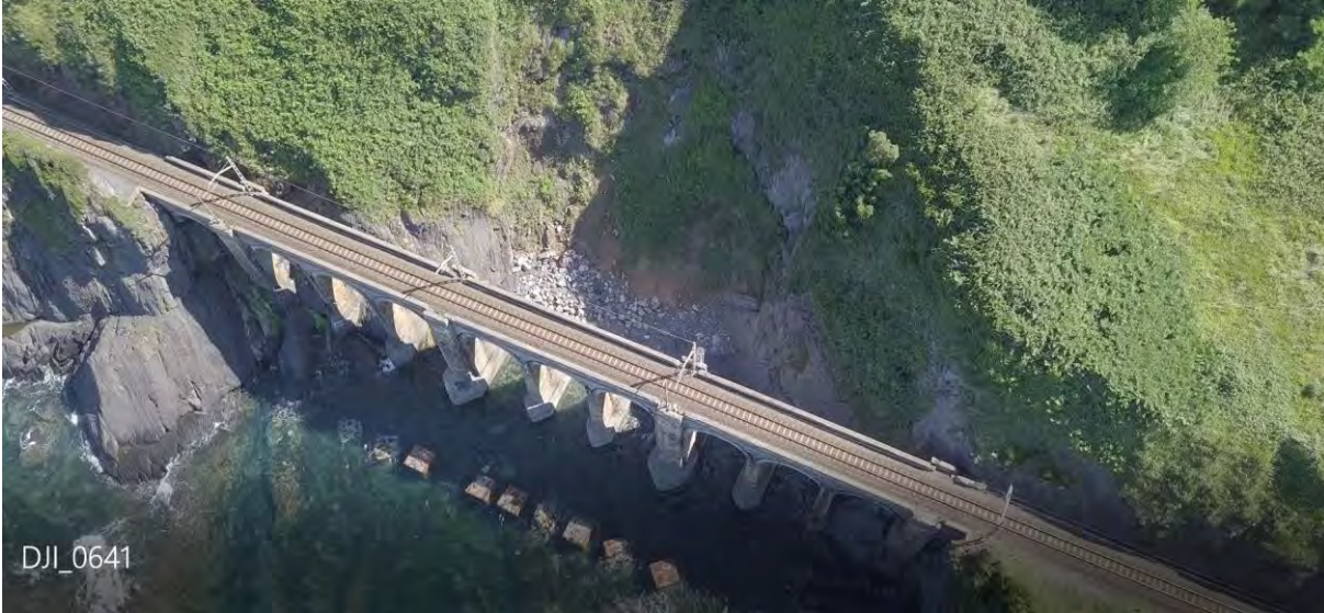
Figura 101. Ladera situada en el lado tierra del viaducto de Mundaka.
