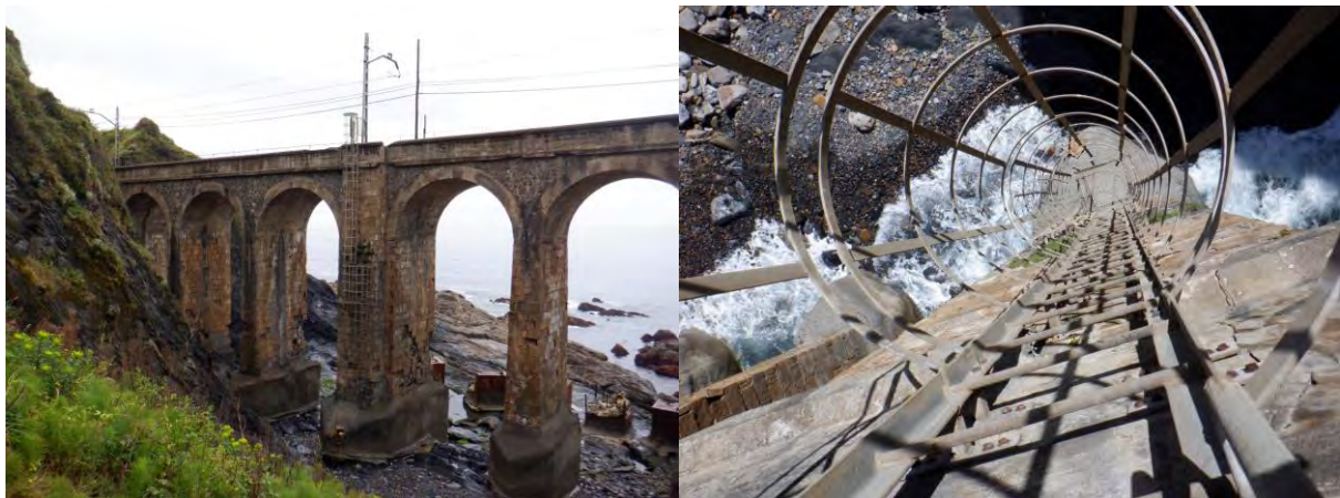
Figura 122. Escaleras acceso desde plataforma a cala.
