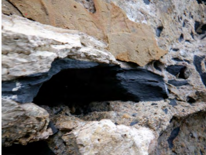
Figura 51. Cavidades en alzado (I)
