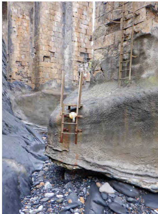
Figura 55. Escalera en canto de zapata
