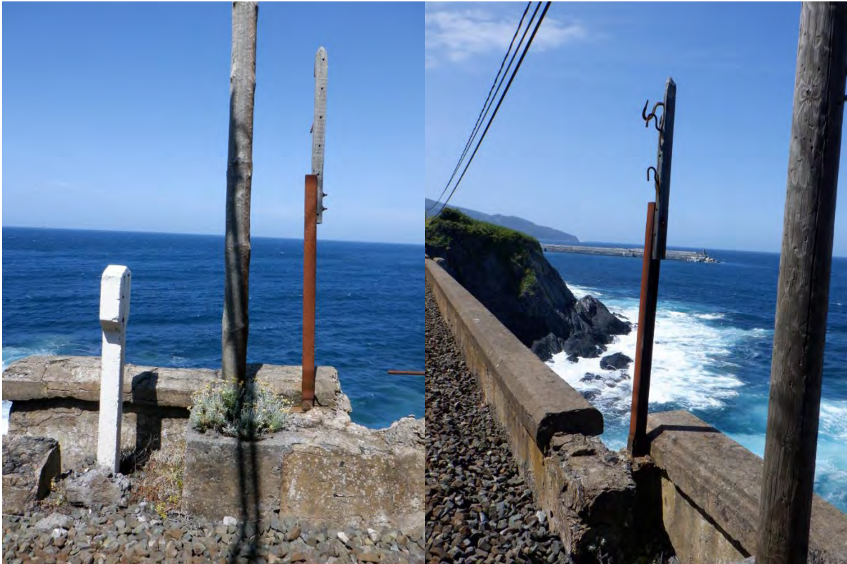
Figura 59. Elementos obsoletos existentes en superestructura
