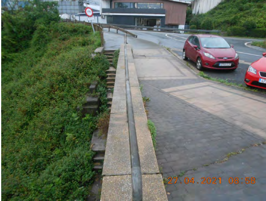
Figura 9. Acceso desde mirador a itinerario sobre emboquille
