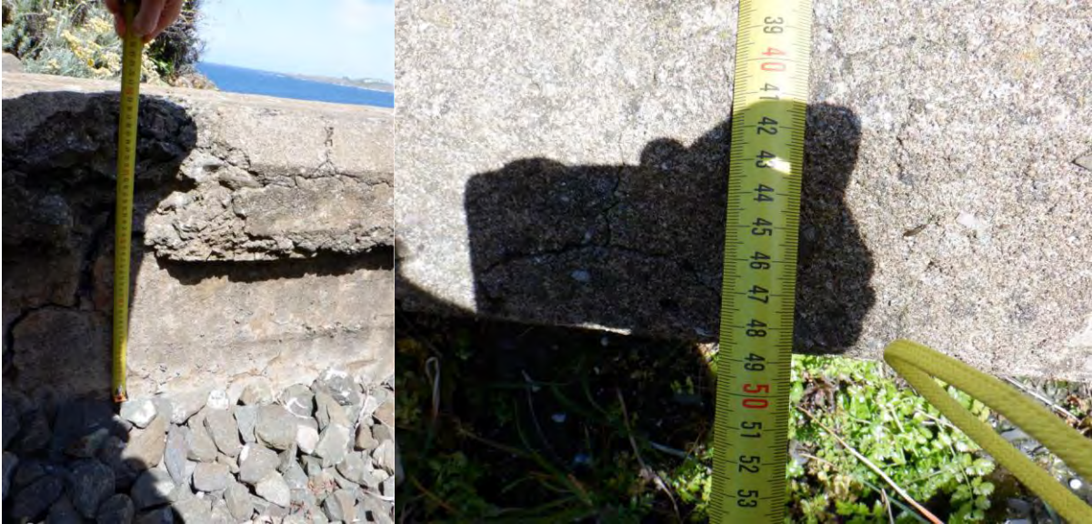
Figura 40. Acotaciones murete guardabalasto
