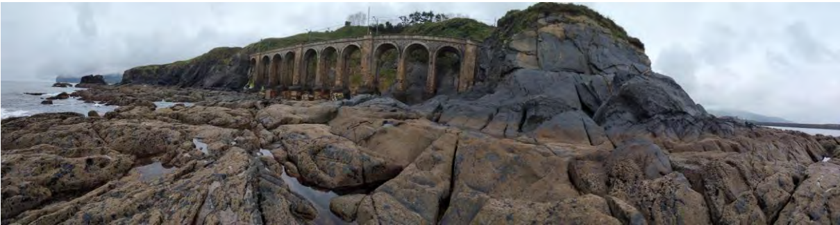
Figura 120. Cala donde se ubica el viaducto.
