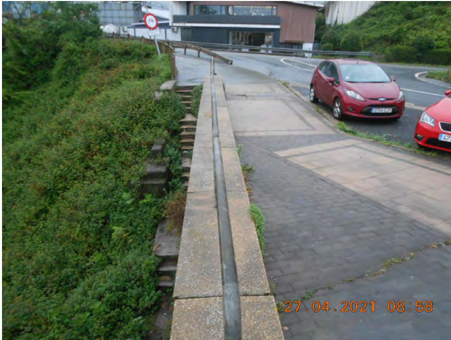
Figura 113. Acceso desde mirador a itinerario sobre emboquille.
