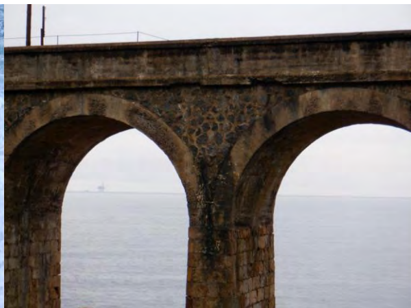
Figura 37. Bóveda y tímpanos
