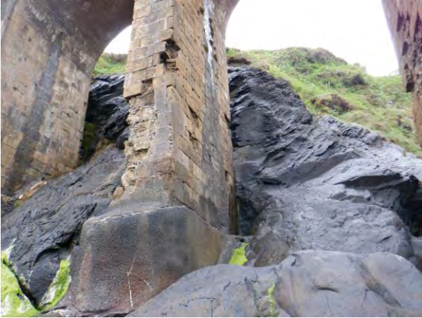
Figura 29. Detalle cimentación P2
