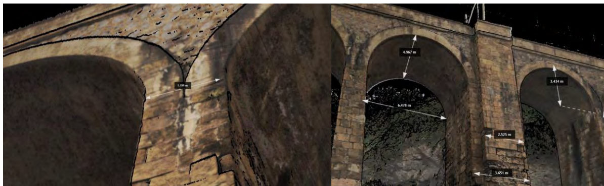
Figura 32. Acotación cabeza de pila
