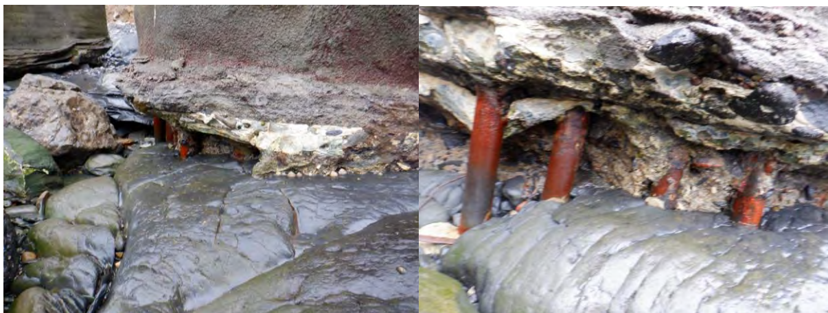
Figura 42. Micropilotes vistos en pila 6
