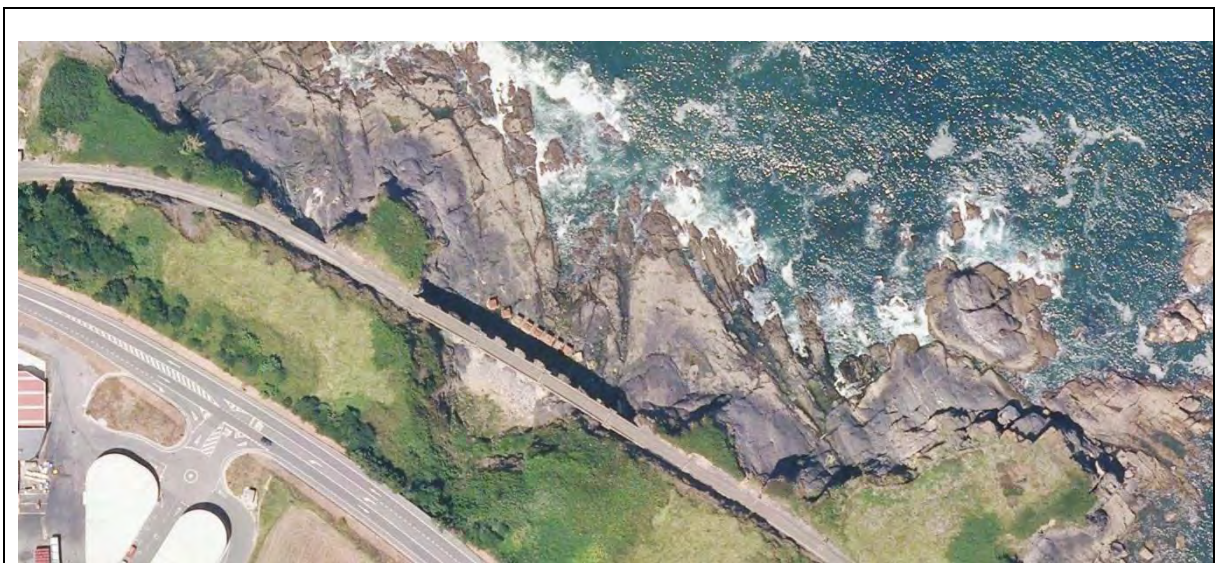
2012. Bloques de protección anclados al sustrato rocoso. Se mantiene la vegetación en la parte inferior de la ladera.
