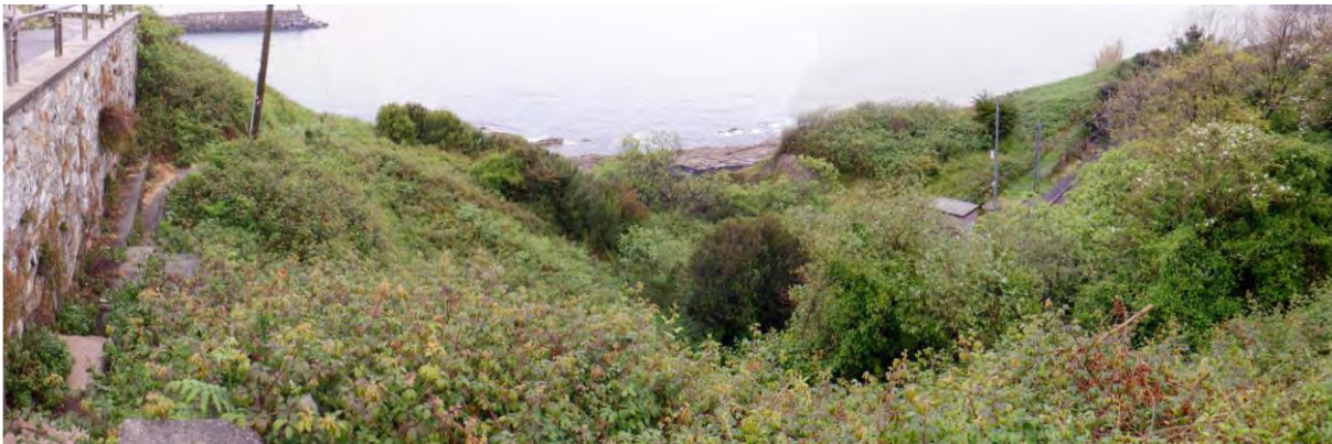
Figura 114. Panorámica desde acceso a camino sobre emboquille.
