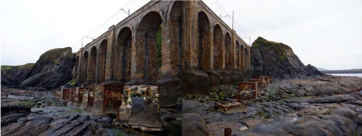
Figura 61. Aspecto de bloques frente al oleaje
