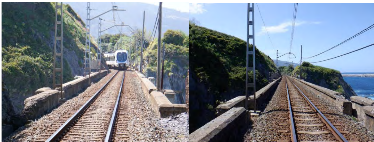
Figura 38. Vista desde tablero
