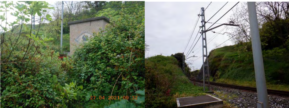
Figura 121. Acceso a plataforma.
