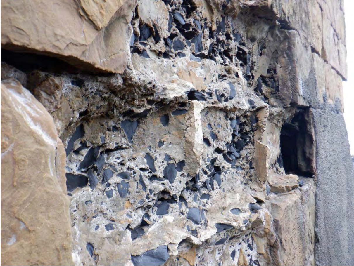
Figura 35. Aspecto interior de las pilas
