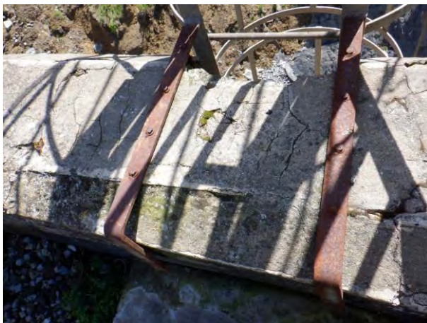
Figura 53. Unión en coronación
