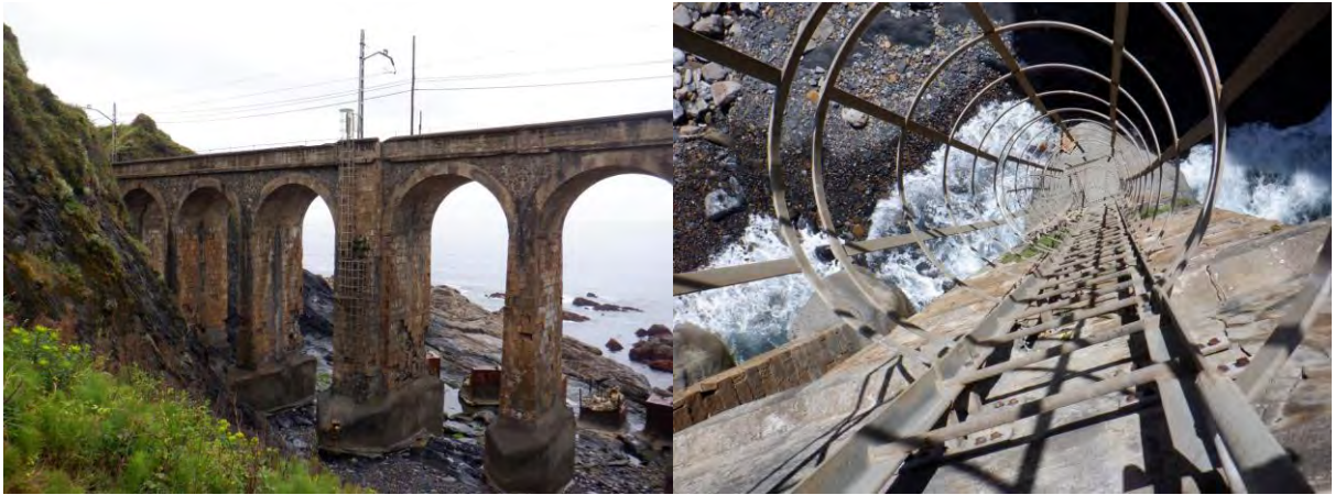
Figura 18. Escaleras acceso desde cala a plataforma
