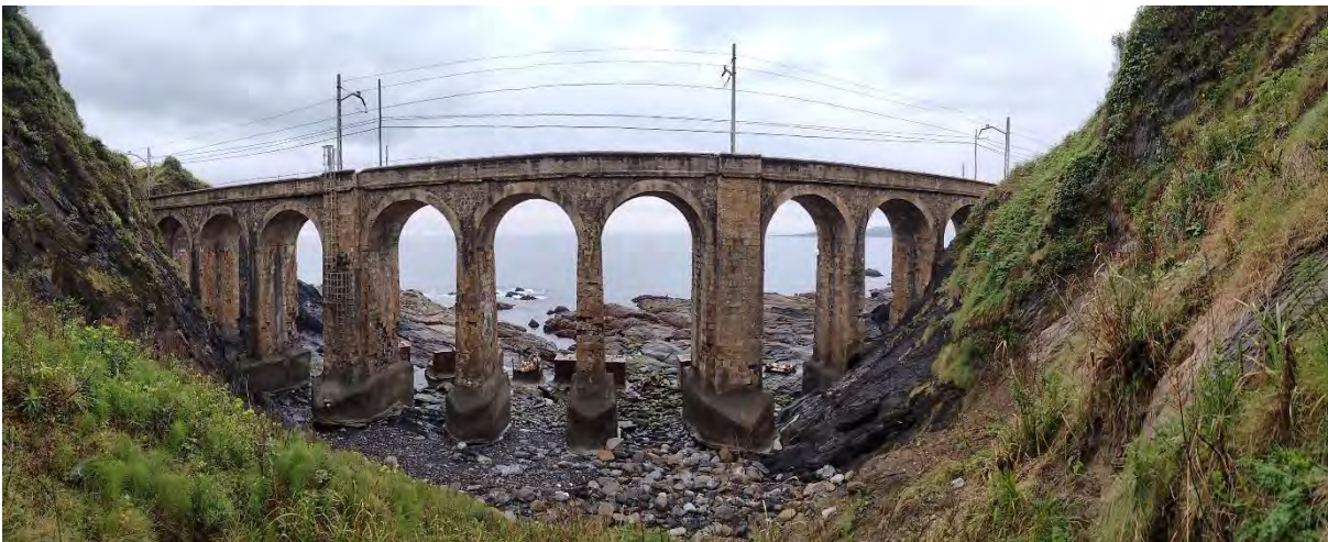
Figura 102. Entrante de costa en el lado tierra del viaducto de Mundaka.
