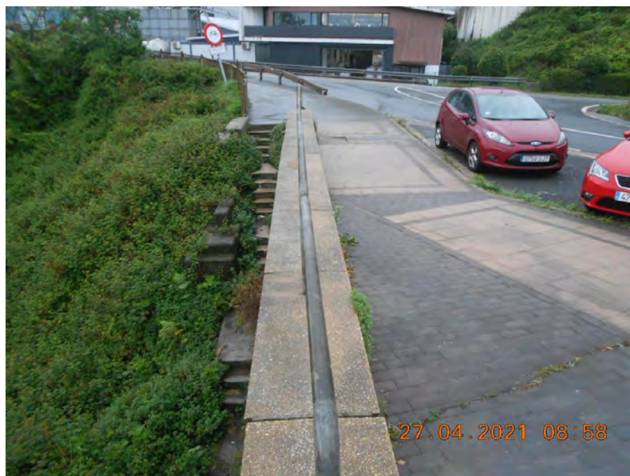
Figura 112. Zona de entronque entre la BI-2235 y el nuevo camino de acceso a la plataforma.
