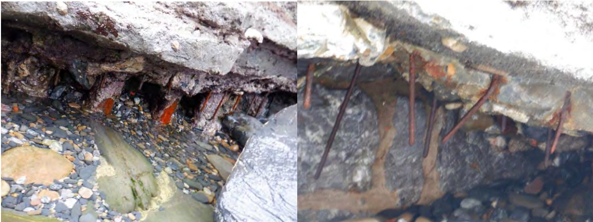
Figura 44. Micropilotes vistos en pila 7, junto a zócalo de cimentación y barras enresinadas en 2004
