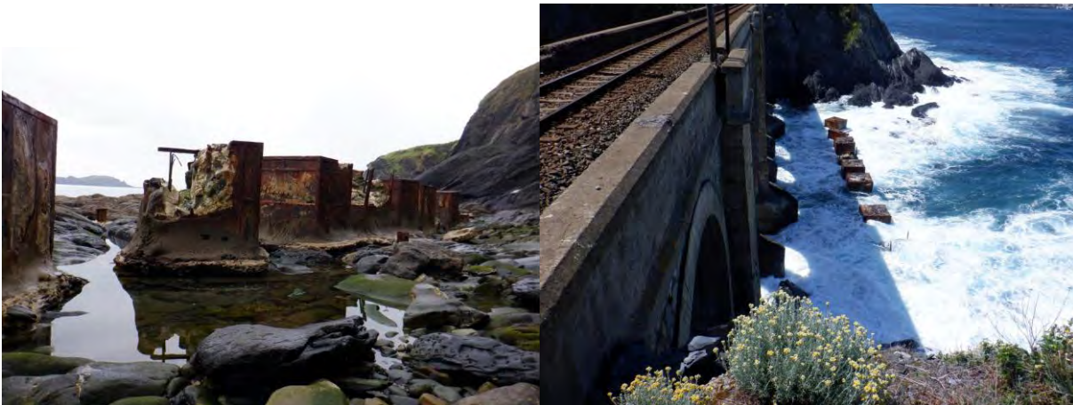
Figura 62. Aspecto de bloques frente al oleaje Figura 63. Rebase de bloques por el oleaje
