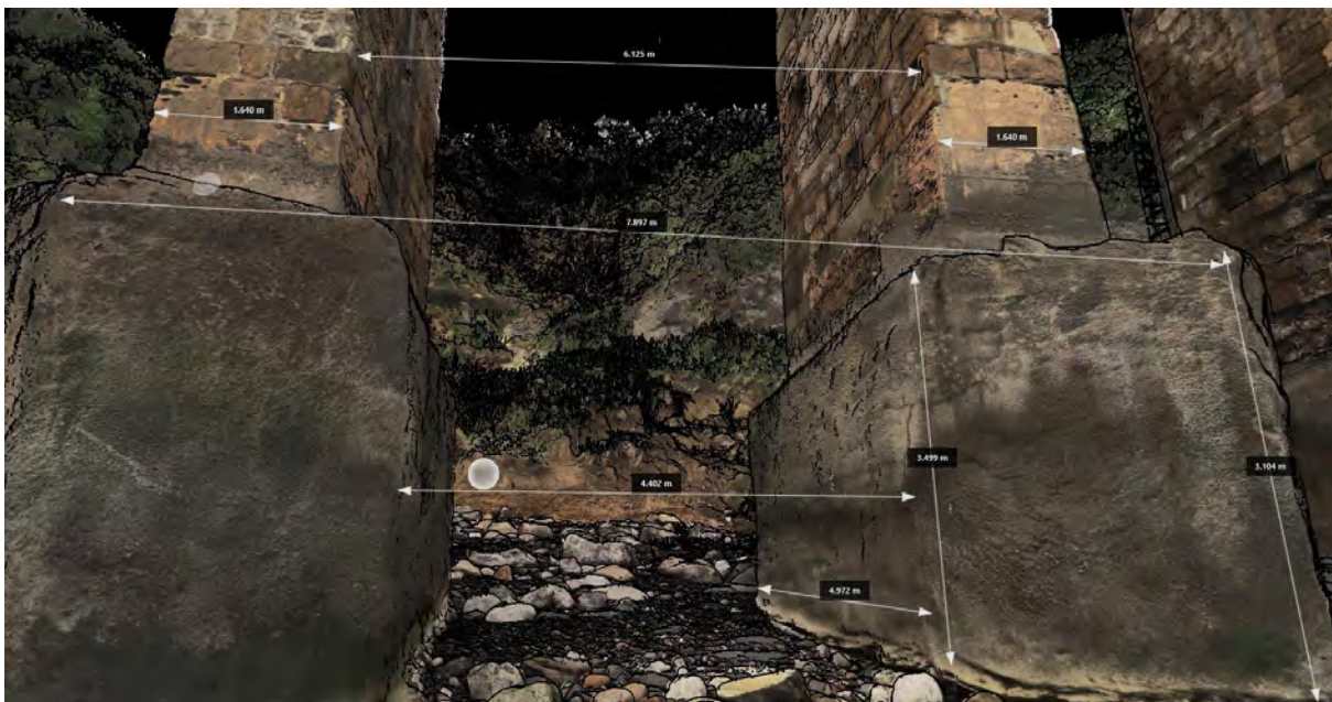
Figura 23. Acotaciones cimentaciones centrales
