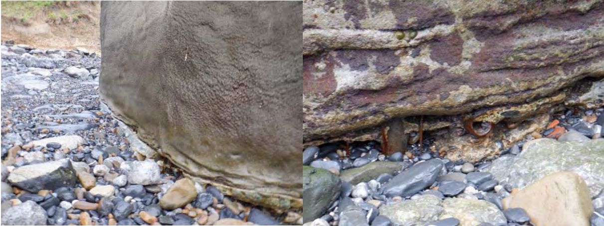
Figura 43. Armadura enresinada a terreno, en pila 5
