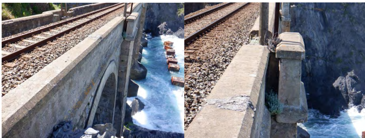
Figura 39. Detalle de muretes guardabalasto
