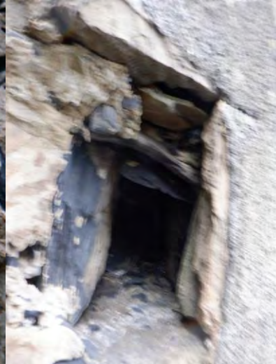
Figura 52. Cavidades en alzado (II)
