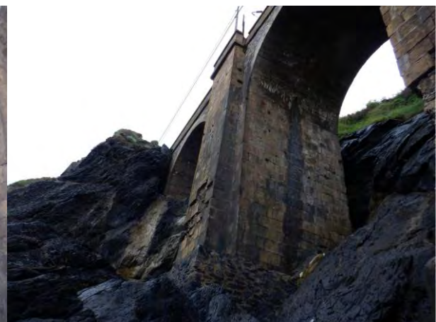
Figura 28. Detalle cimentación P1
