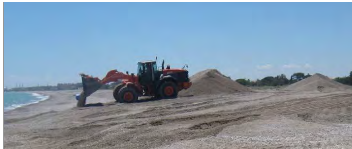
Ilustración 16. Redistribución de arenas en la playa de Almadá. Fuente: Demarcación de Costas en Valencia, 2020.
