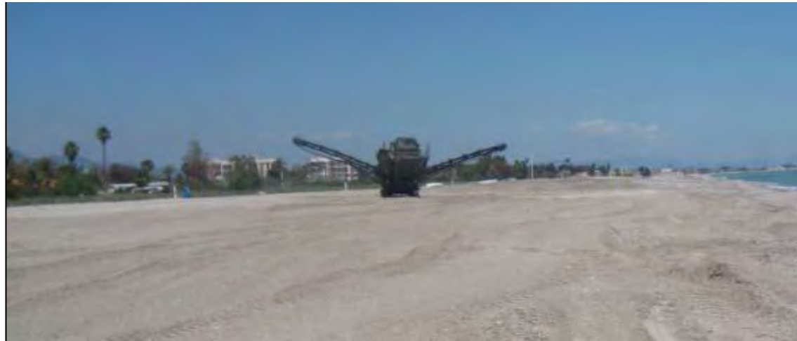
Ilustración 15. Cribadora móvil utilizada para la gestión de gravas en la zona de proyecto. Fuente: Demarcación de Costas en Valencia, 2020.
